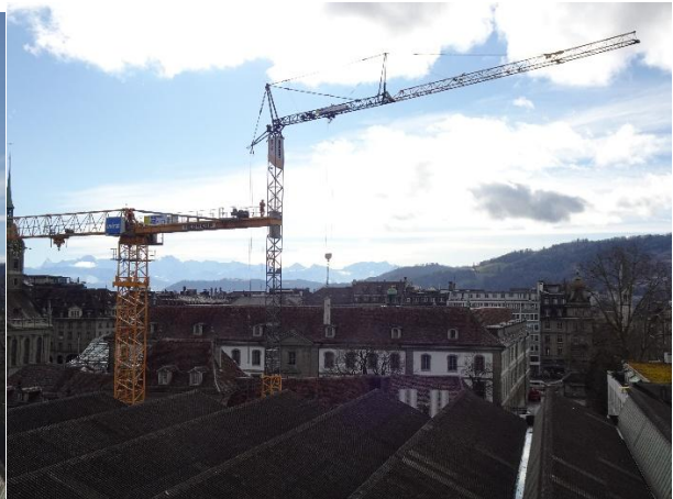
weitere Gegenballastplatten einsetzen
