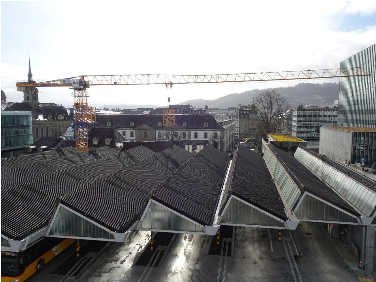
erstes Turmelement bereits aufgesetzt, das zweite als Gewichtsausgleich am Haken
