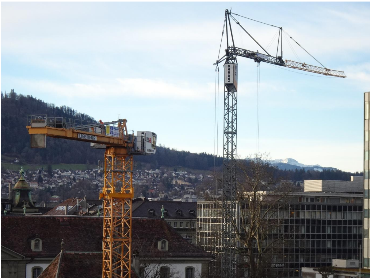
erste Gegenballastplatte eingesetzt
