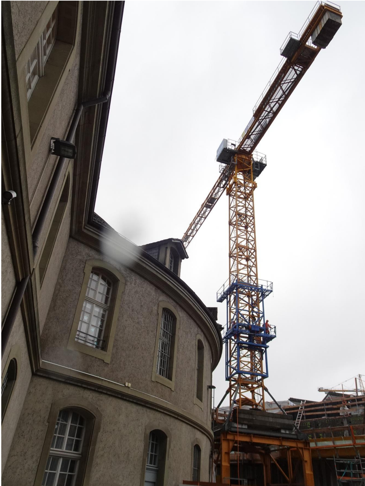
Das Klettergerüst wurde wieder abgelassen und demontiert.
