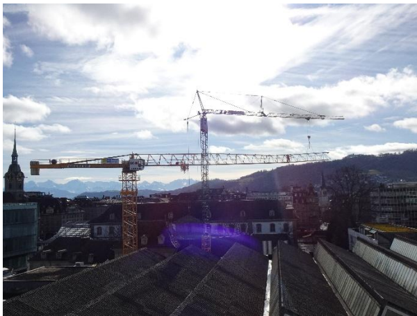
weitere zwei 10m-Elemente ansetzen (Gesamtlänge des Auslegers nun 54m), die letzten mit dem Kran
