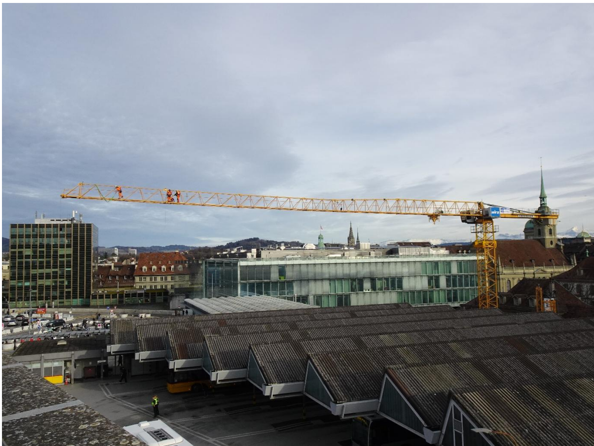
der vollständige Ausleger (65m) ist montiert.
