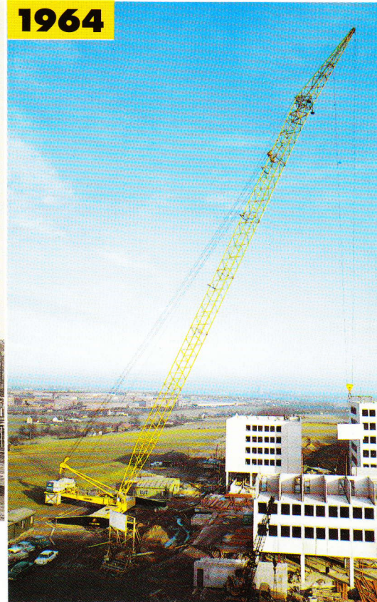
Form 500 Baujahr 1964. Ein Auslegerkran mit großer Reich- weite und hoher Tragfähigkeit.
