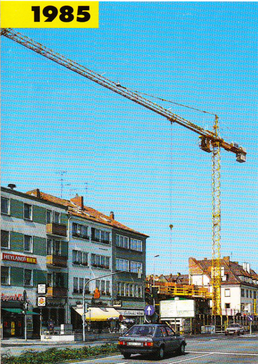
EC- und MK-Krane Baujahr 1985. Vorstellung des ersten EC-Kranes, speziell konzipiert für den Einsatz auf engen Baustellen und Baulücken sowie Einführung des MK 52.
