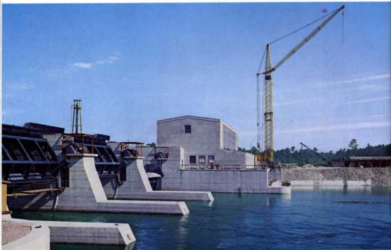
LIEBHERR-Turmdrehkran Form 35 A/45 beim Bau einer Donau-Staustufe. — Die Teleskopdrehsäule ermöglicht auch bei niedrigen Bauwerken einen rationellen Einsatz.
