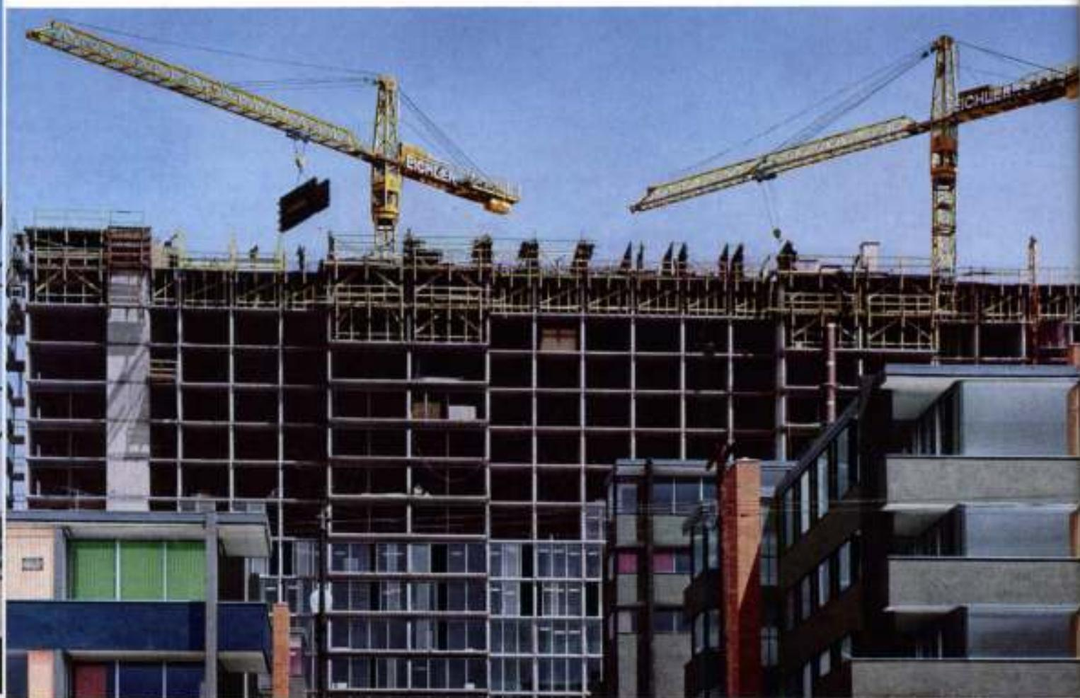
2 LIEBHERR-Turmdrehkrane Form 110 C/133 bei einem Großbauvorhaben in San Francisco. Die LIEBHERR-Turmdrehkrane der Baureihe C/CS werden bis zu 250/320 mt gefertigt. Darüber hinaus Sonderkonstruktionen auf Anfrage.
