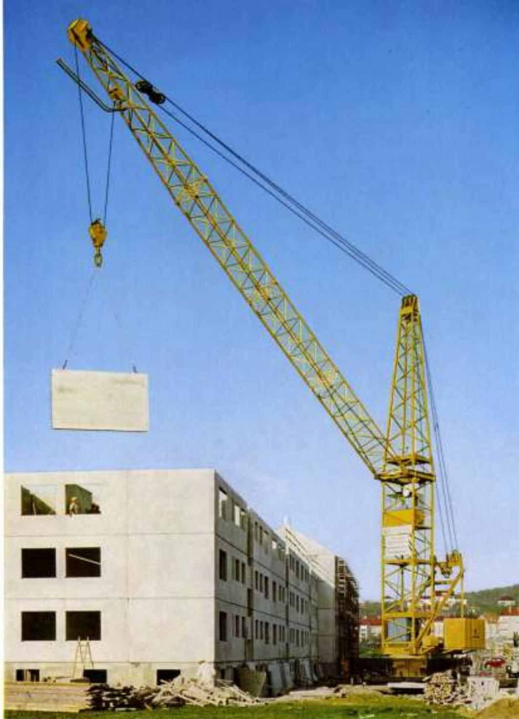
Der LIEBHERR-Turmdrehkran Form 170 wurde für die Fertigteil-Bauweise entwickelt. Er eignet sich für die Verlegung schwerster Bauteile. Bei einer Ausladung von 10 – 26 m hat er eine Tragkraft von 6.500 – 14.700 kg.
