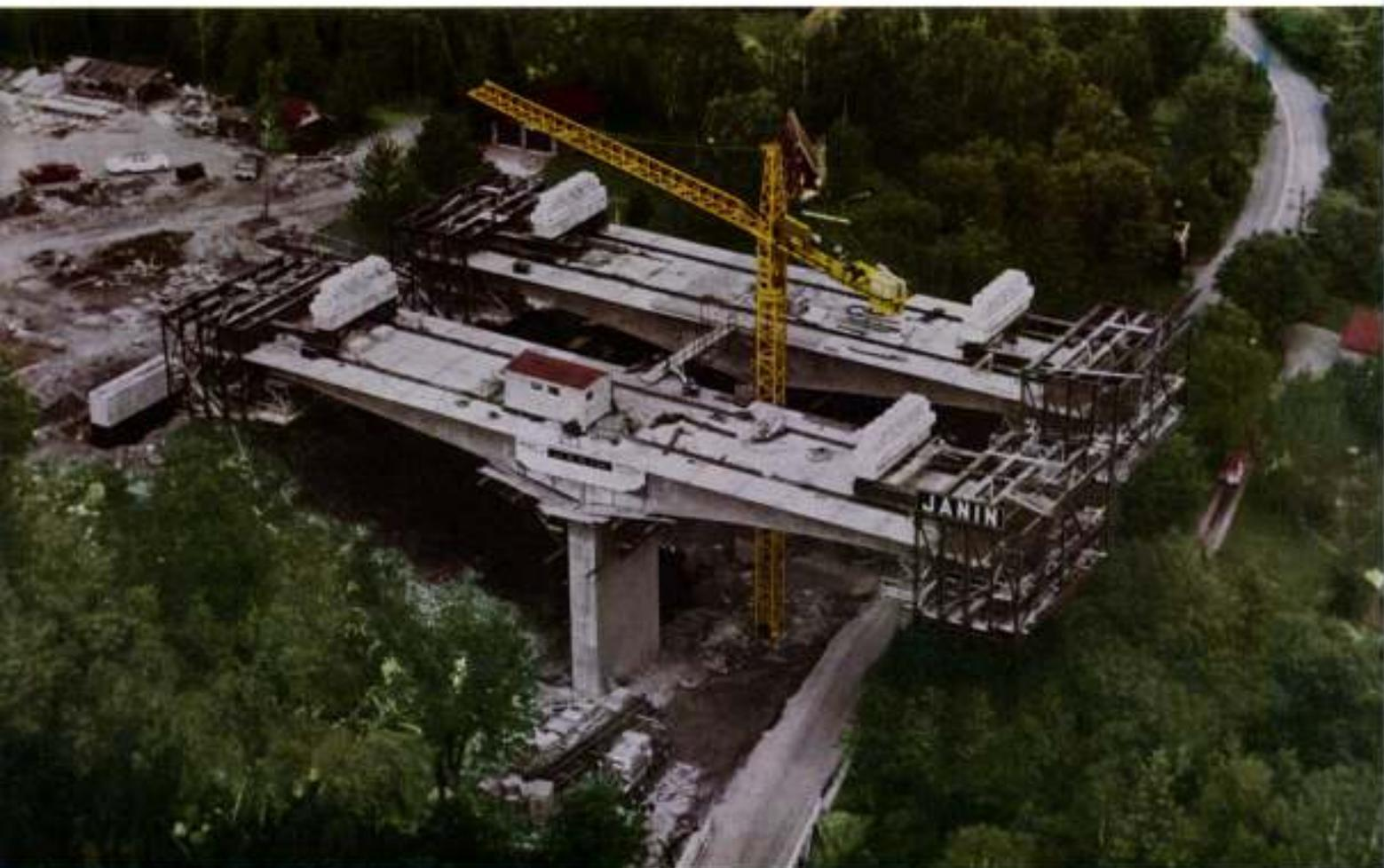
**LIEBHERR-Turmdrehkran Form 65 C/83 beim Bau einer Straßenbrücke in Kanada. – Auch die Krane der Baureihe C/CS mit Katzausleger können wahlweise als schienenfahrbare Krane, als Kletterkrane innerhalb des Gebäudes oder als stationäre Krane auf einem Fundament verankert, eingesetzt werden.**
