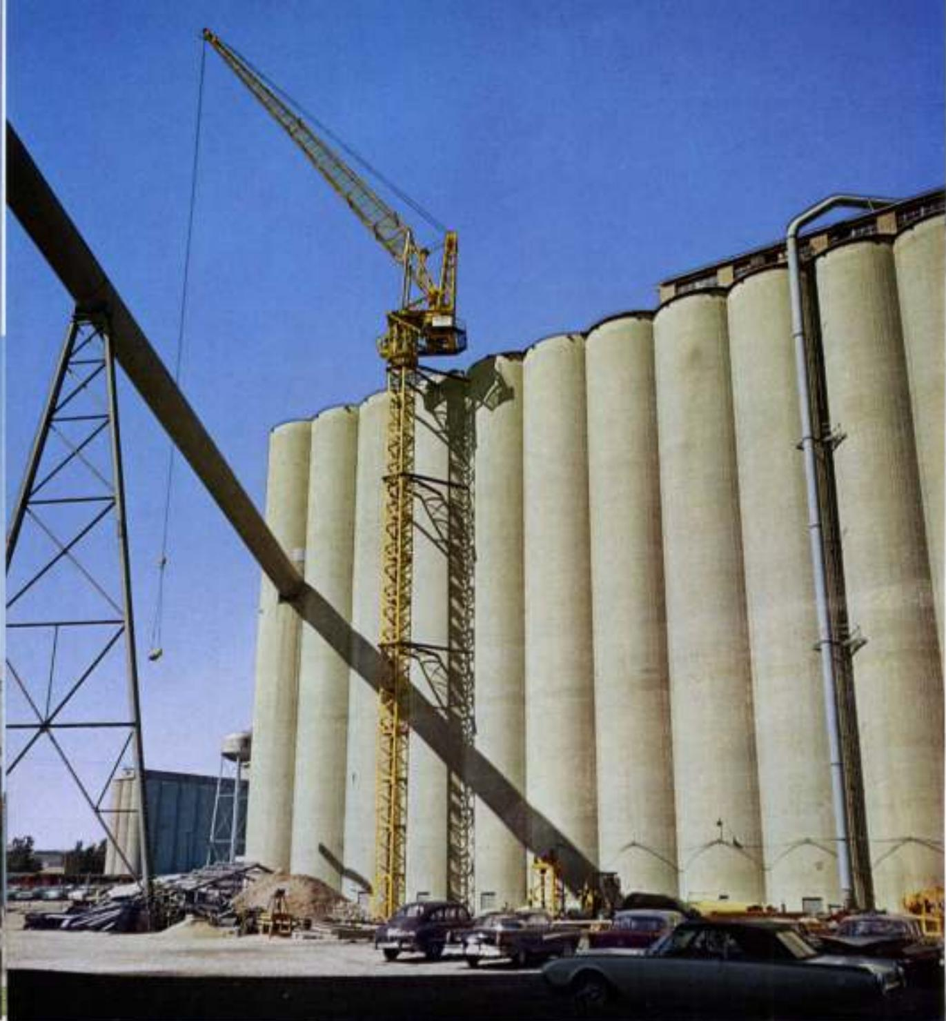
**LIEBHERR-Kletterkran Form 50 HB eingesetzt beim Bau von Silos in den USA. Die Verankerung am Gebäude ermöglicht unbegrenzte Bauhöhen.**
