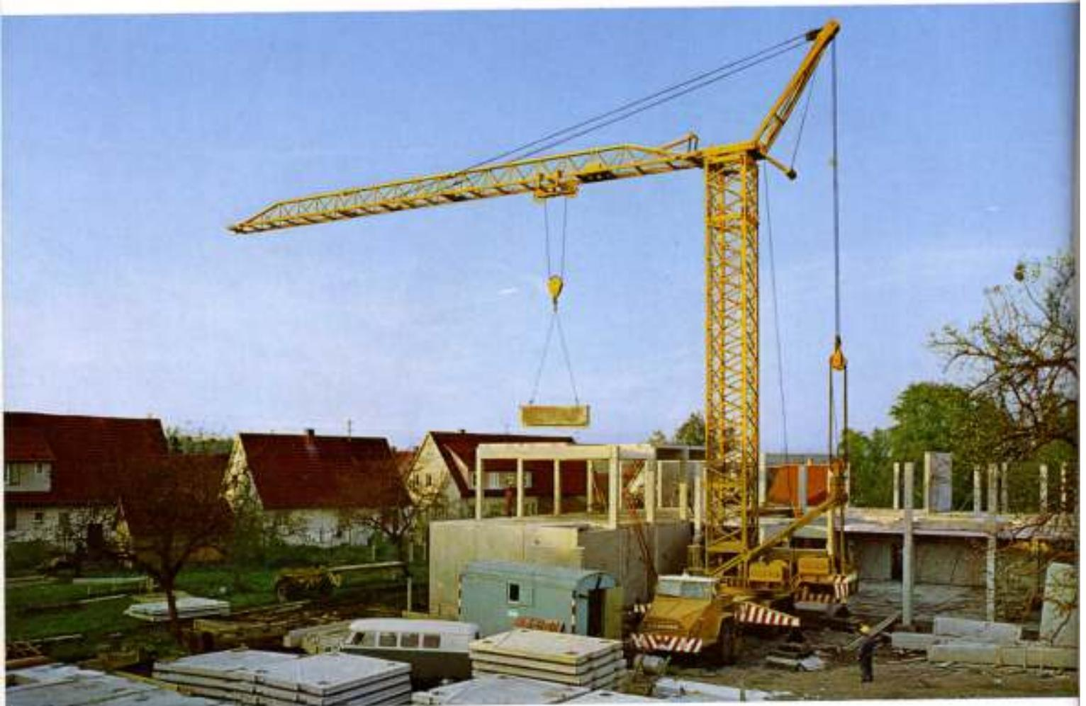
Der LIEBHERR-Autokran Form AUK 120 hat alle Vorzüge eines schweren Turmdrehkranes. In der Fertigteil-Bauweise findet er ein ideales Anwendungsgebiet. Der schnelle Baustellenwechsel ist ein besonderer Vorteil dieses Kranes.
