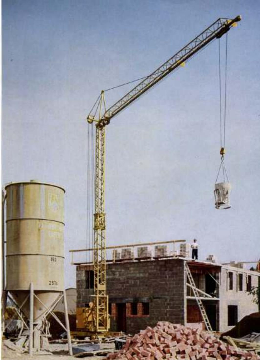
**Der LIEBHERR-Turmdrehkran Form 10 K ist das Gerät für kleinere Bauunternehmer. Der Kran gestattet einen einfachen und raschen Straßentransport und ist dadurch in kürzester Zeit einsatzbereit. Der Ausleger ist als Laufkatzen- und verstellbarer Ausleger ausgeführt.**
