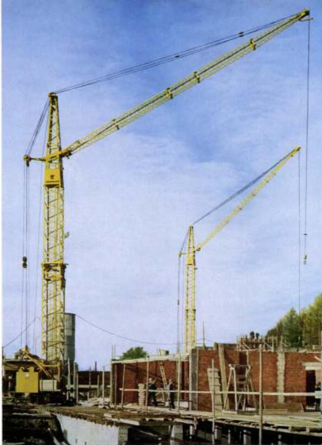
Die LIEBHERR-Turmdrehkrane Form 25 A/30 und Form 30 A/35 sind Serienkrane der Mittelklasse. Aufgrund ihrer Teleskopierbarkeit sind sie auf Baustelle und Straße gleich beweglich und auch zur Durchführung kleinerer Projekte geeignet.
