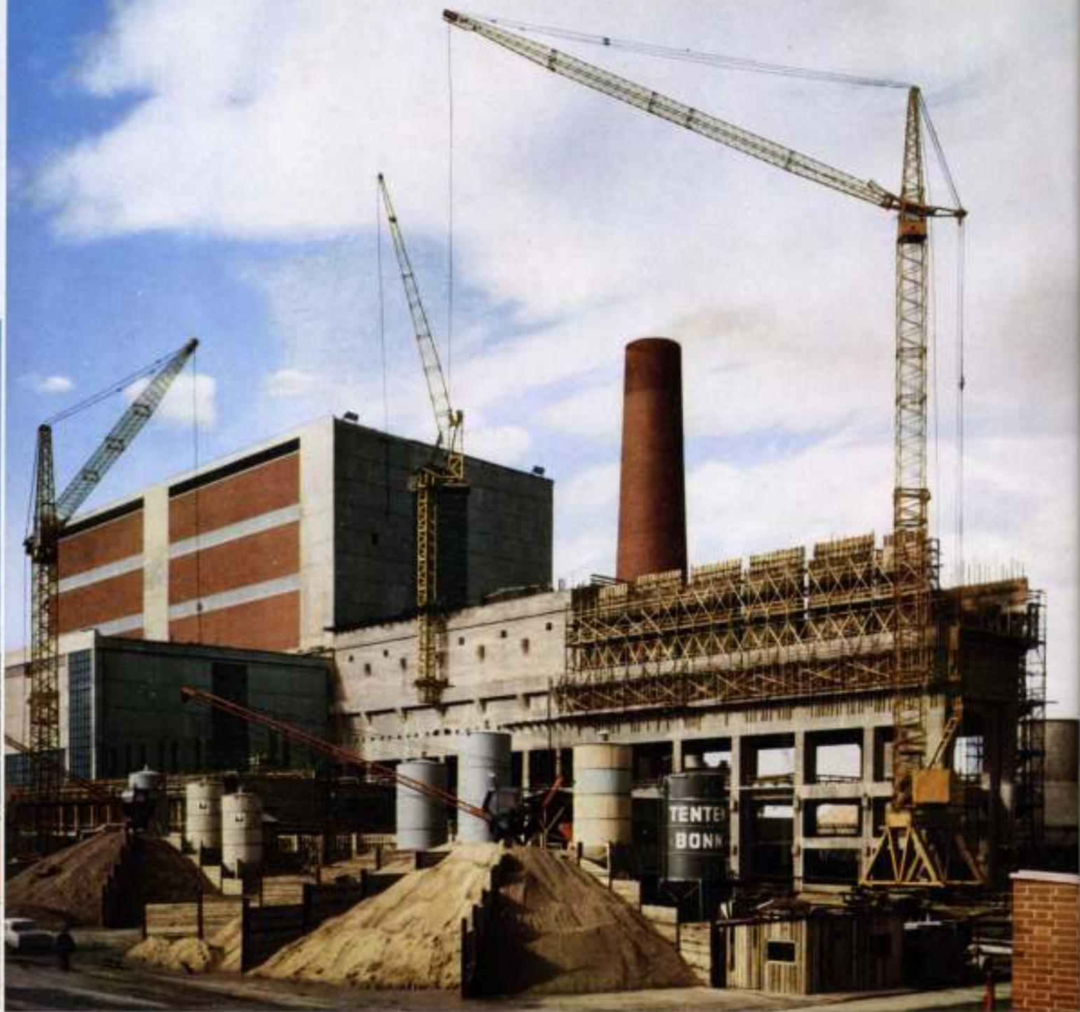
LIEBHERR-Turmdrehkrane Form 35 A/45, Form 56 A/72 mit Portal (Sonderausführung) und LIEBHERR-Kletterkran Form 36 HB beim Bau eines Kraftwerkes im Rheinischen Braunkohlenrevier. Wegen der beengten Baustellenverhältnisse mußte der Kletterkran Form 36 HB außen am Gebäude verankert werden. Für den vielseitig verwendbaren LIEBHERR-Kletterkran ist auch dieser Einsatz kein Problem.
