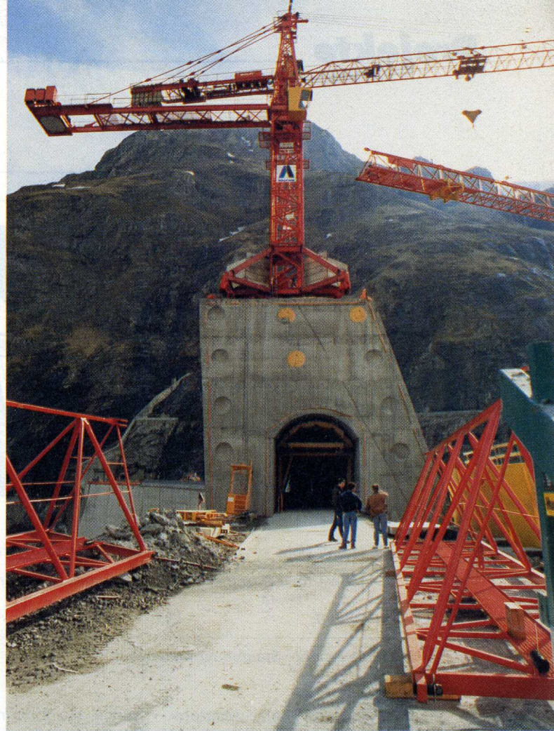
Montage der beiden Wolff-System-Laufkatzenkrane WK 500 SL und WK 523 SL. Der Ausleger des zweiten Krans wird mit dem ersten Kran montiert.
