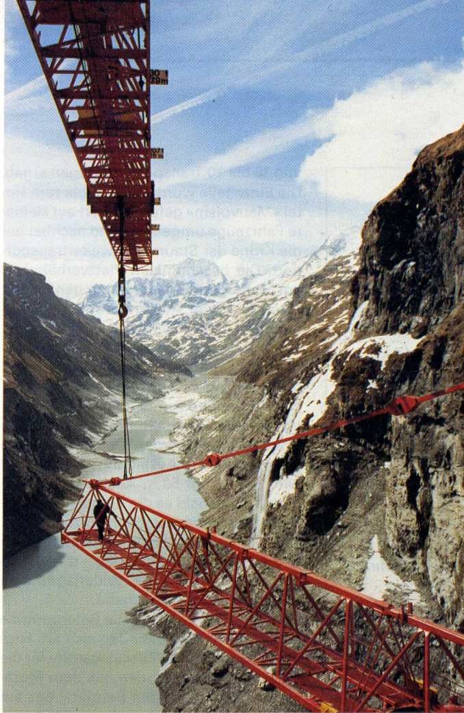
Montage der beiden Wolff-System-Laufkatzenkrane WK 500 SL und WK 523 SL. Der Ausleger des zweiten Krans wird mit dem ersten Kran montiert.
