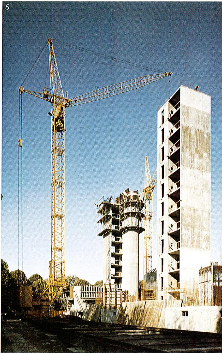
5-8 a je nach Einsatzerfordernis optimale Bauwerksanpassung von Auslegerlänge und Turmhöhe, große Hubhöhe durch Ausleger-Steilstellung, mit voller Last frei verfahrbar
