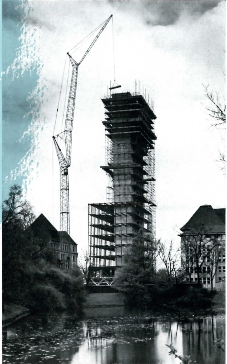
PEINER Kran Typ 921 H, der höchste fahrbare Turmdrehkran der Welt beim Bau eines 98 m hohen Hochhauses
