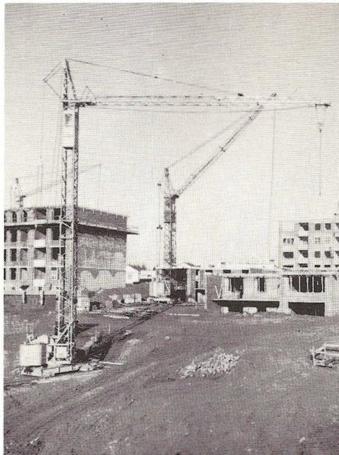
Das Laufkatzen-Kran-Programm von PEKAZETT bietet Leistungsgrößen von 20 bis 34 mto. Bei kleinstmöglicher Straßentransportlänge verfügen sie über Hakenhöhen, die ihren Einsatz beim Hochhausbau ermöglichen. Auf- und Abbau dieser Schnellmontage-Krane erfolgt ferngesteuert auf Flurniveau. Die systemstabilisierende Seilparallelführung gibt diesen Kranen eine außergewöhnliche Standruhe.
