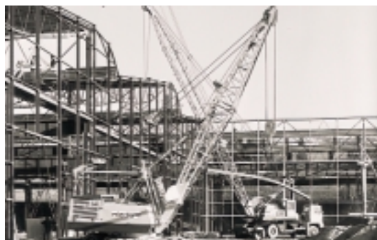
Construction du site de Loirecord
