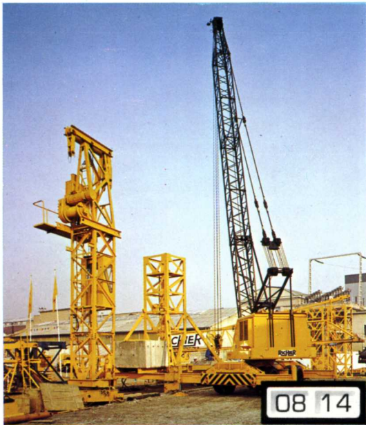
← Aufbau des Kranunterteils
