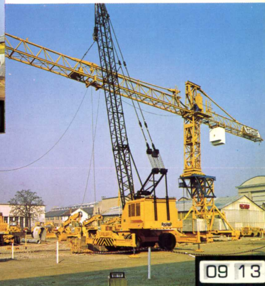
▼ Anbringen des Katzauslegers 30 m Länge
