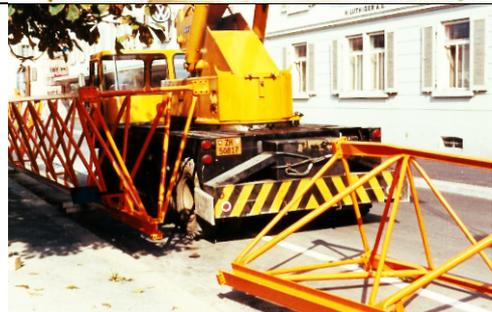
Der Ausleger wurde am Boden montiert und das Seil der Laufkatze eingezogen und gespannt. Der umgekehrte Ausleger war statisch sehr gut, war aber bei der Montage und der Demontage für die Kranmonteure sehr gefährlich, weil die Gefahr des Umkippen sehr gross war.
