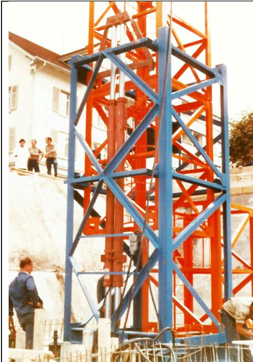
Die Hydraulik am Kletterwerk wirkte sowohl nach unten als auch nach oben, was die Geschwindigkeit erhöhte.
