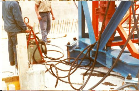
Das Hydraulikaggregat mit den Steuerhebeln war auf der linken Seite. Hier wurde das Klettern in Bodennähe gesteuert.
