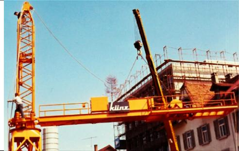
Der obere Teil des K 60 wurde von Hand gegen die Strasse gedreht und so konnte der kleine Pneukran den Gegenausleger mit etwas Reserve in der Ausladung und Höhe montieren und zur Verbolzung der Auslegerhalteseile am Gegenausleger den Gegenausleger überziehen.
