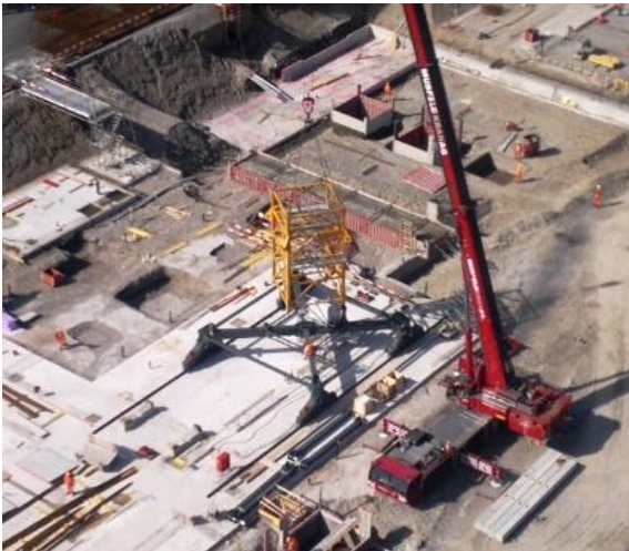
Montage des Unterwagen Turmstücks. Gewicht 13.5 t.
