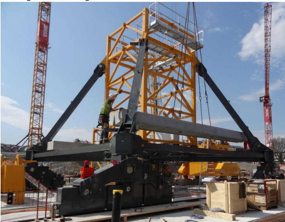
Ballastieren des Unterwagens mit 45 t Zentralballast.
