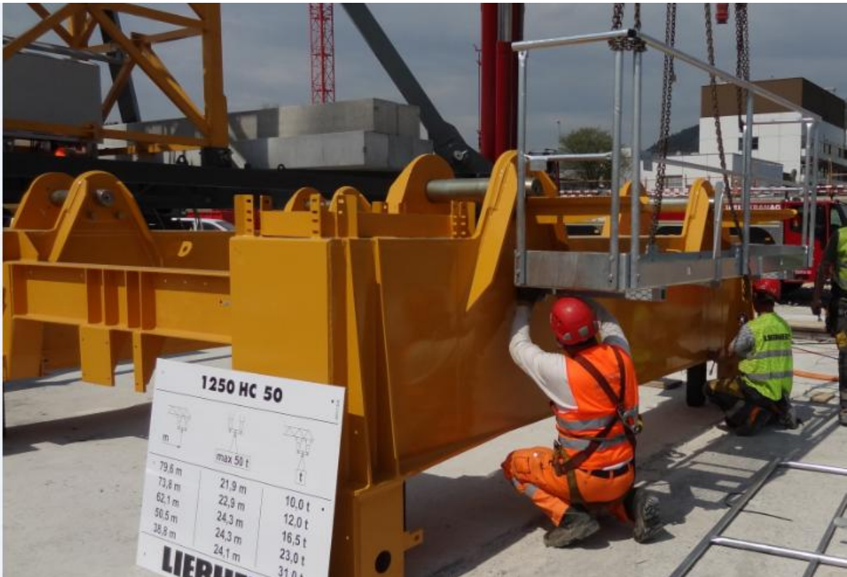
Vormontage des Drehbühnenunterteils. Gewicht 10.3 t.
