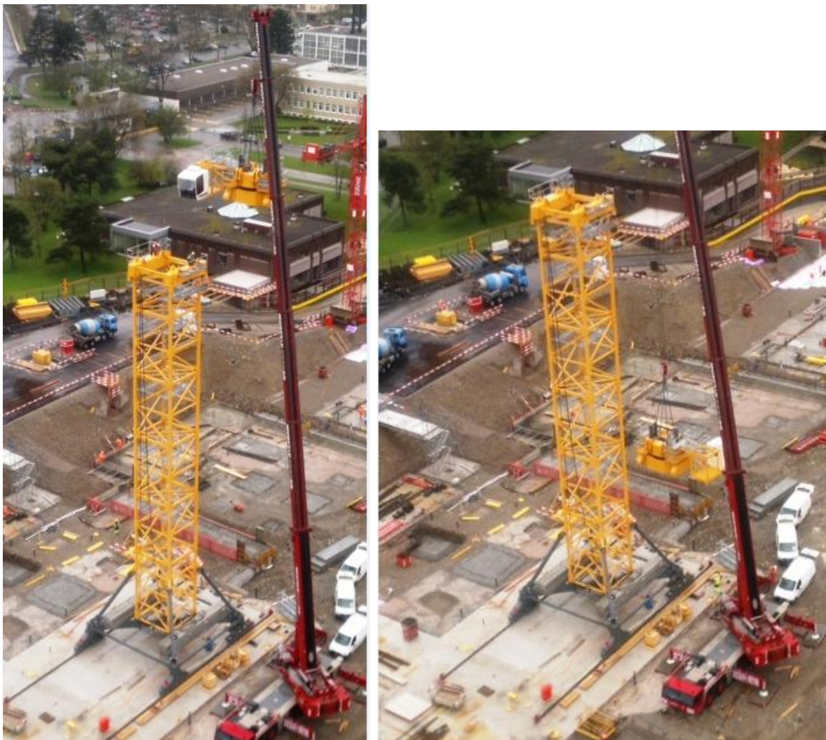
Montage der Drehbühne.
