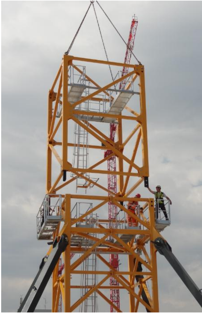
Montage des ersten 5.8 m langen Turmstücks. Gewicht 10.2 t.
