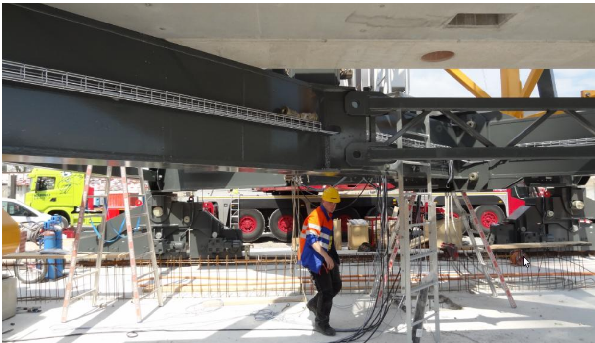
Verkabelungsarbeiten am Unterwagen.
