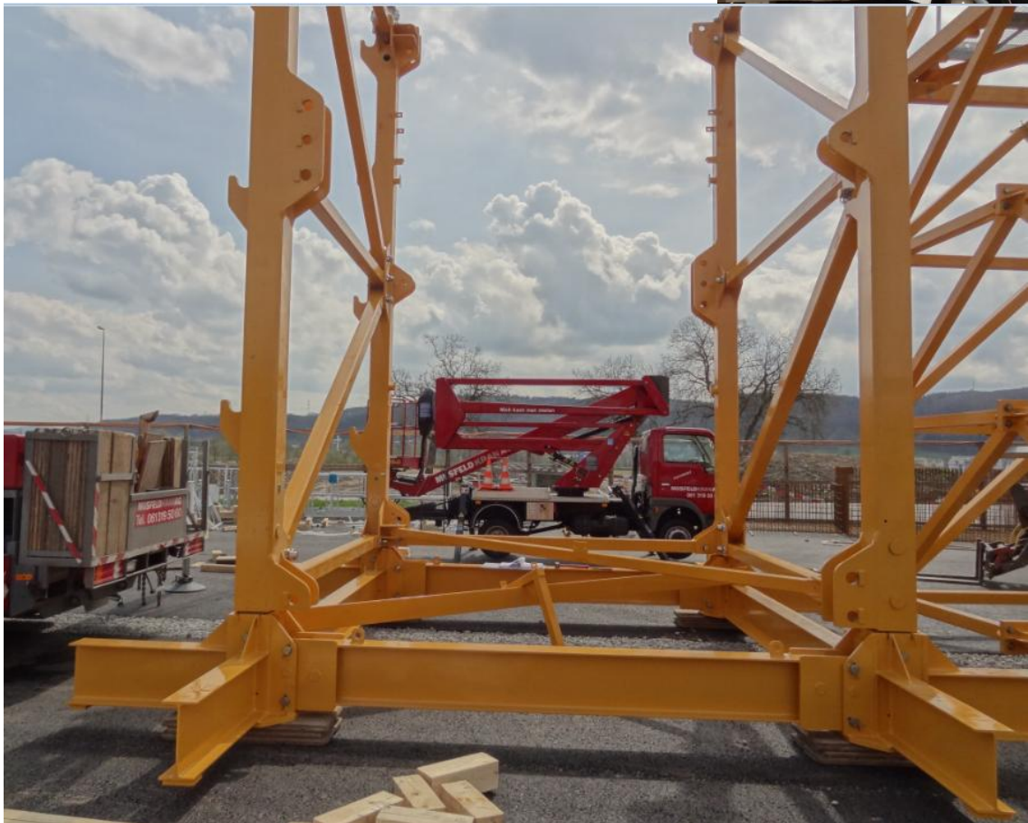
Vormontage der Turmstücke mit einer Lehre für einfacheres Zusammenbauen.
