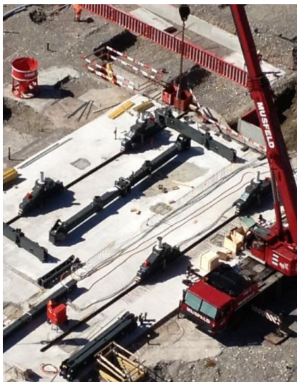
Montage der Fahrwerke und des Unterwagenkreuzes.
