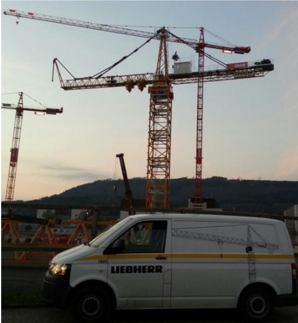
Der Grundauleger ist montiert. Gewicht 23.2 t.
