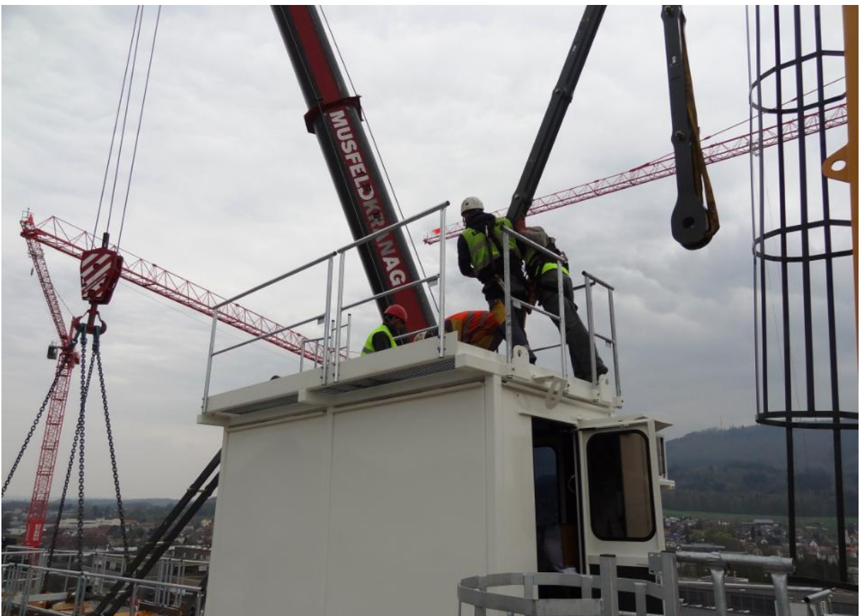
Verbinden der Abspannstangen.
