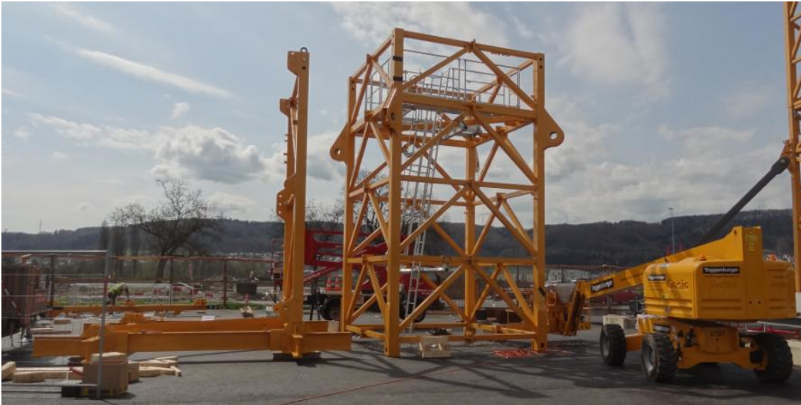
Vormontage des Unterwagen Turmstücks.
