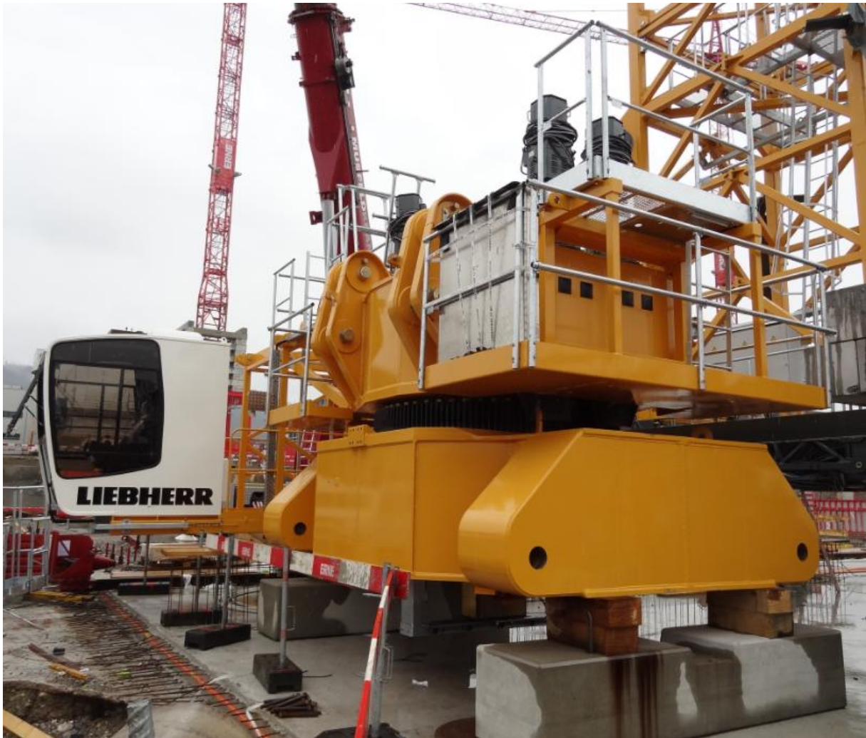
Vormontierte Drehbühne mit Kabine. Gewicht 34.3 t.
