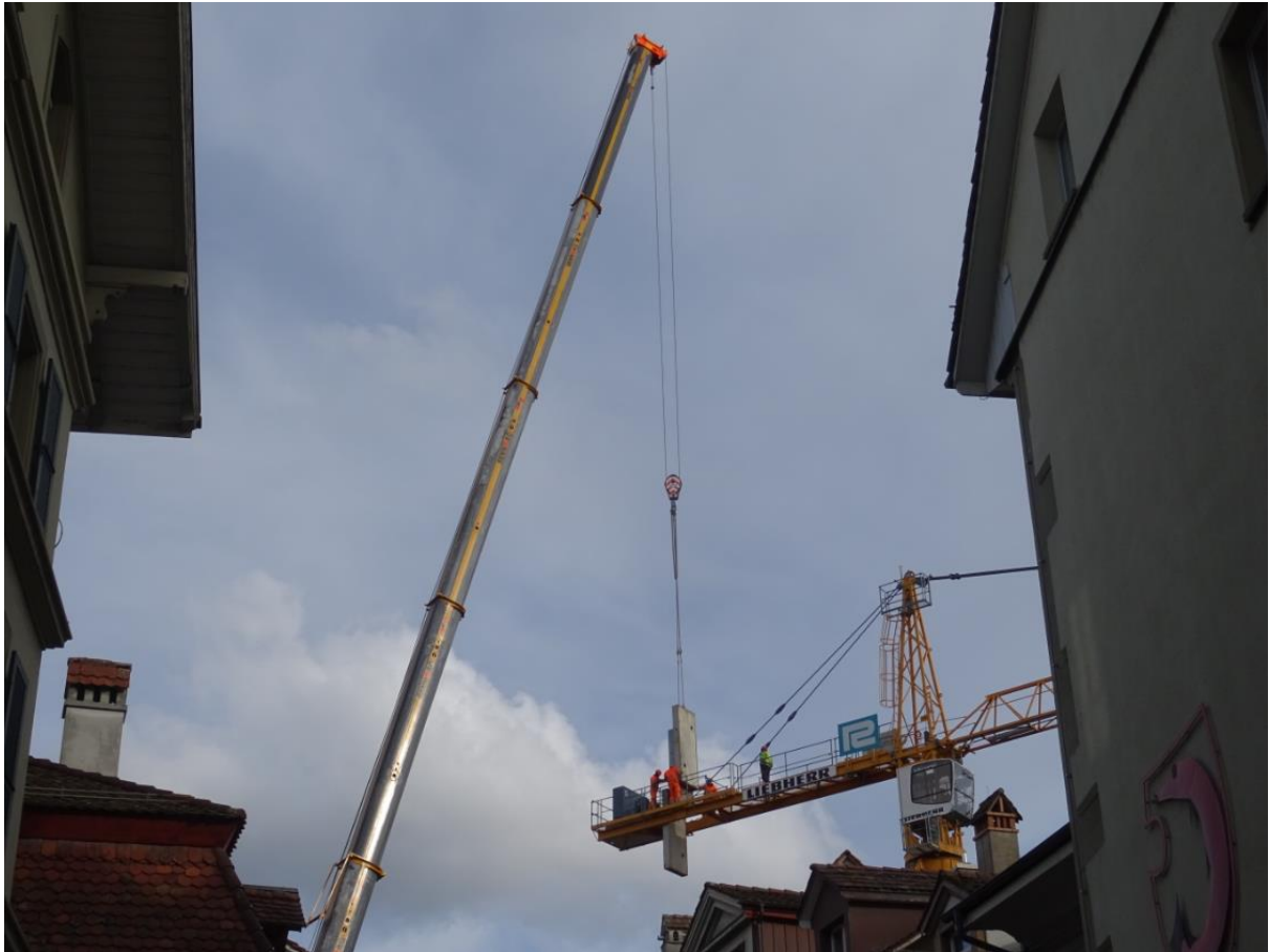
Einsetzen der weiteren 2 Gegengewichte aus der Sicht Rathausgasse....
