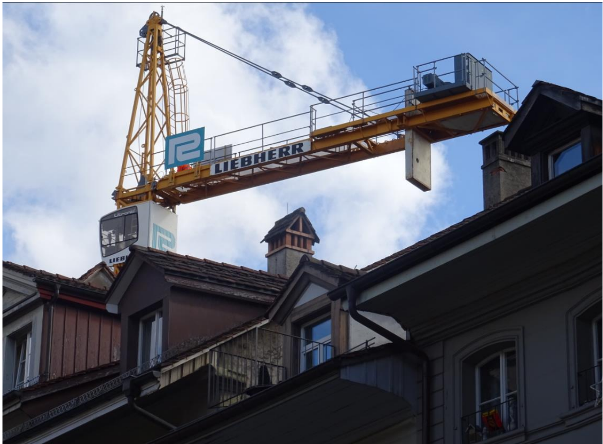
Vor der Montage des Auslegers musste ein Gegengewicht eingehängt werden.
