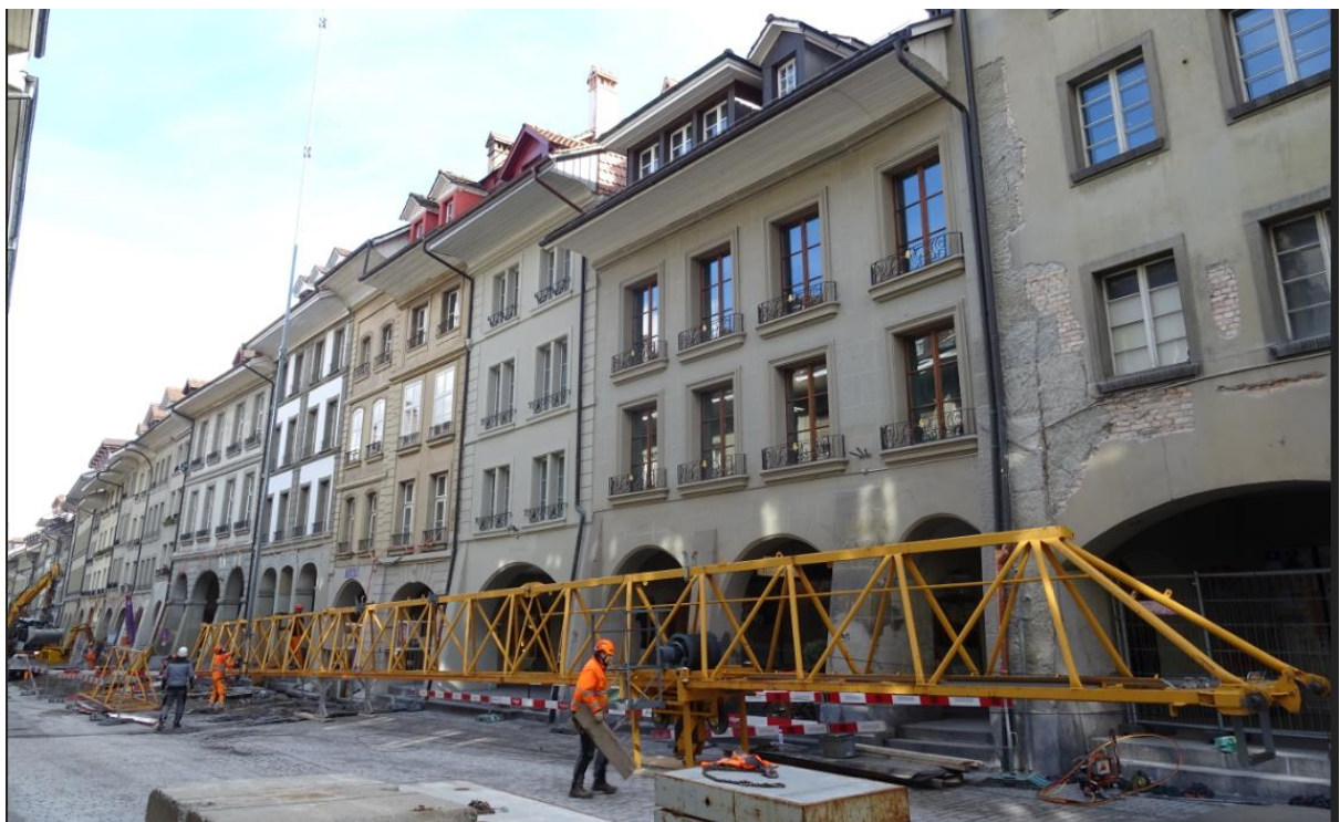
Zusammensetzen des 40m langen Auslegers und einziehen des Laufkatzeils in der Rathausgasse.
