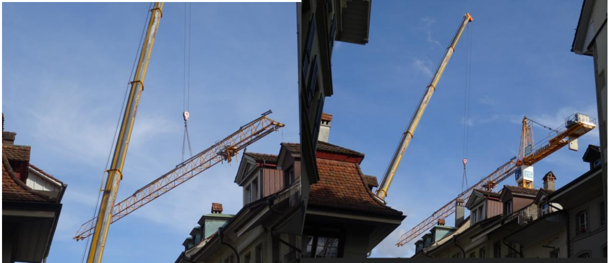
Heben des 40m langen Auslegers.
