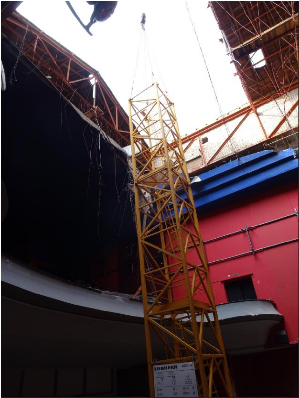
Einbringen der Elemente durch die Dachöffnung.
