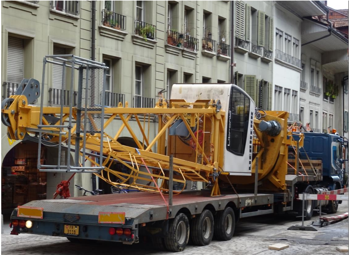
Anlieferung des Königs (Drehkranz mit Kabine) mit vormontierter Spitze.
