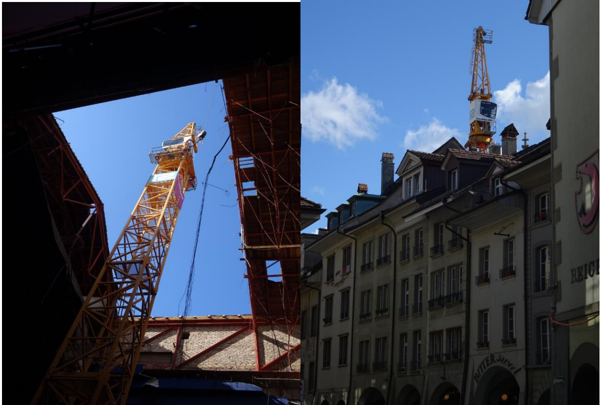
Der Turm ist nun fertig montiert.
