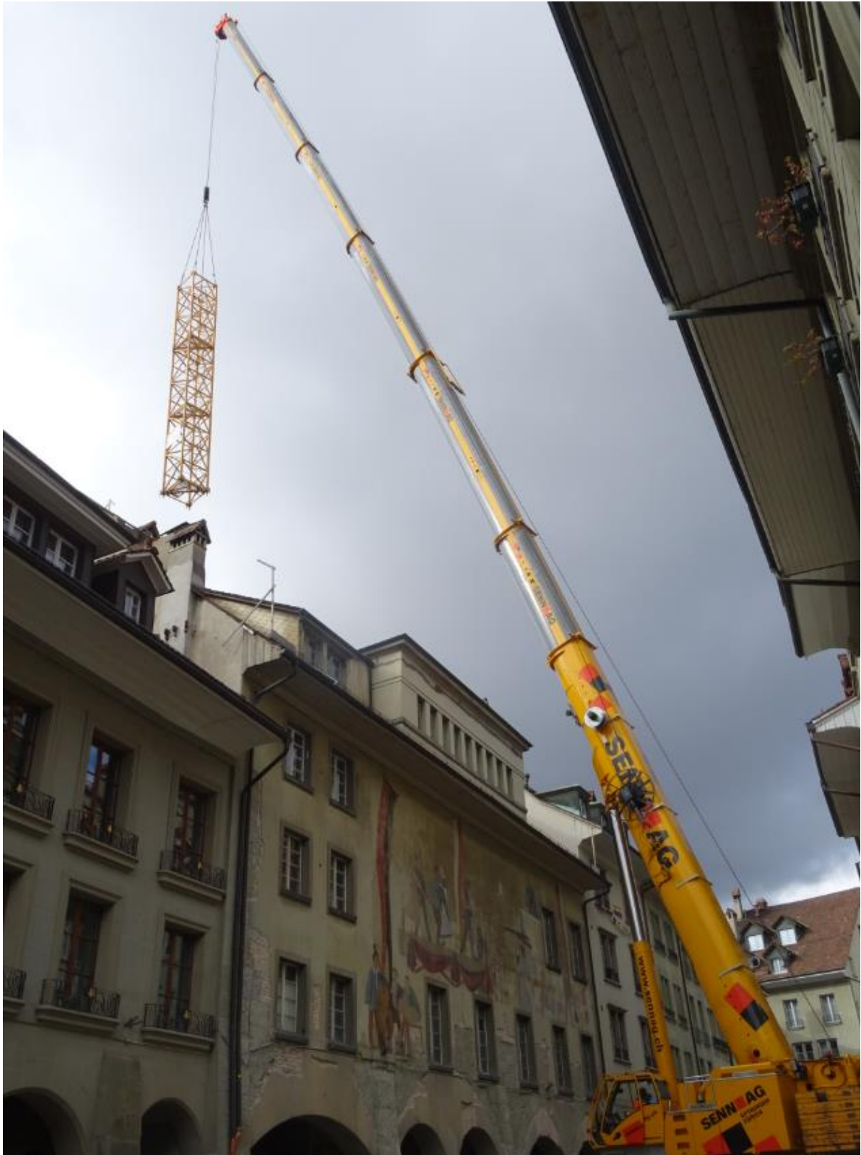
Einheben der ersten Elemente.
