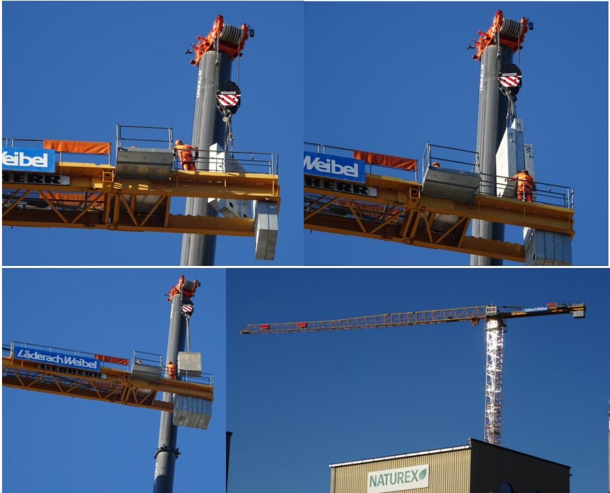
Einhängen der restlichen Gegengewichte im Gegenausleger. Nach dieser Montage wurde noch das Podest mit der Baustellenbeleuchtung montiert und es musste die Litronic (Elektronik, Last- und Arbeitsbegrenzungen) eingestellt werden.
