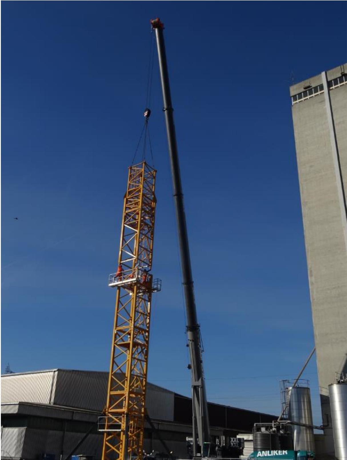
1 weiteres Turmelement des Typs 420 HC (5,8m Höhe) mit Übergansturmstück vom Turm 420 HC zu 256 HC (5,8m Höhe) werden montiert.
