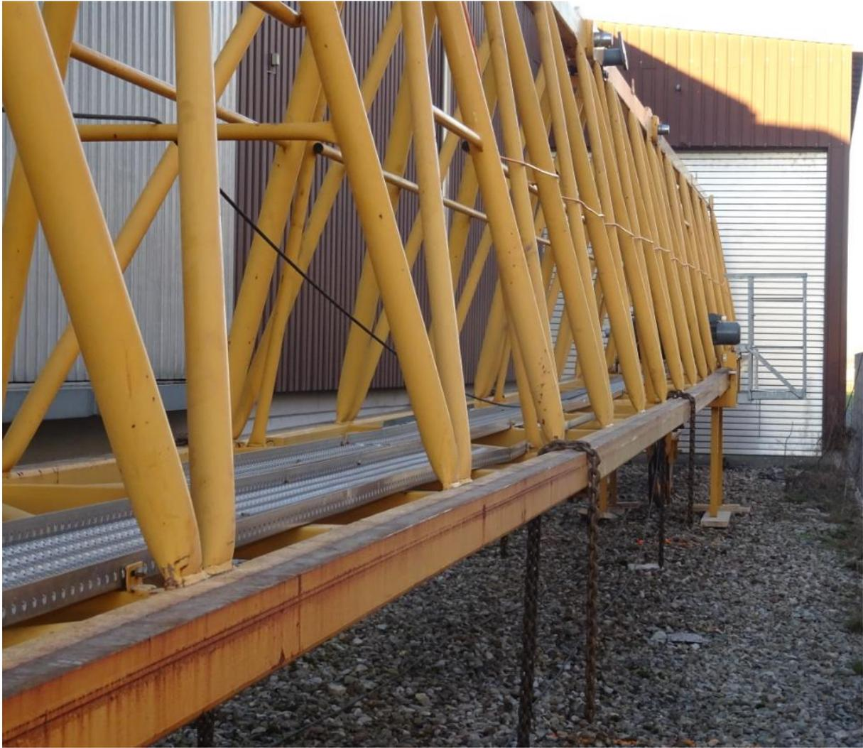
Zusammensetzen des 55m langen Auslegers, Einziehen des Laufkatzeils. Die Ketten sind bereits für das Aufhängen des Auslegers positioniert. Die Aufhängung muss an den Untergurten erfolgen, damit der Ausleger auf die erforderliche Höhe gehoben werden kann.
