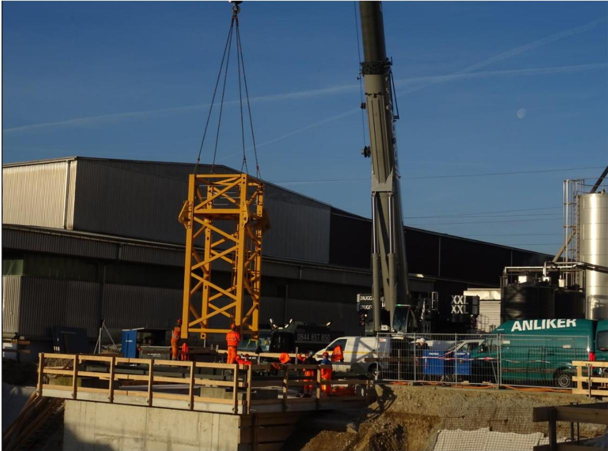
Montage des 8x8m Unterwagens 420 HC (rund 7,5m Höhe ohne Fahrwerk). Auf diesen Unterwagen wurden rund 100 to Zentralballast aufgelegt.
