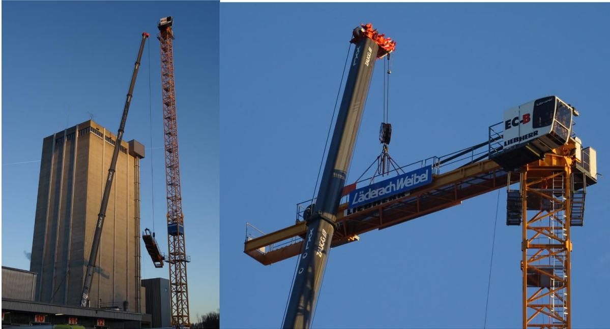
Montage des Gegenausleger. Die Ketten mussten gekürzt werden, damit der Gegenausleger montiert werden konnte.
