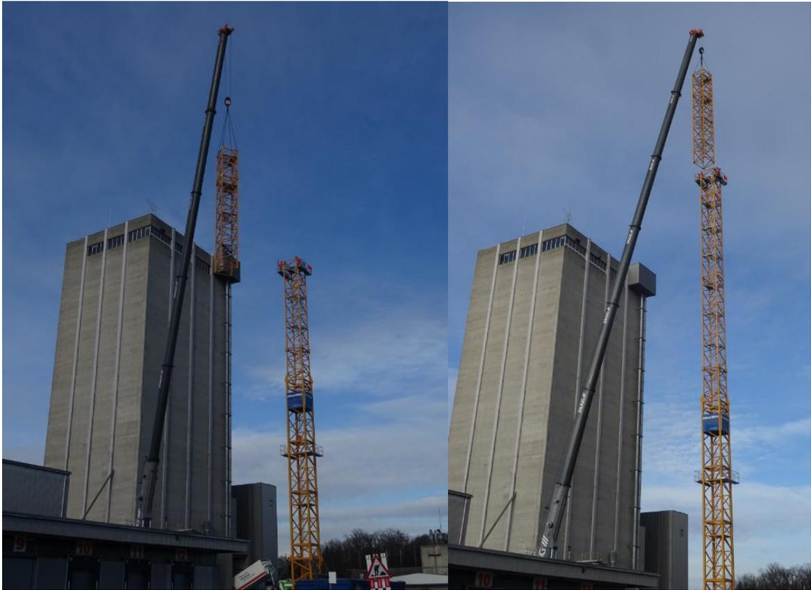
Die nächsten Schritte waren, dass 2 je ein Turmelement 256 HC (12,4m Höhe mit aufmontierten 256 HC Element (4,14m Höhe) daraufgesetzt wurden. Der Ausleger des Mobilkrans ist hier auf seine volle Länge (85m Länge; 84m Hakenhöhe) ausgestossen.
