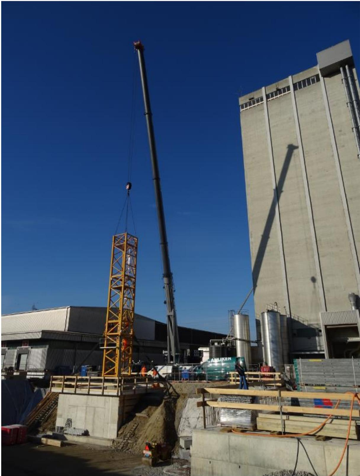
2 weiter Turmelemente des Typ 420 HC (11,6m Höhe) werden montiert.
