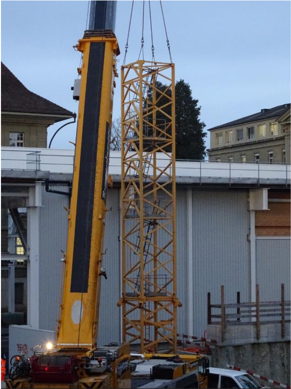
Fundamentkreuz 21 HC 290 (ohne Fahrwerk), Unterwagenturmstück, 3,73m lang und Grundturmstück 21 HC290 TSB-1242c, 12,42m lang.
