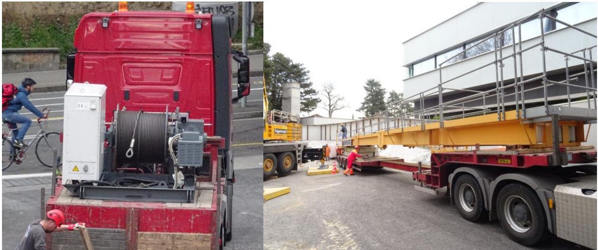
Montage des separat angelieferten Hubwerks auf dem Gegenausleger.
