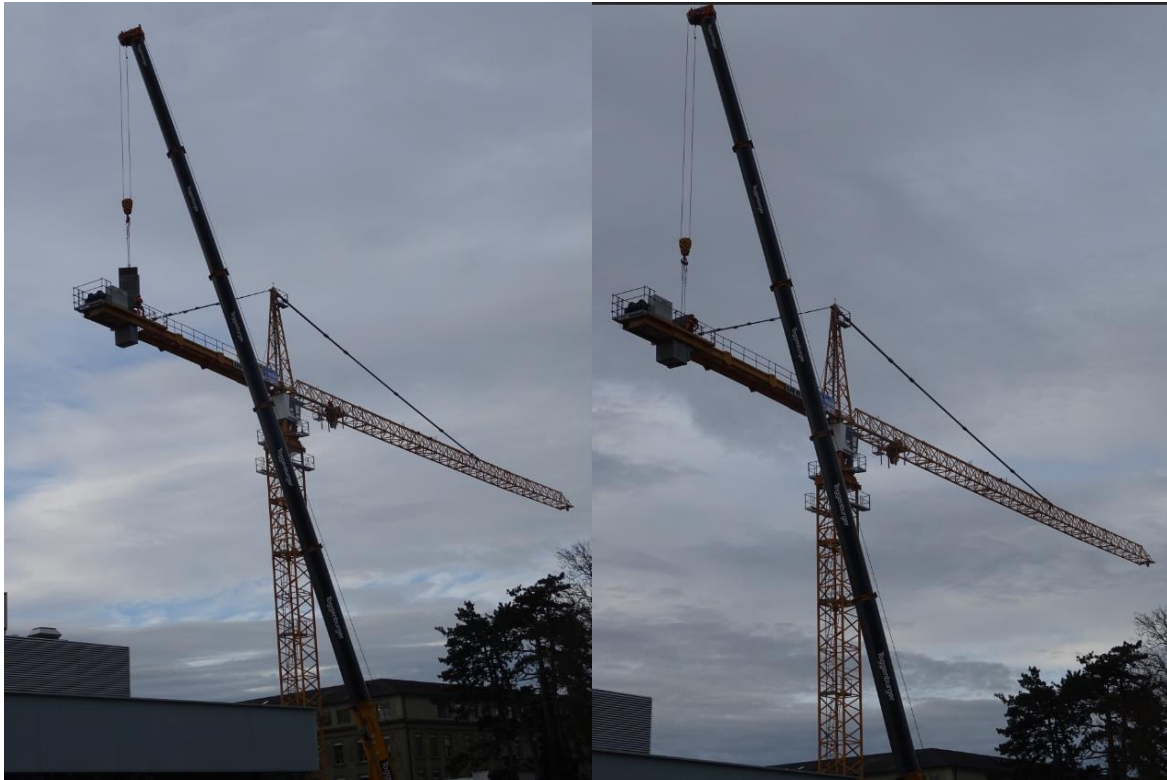
Einhängen der restlichen Gegengewichte im Gegenausleger.
