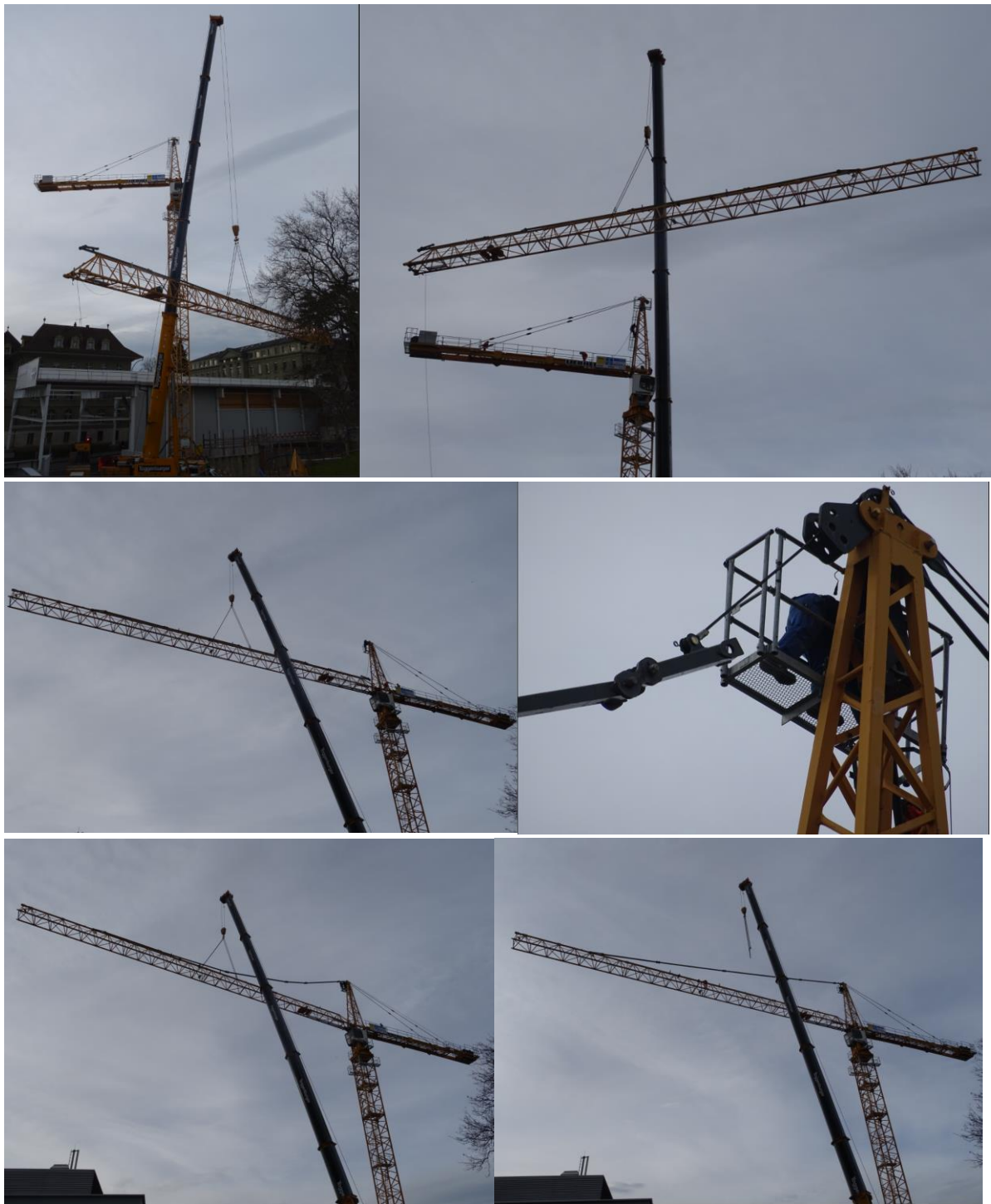
Der 2. Schritt, Heben und montieren des ersten, 44m-langen, Auslegerteils.
