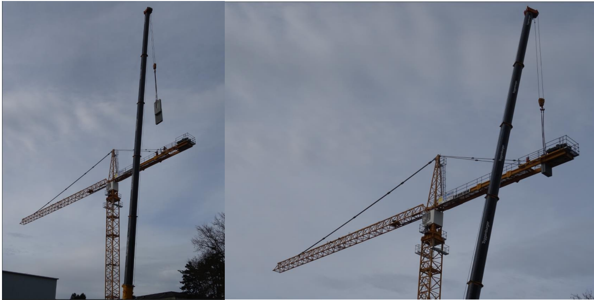
Der 3. Schritt: Einhängen des ersten Gegengewichtes vor der Montage des Auslegers.
