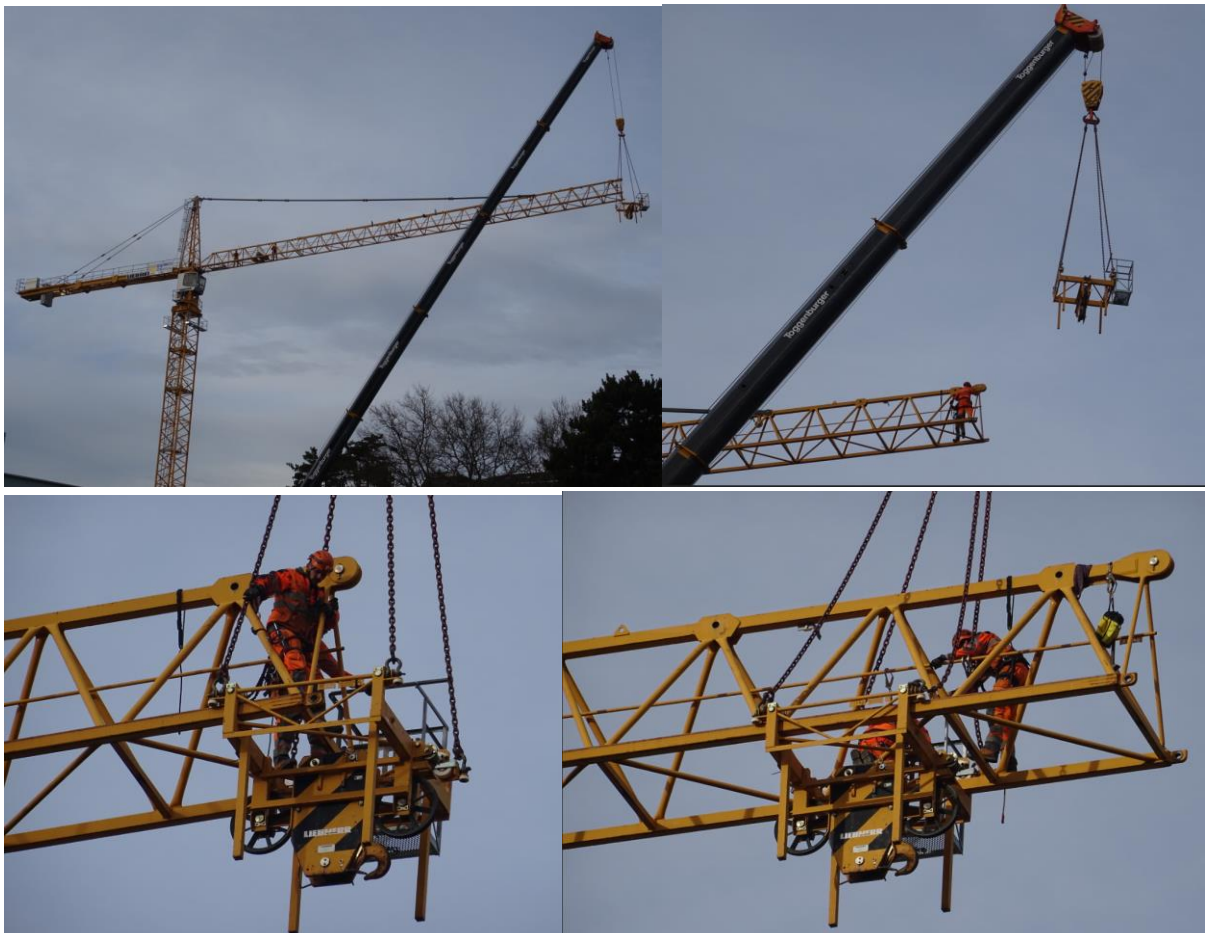
Der 4. Schritt: Einführen der Laufkatze mit Hakenflasche.
