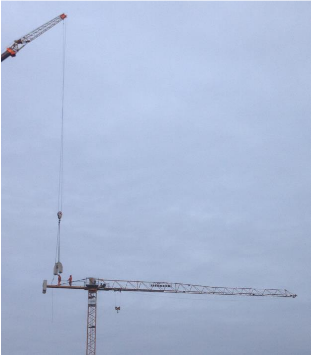
Einsetzen der restlichen Gegengewichte.
