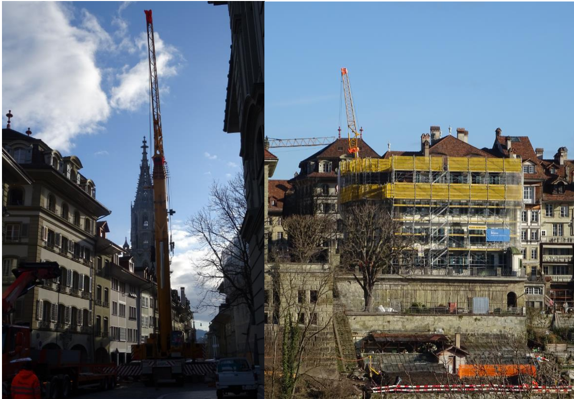
Der Mobilkran mit der 12m langen Gittermast-Auslegerverlängerung, hydraulischer Ausleger noch eingezogen.
