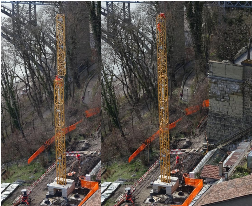
Das erste Turmelement des Typs 30EC-B werden auf den Übergangsrahmen des bereits stehenden LC-Turms gesetzt.
