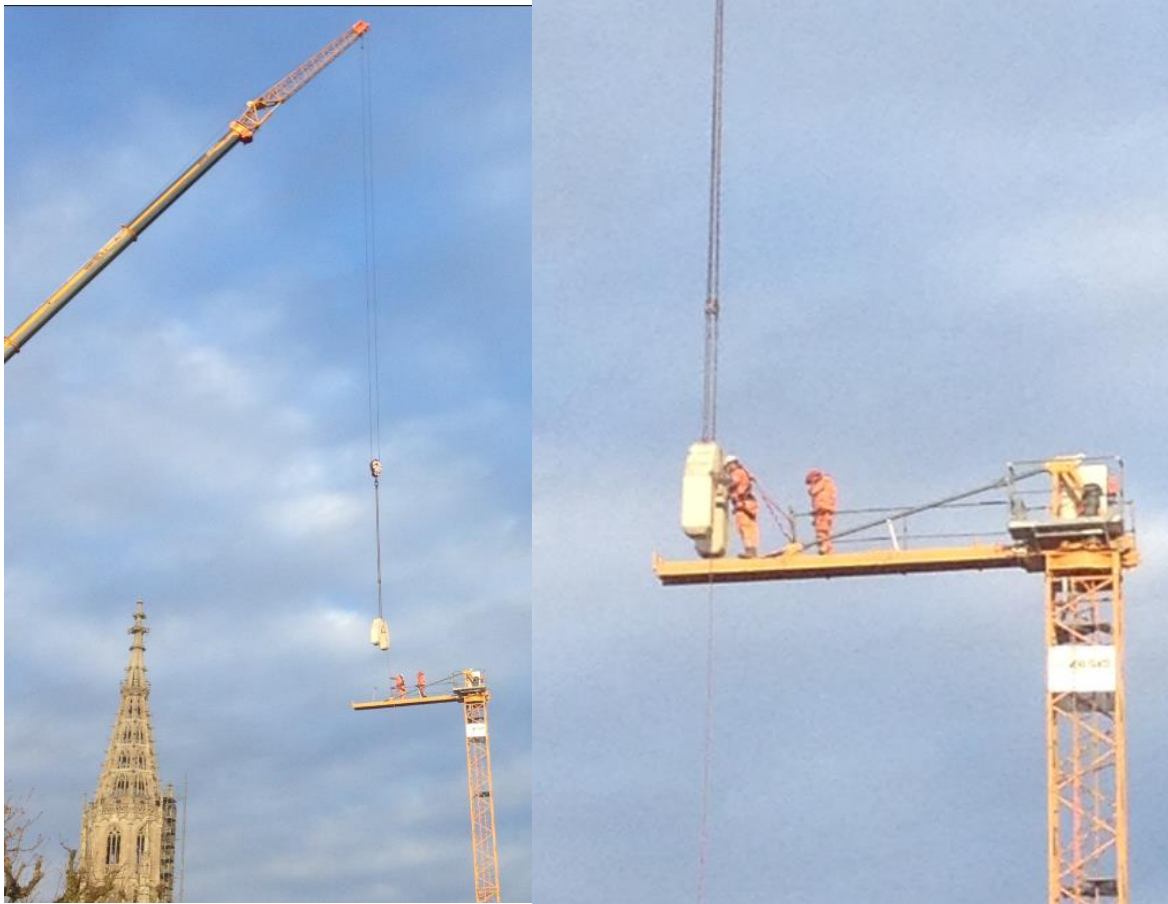
Vor der Montage des Auslegers musste ein Gegengewicht eingehängt werden.
