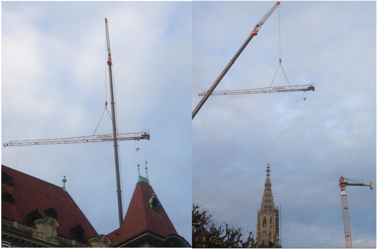
Heben des 30m langen Auslegers.
