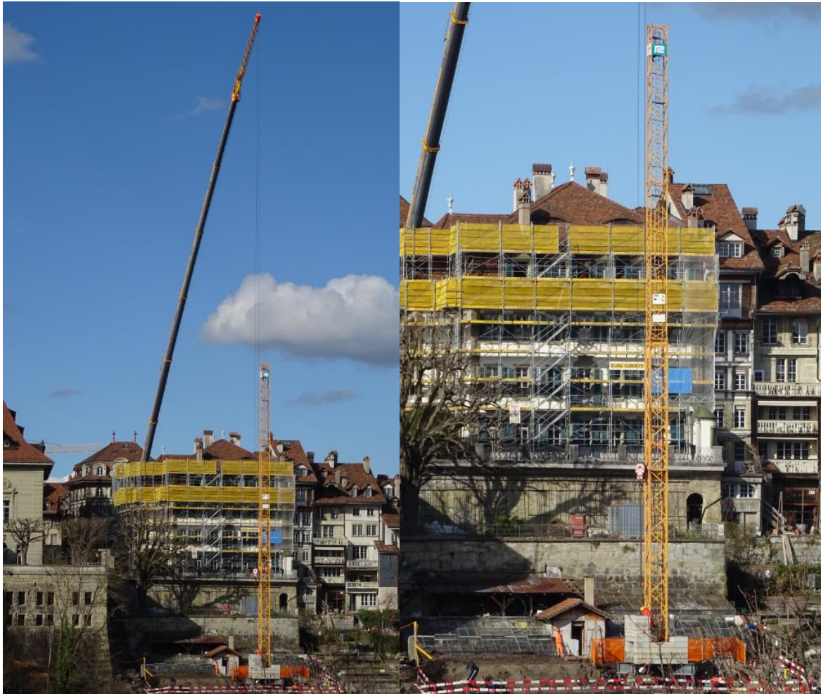
Setzen des restlichen Zentralballastes (nochmals 6 Hübe a 2 Betonblöcke).
