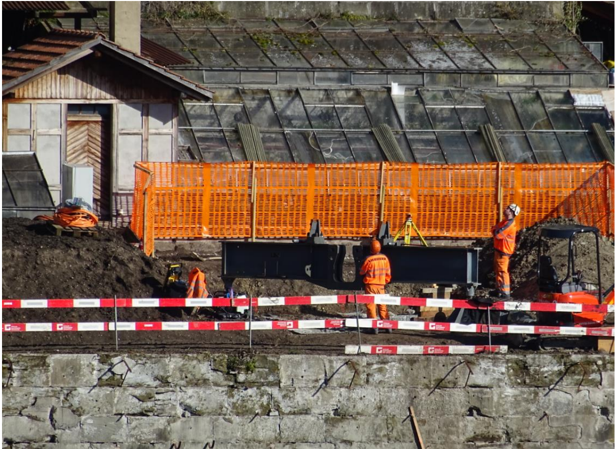
Der Ort, wo der Kran auf Kreuzrahmen mit Trapezen montiert werden soll (im Garten).
