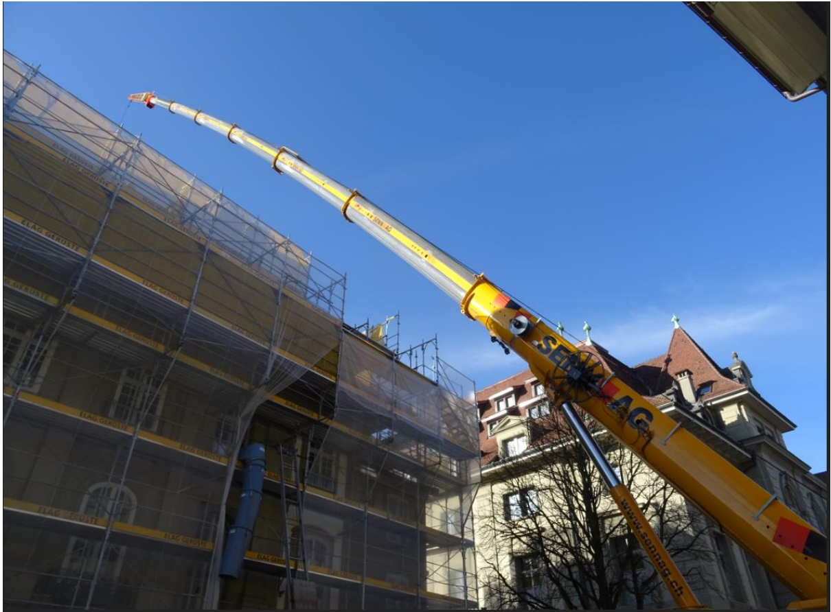
Die Störkanten (Dachkanten in der Rathausgasse).
