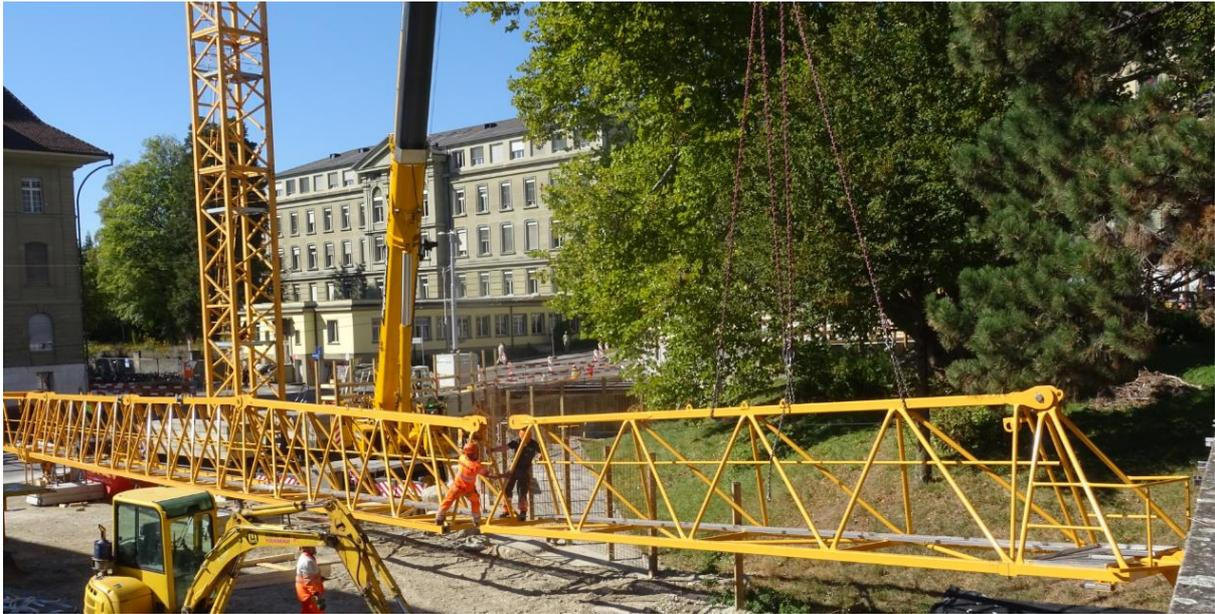
Zusammensetzen des 50m langen Auslegers. Die Platzverhältnisse waren innerhalb der Baustelle knapp bemessen. Die Laufkatze mit eingehängter Hakenflasche ist eingeführt.
