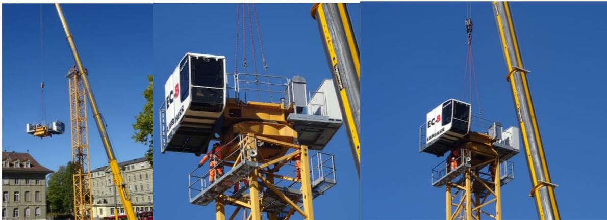
Die Drehbühne inkl. Kabine und Schaltschrank ("der König") mit knapp 10 Tonnen Gewicht heben und montieren.
