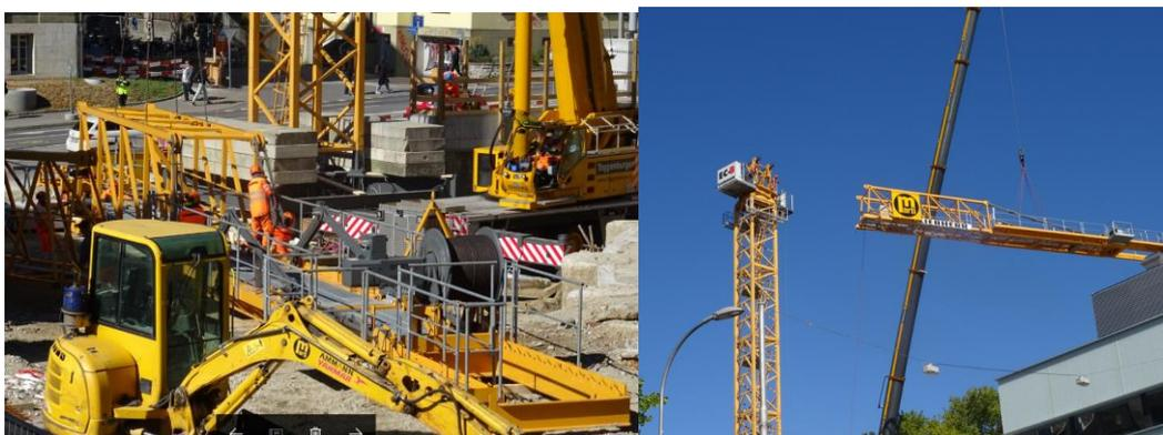
Zusammensetzen und heben des Gegenauslegers (Gesamtgewicht 13,4 Tonnen). Die Abspannstangen mussten mittels Habegger zusammengezogen werden. Hier gilt es zu beachten, dass der Gegenausleger nicht über "gelenkige" Verbindungen angehängt wird (Bsp. die einen Anhängpunkte am Anlenkstück, die anderen am Zwischenstück), sondern
