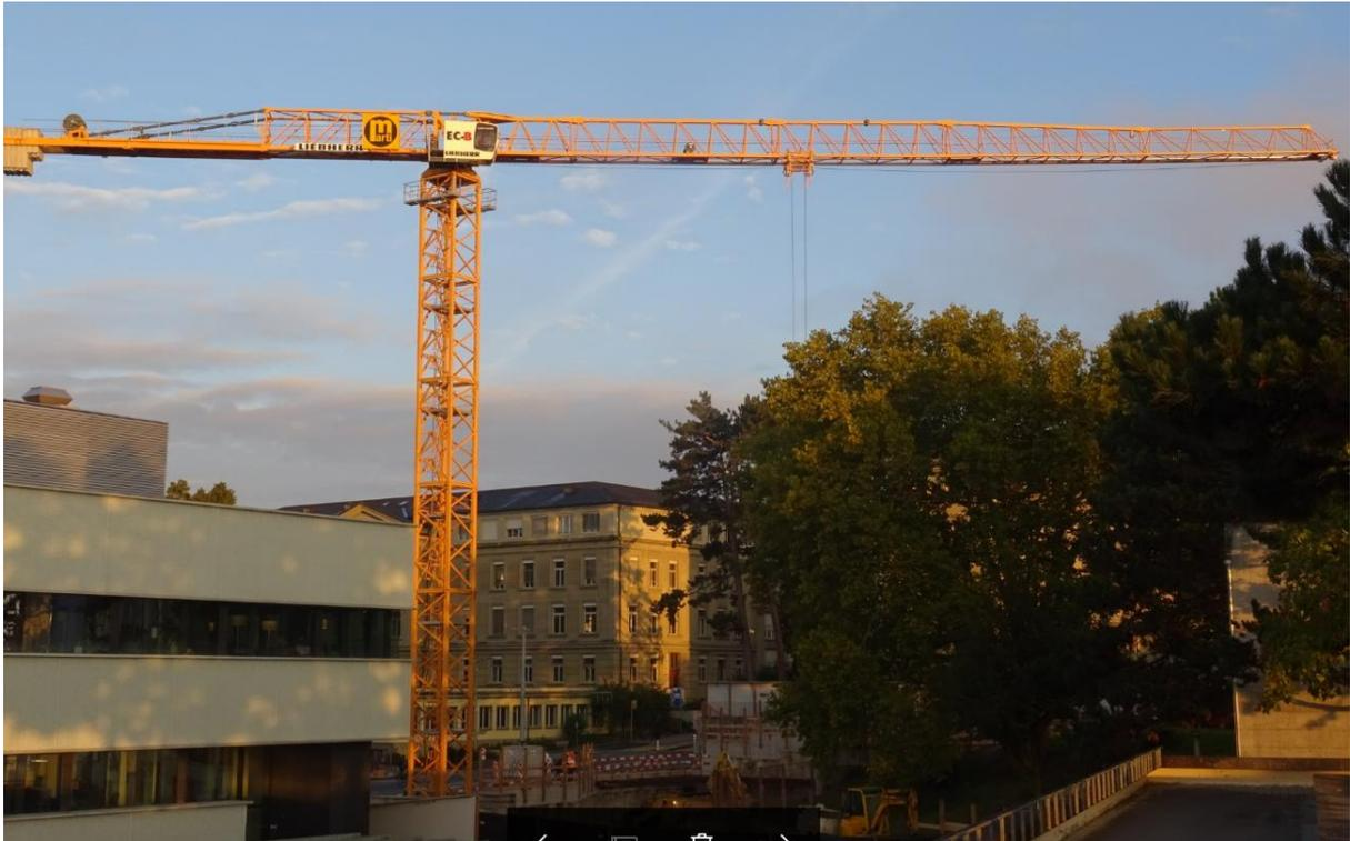
Nach dem Einziehen des Hubseils, des Einstellens und Kalibrierung der Litronic (Arbeitsbegrenzungen, zulässige Hublasten bei entsprechenden Ausladungen, etc.) und der Übergabe des Krans an den Betreiber steht der Kran nun im Einsatz.
