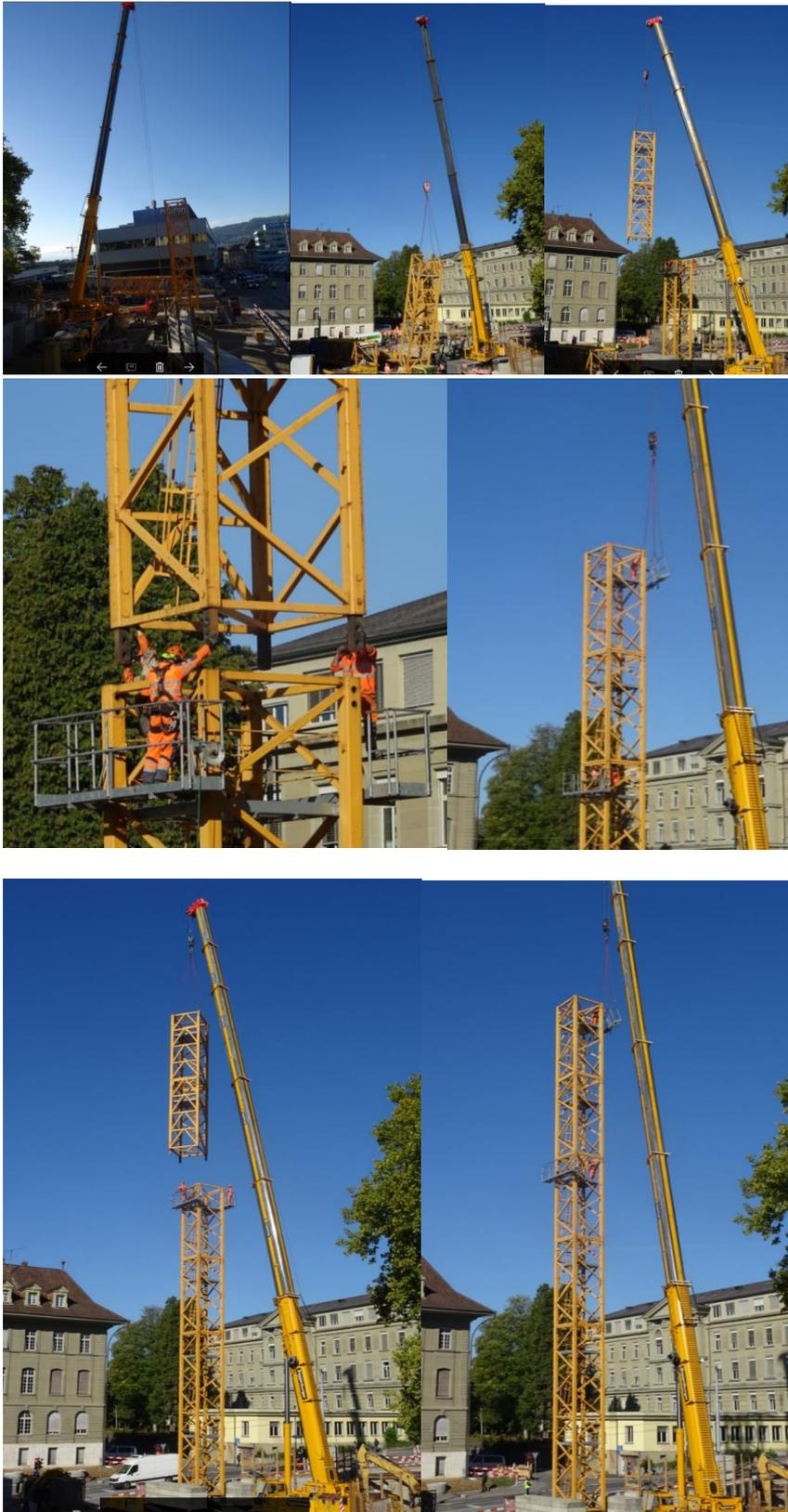
Der Turm wurde in 3 Einheiten mit je rund 9 Tonnen Gewicht (24 HC 420) angeliefert und montiert.
