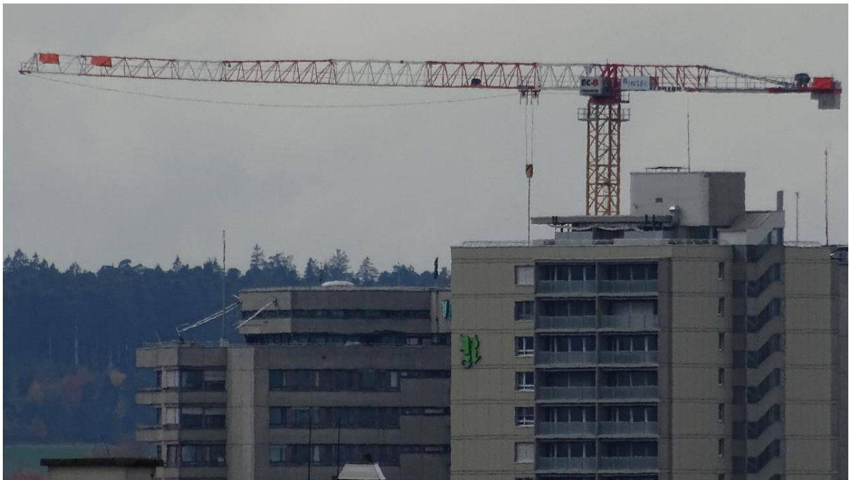
Nach dem Einziehen des Hubseils, des Einstellens und Kalibrierung der Litronic (Arbeits-Begrenzungen, zulässige Hublasten bei entsprechenden Ausladungen, etc.) und der Übergabe des Krans an den Betreiber steht der Kran nun im Einsatz.
