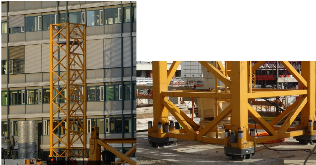
Aufsetzen des Grundturmelementes 24 HC 630 TSB-1242c auf die Fundamentanker.
