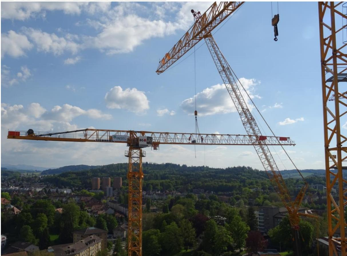
Montage des 40m langen und rund 16,5 Tonnen schweren Ausleger inklusive Laufkatze und Hakenflasche. Danach wurde die Hindernisbefeuering montiert und in Betrieb gesetzt.
