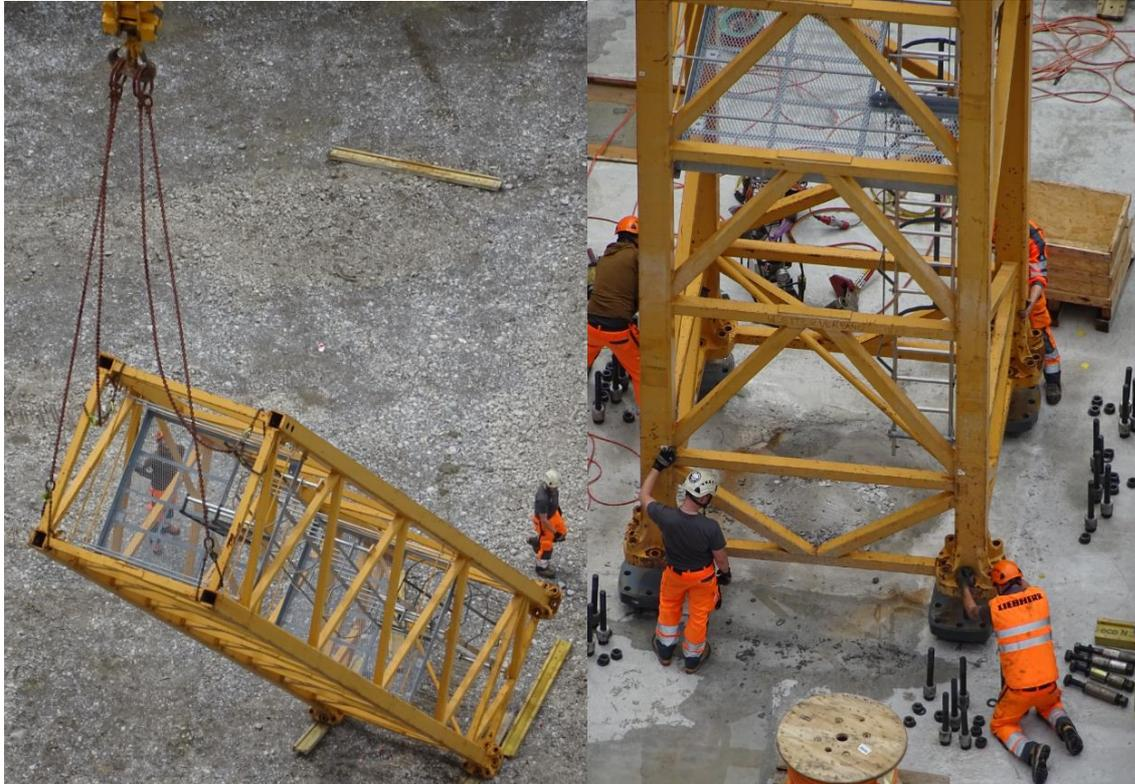
Aufsetzen des Grundturmelementes 24 HC 630 TSB-1242c auf die Fundamentanker.
