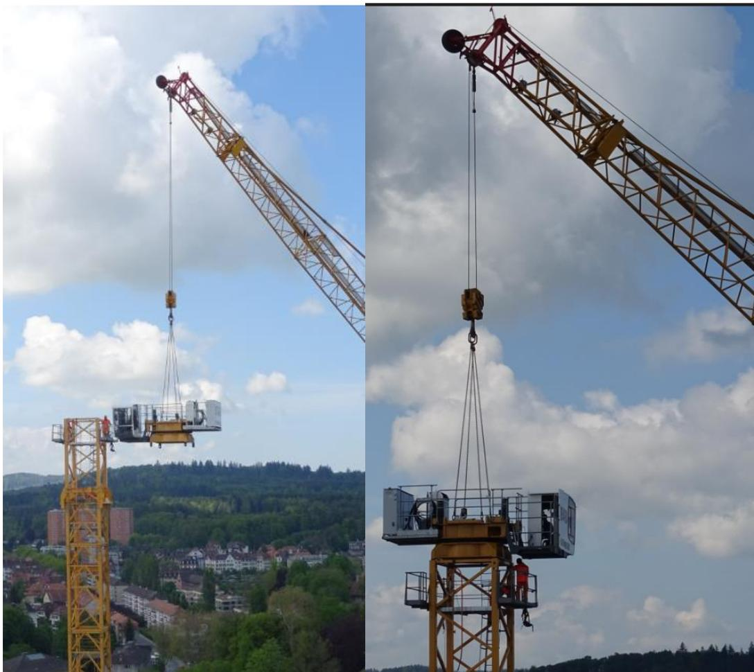
Die Drehbühne inkl. Kabine und Schaltschrank ("der König") mit knapp 10 Tonnen Gewicht heben und montieren.
