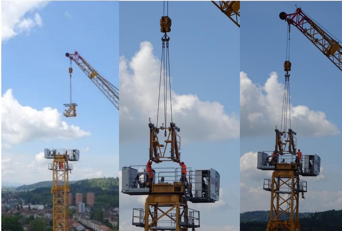
Die Spitze mit einem Gewicht von 2,5 Tonnen heben und montieren.
