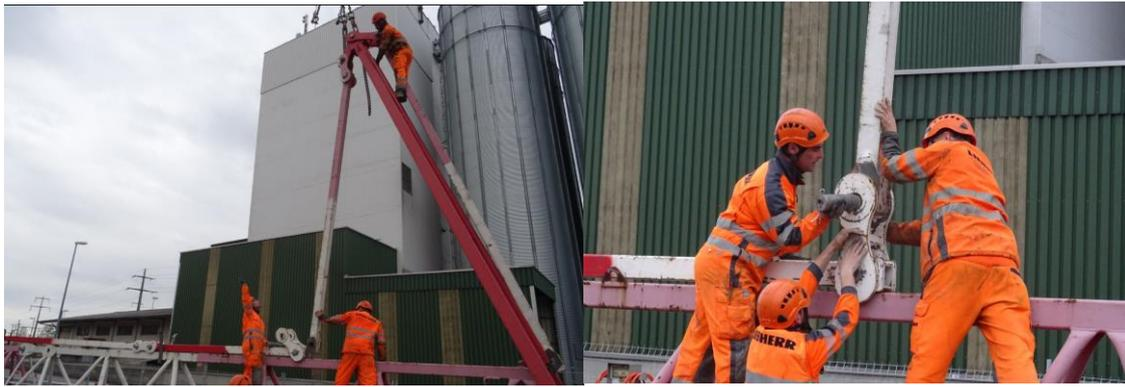
Montage der Abspannung (Vierkantrohr) für den Kopfteil des Auslegers über den A-Bock.
