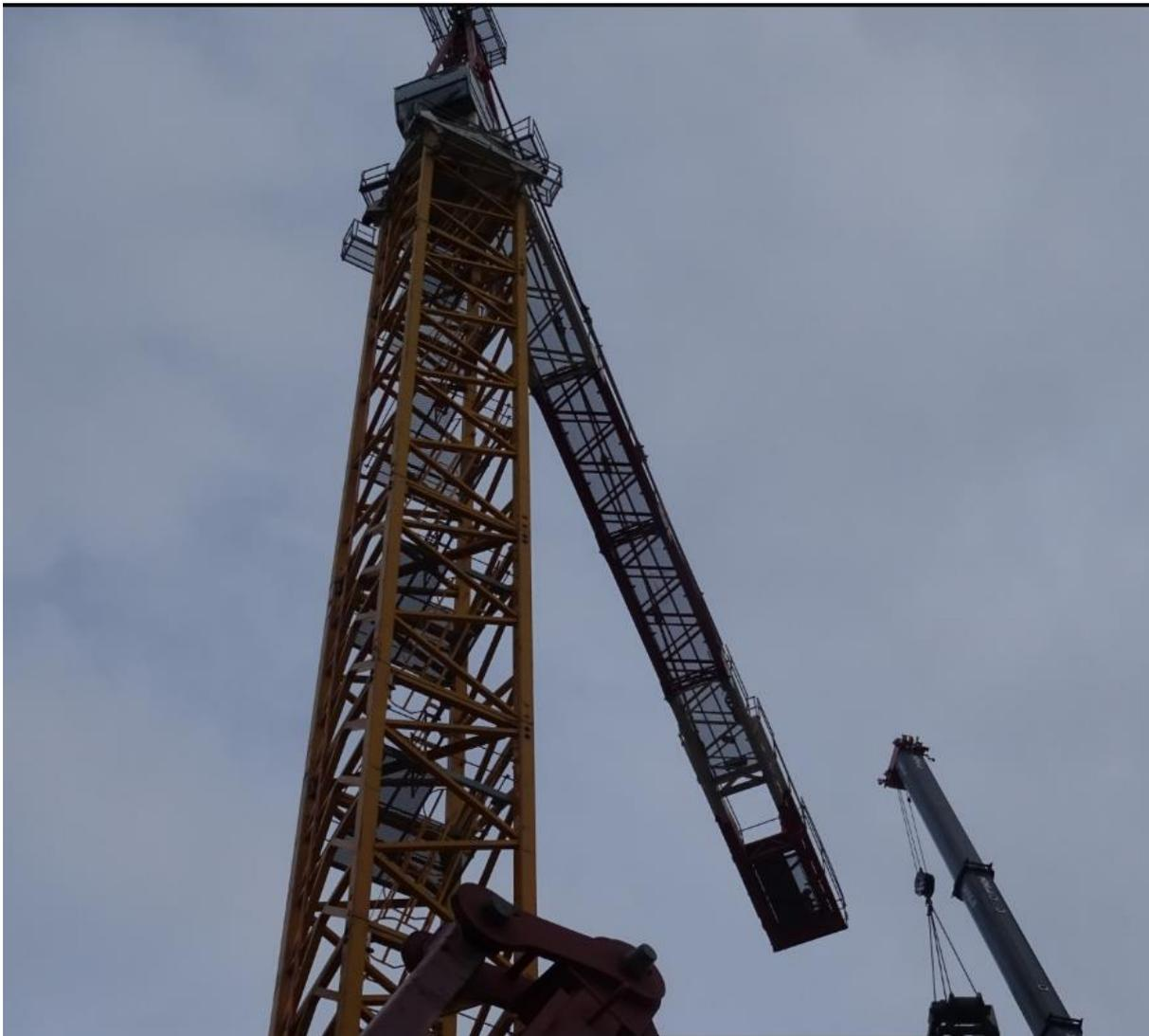
Montage der Hubwinde (6,15 Tonnen) auf dem Gegenausleger.
