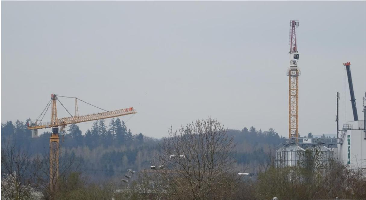
Das Ziel des Samstags war bereits am Mittag erreicht. Nun konnten am Nachmittag bereits die restlichen Teile des Krans (Gegenausleger, Hubwinde, Gegenballast, Ausleger) angeliefert, abgeladen und teilweise vormontiert werden.
