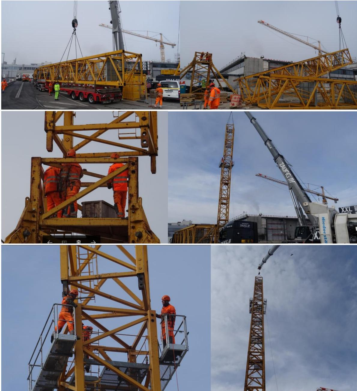
Der Turm wurde in 3 Teilen, zweimal 3 Turmelemente mit je einem Gewicht von 19,44 Tonnen und einmal 2 Turmelemente bereits vormontiert mit einem Gewicht von 12,96 Tonnen, angeliefert und montiert.
