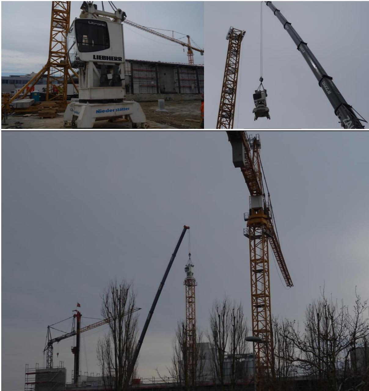
Die Drehbühne inkl. Kabine ("der König") mit 17,0 Tonnen Gewicht heben und montieren.
