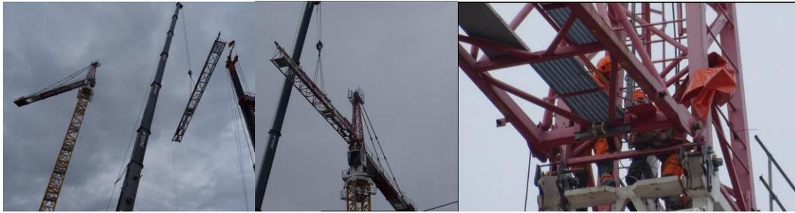
Montage des Anlenkteils des Auslegers (ca. 25 Tonnen mit Abspannung).
