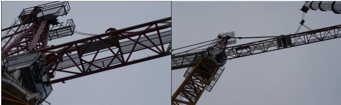
Montage der Abspannung, die Stangen sind mittels Seilen befestigt und können über die Spitze mit dem Hubseil hochgezogen werden. Fixierung der Abspannung des Anlenkteils des Auslegers an der Spitze.
