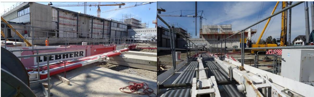
Vormontage des Gegenauslegers am Boden. Daneben Abspannstange des Auslegerkopfstückes. Diese wurde vormontiert angeliefert.
