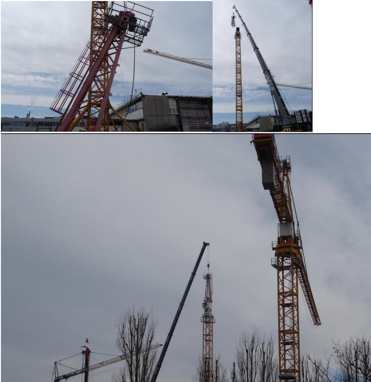
Die Spitze mit einer Länge von 9,40 m und einem Gewicht von 5,45 Tonnen heben und montieren. Der Mobilkran LIEBHERR LTM 1450-8.1 hat hier die vollen 85 m seines Teleskopauslegers ausgefahren.
