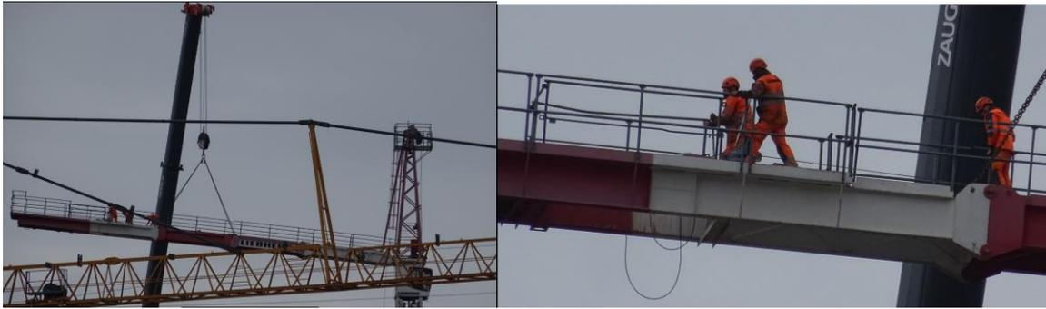
Die Abspannstangen mussten mittels Habeggerzug nach hinten gezogen werden, um sie zu verbinden.
