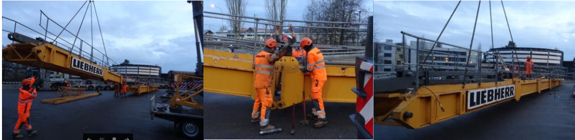
Vormontage des Gegenauslegers am Boden
