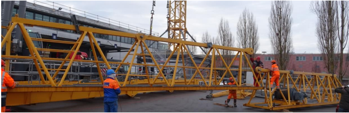
Zusammensetzen des Ausleger-Anlenkteils (25m).
