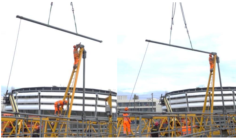
Montage der Abspannung für den Kopfteil des Auslegers über den A-Bock auf den Anlenkteil des Auslegers.
