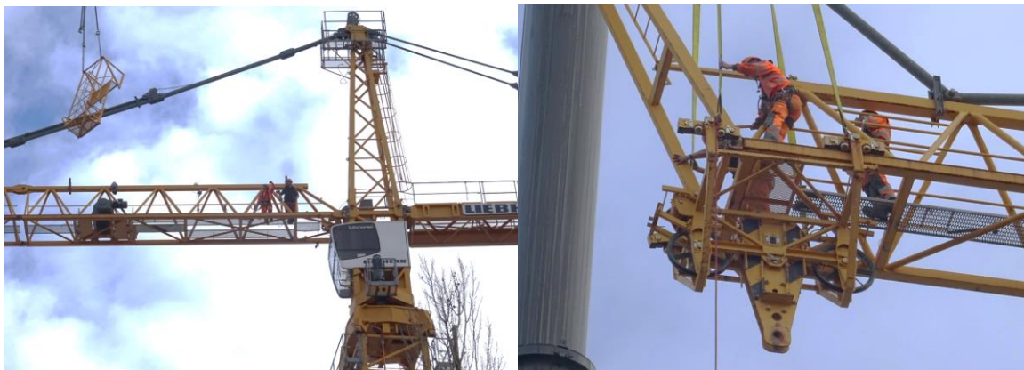
Montage des Personenkorbes am Ausleger und Einführen der Laufkatze.
