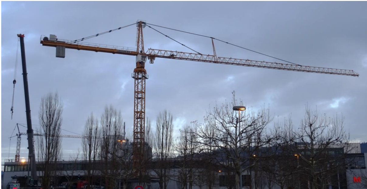
Das Tagesziel ist erreicht der Kran ist mechanisch fertig montiert.
