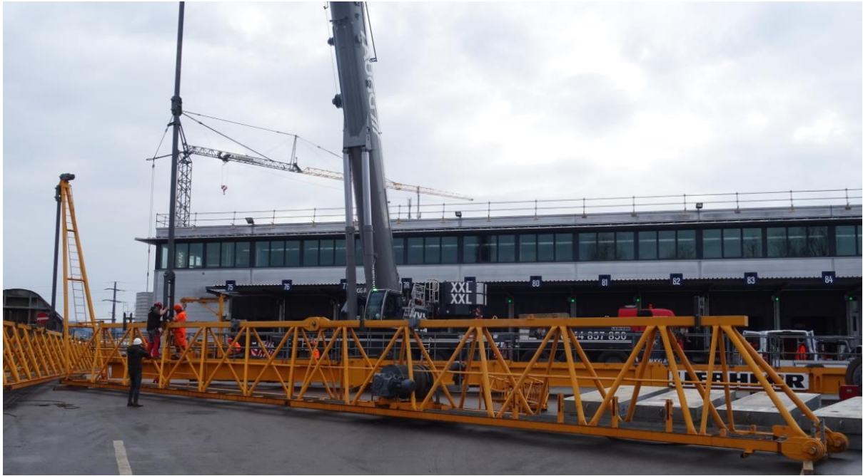
Montage der Abspannung (Vierkantrohr) für den Anlenkteil des Auslegers.
