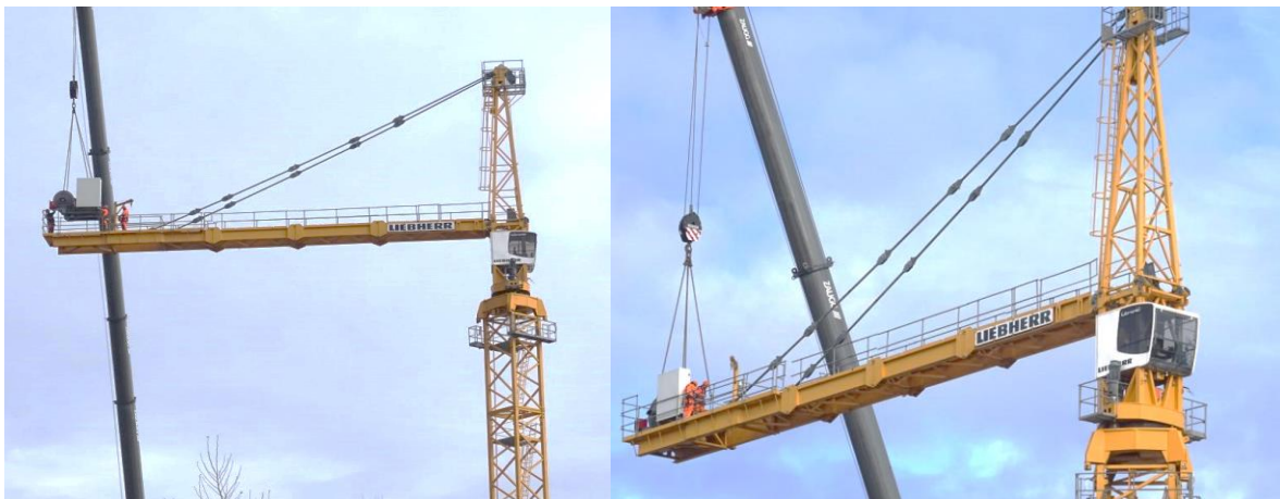
Montage der Hubwinde (6,75 Tonnen) auf dem Gegenausleger.
