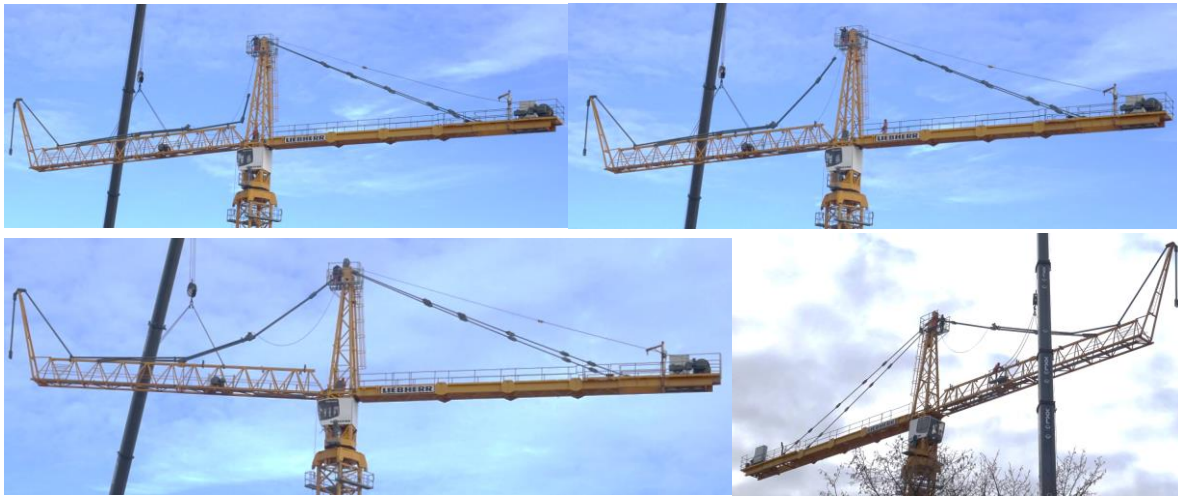
Montage der Abspannung, die Stangen sind mittels Seilen befestigt und können über die Spitze mit dem Hubseil hochgezogen werden. Fixierung der Abspannung des Anlenkteils des Auslegers an der Spitze.
