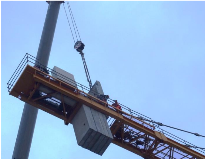
Einsetzen der 8 Gegengewichte mit je rund 4 Tonnen Gewicht.
