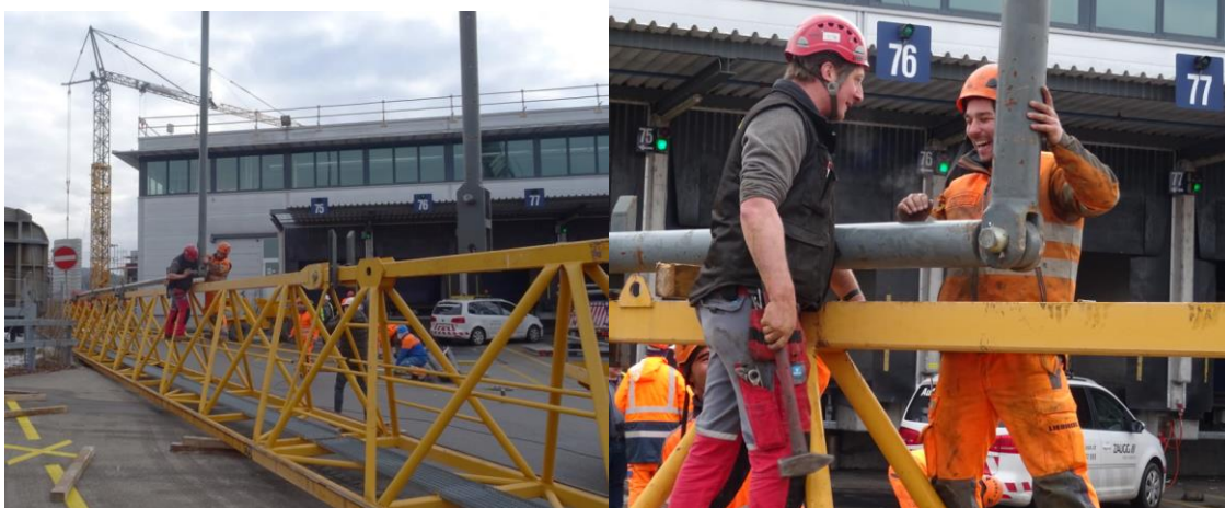
Montage der Abspannung (runde Abspannung) auf dem Kopfteil des Auslegers. Es herrschte eine gute Stimmung nach dem Motto "Du schaffst das...".
