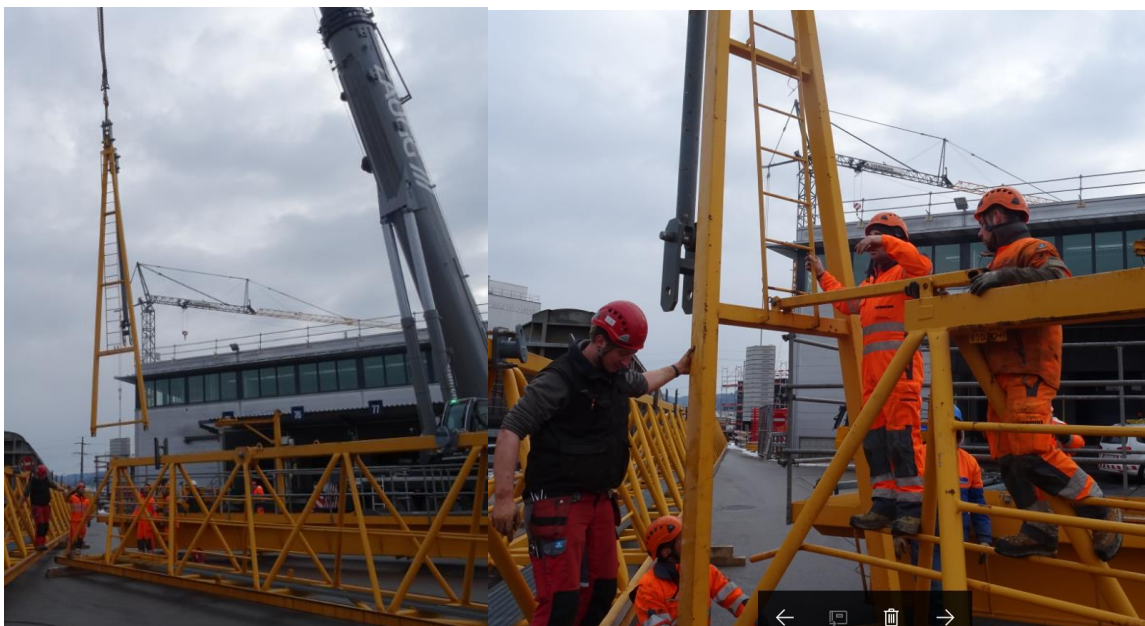
Montage des A-Bocks am Anlenkteil des Auslegers. Der A-Bock wird fixiert (muss, wenn die Abspannung gespannt wird, wieder gelöst werden).
