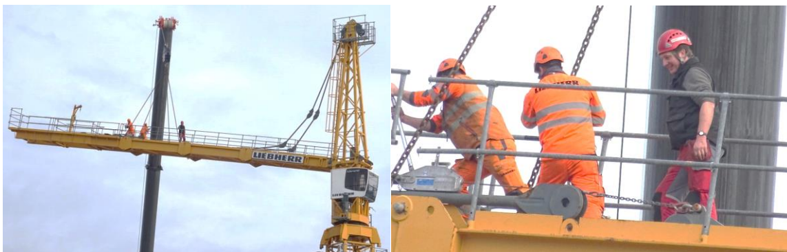
Die Abspannstangen mussten mittels Habeggerzug nach hinten gezogen werden, um sie zu verbinden.
