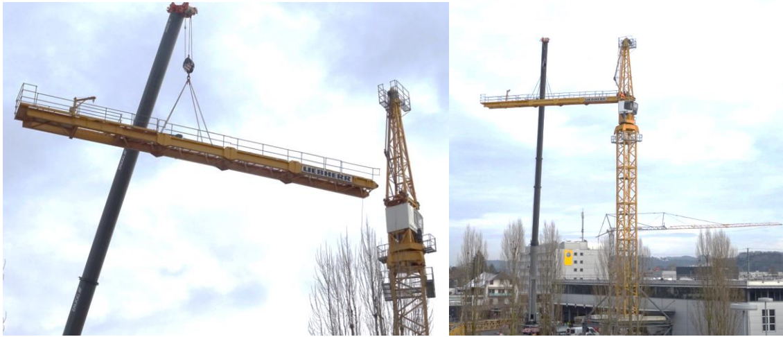
Montage des Gegenauslegers (Länge 27,8m; Gewicht rund 15 Tonnen).
