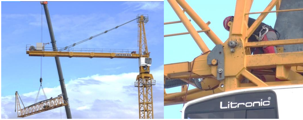
Montage des Anlenkteils des Auslegers (ca. 12 Tonnen mit A-Bock und Abspannung).
