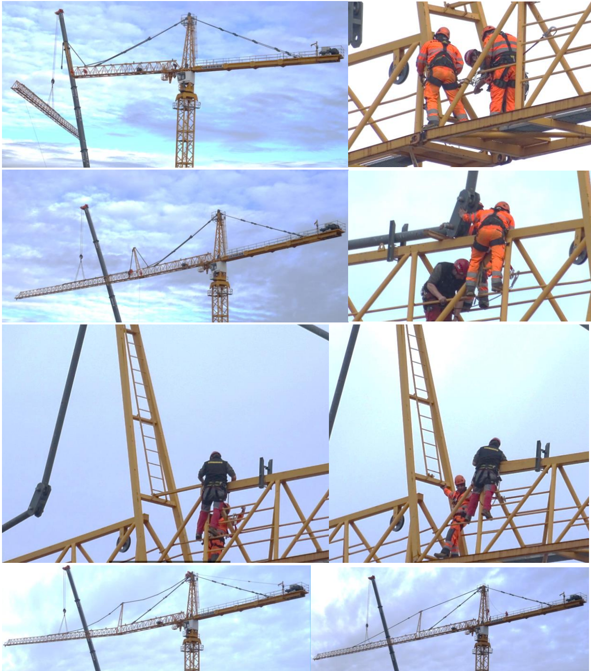
Montage des Kopfteils vom Ausleger (rund 13 Tonnen mit Abspannstangen).
