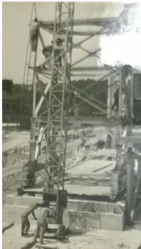
*Hand-Arbeit an der Montage-Nadel beim Zusammenstellen eines Kranportals, Bild: Pius Meyer*
