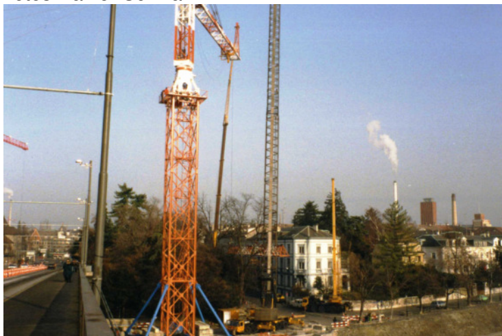
Vorbereitung und Montage des Auslegervorderteils Gewicht 15.6 t. Gut ist die Seilstütze für das Hubseil zu erkennen, welche ein zu starkes Durchhängen des Seils verhindert. Fotos Rainer Schwarz
