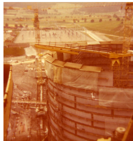
Bau des Reaktors mit Stahlummantelung in Leibstadt, dem Ersteinsatz des Peiner MK 1250. Fotos Rainer Schwarz
