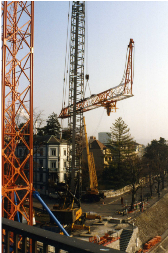
Montage des 29.5 t schweren Grundauslegers an der Wettsteinbrücke. Dieser wird vor dem Gegenausleger montiert. Fotos Rainer Schwarz
