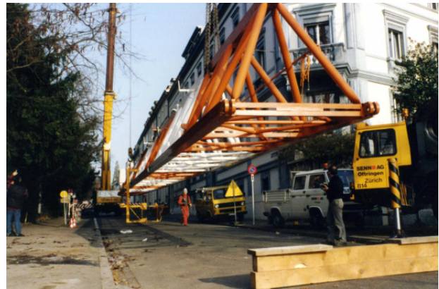
Montage des 29.5 t schweren Grundauslegers an der Wettsteinbrücke. Dieser wird vor dem Gegenausleger montiert. Fotos Rainer Schwarz
