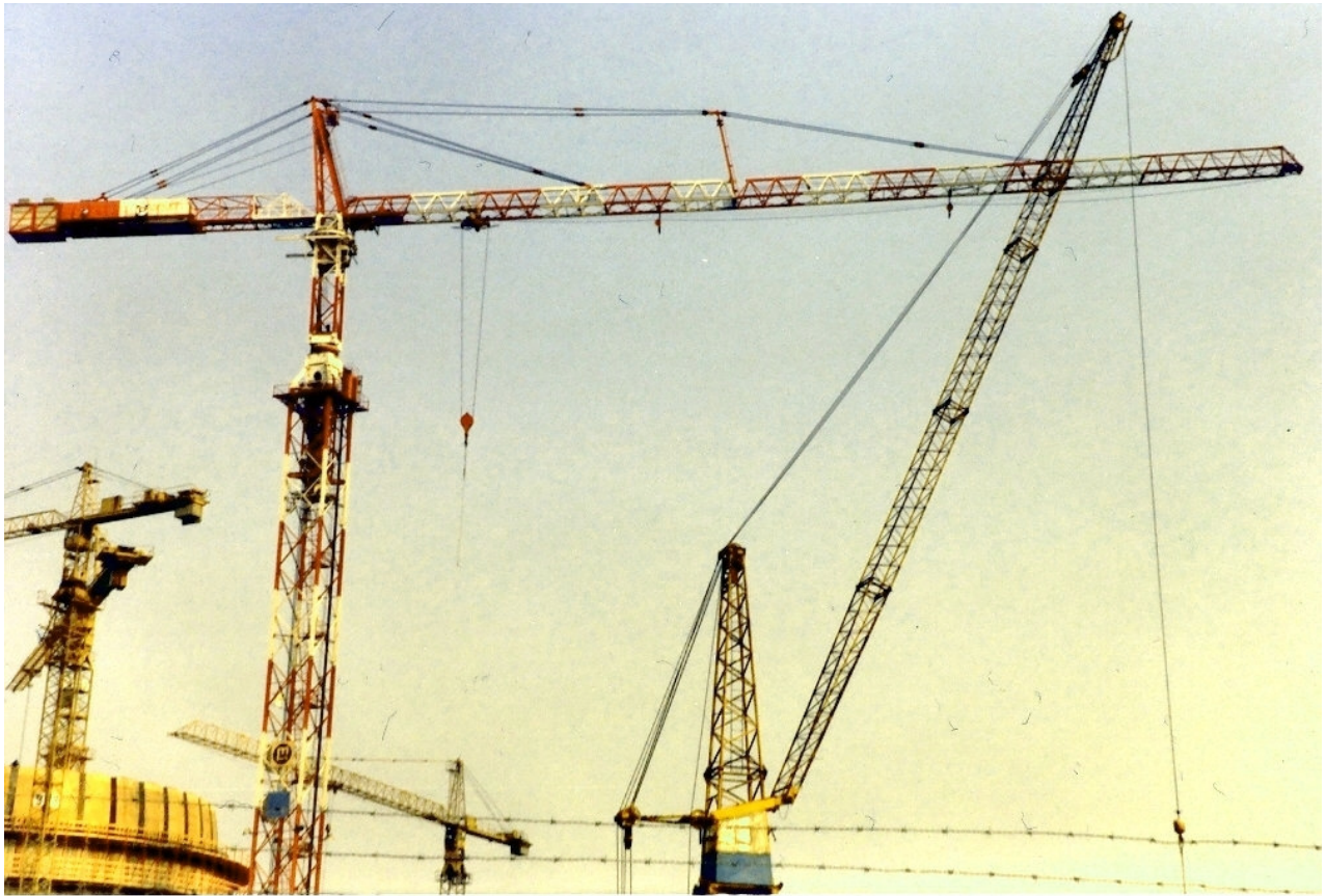
Gesamtansicht des Krans auf der Baustelle des AKW Leibstadt. Der Kran wurde von der Arbeitsgemeinschaft Marti und Spycher eingesetzt. Foto Andreas Bruderer
