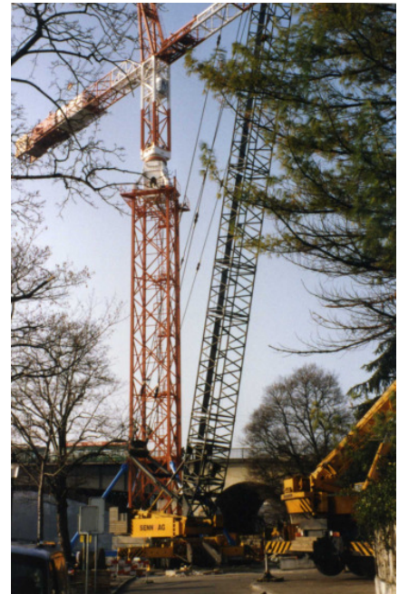
Der Ausleger wird mit zwei Montagekranen hochgezogen, wegen den engen Platzverhältnissen in Basel. Fotos Rainer Schwarz
