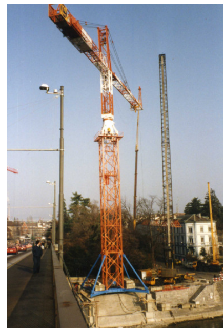
Vorbereitung und Montage des Auslegervorderteils Gewicht 15.6 t. Gut ist die Seilstütze für das Hubseil zu erkennen, welche ein zu starkes Durchhängen des Seils verhindert. Fotos Rainer Schwarz
