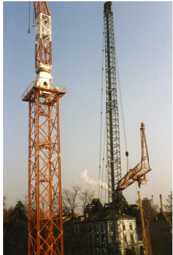
Montage des 29.5 t schweren Grundauslegers an der Wettsteinbrücke. Dieser wird vor dem Gegenausleger montiert. Fotos Rainer Schwarz
