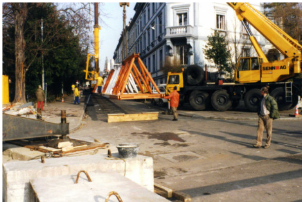
Vorbereitung und Montage des Auslegervorderteils Gewicht 15.6 t. Gut ist die Seilstütze für das Hubseil zu erkennen, welche ein zu starkes Durchhängen des Seils verhindert. Fotos Rainer Schwarz
