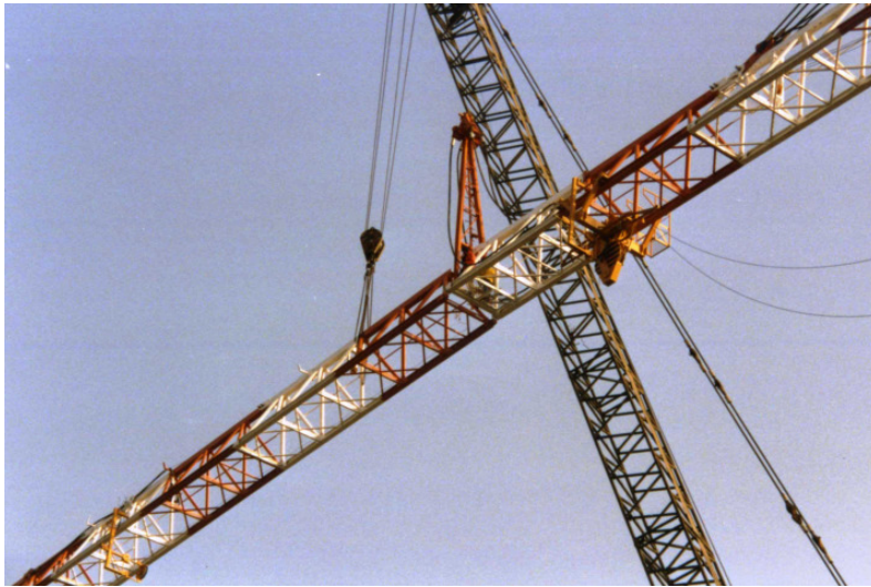
Der Ausleger wird mit zwei Montagekranen hochgezogen, wegen den engen Platzverhältnissen in Basel. Fotos Rainer Schwarz
