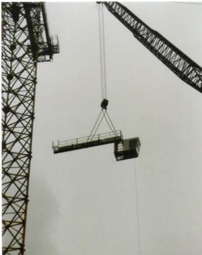
Montage der Drehbühne und Grundmontage von Gegenausleger und Grundausleger und Kabine. Fotos Urs Bähler
