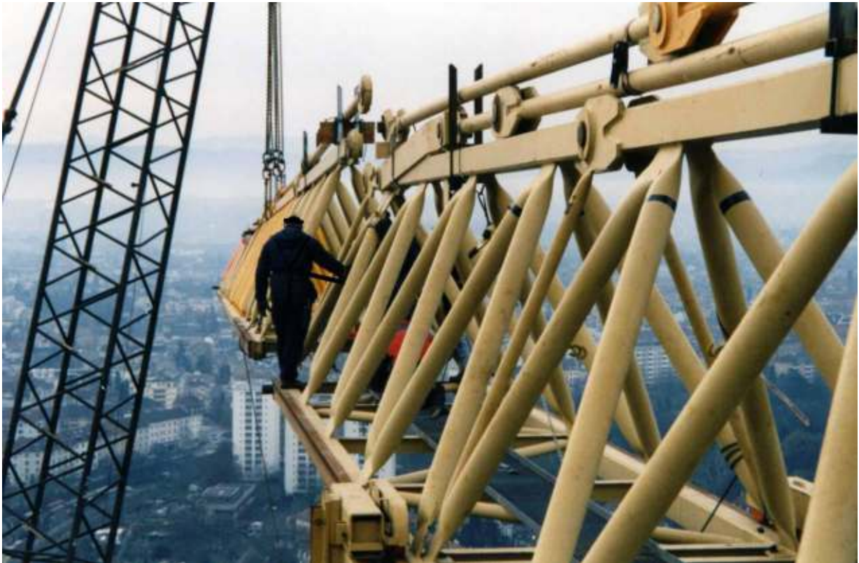
Montage des zweiten Auslegerteils in luftiger Höhe
