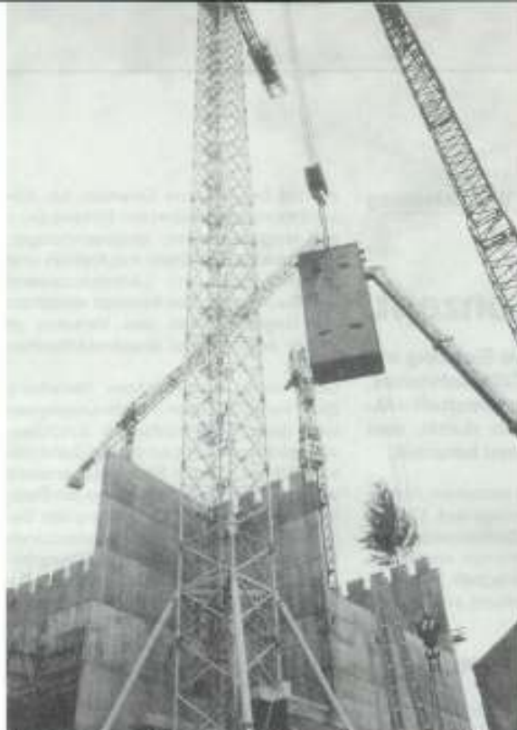
Einer der grössten Krane in der Schweiz, der Potain MD 1400, während der Aufbauphase. (Fotos: U. Jeczorski)
