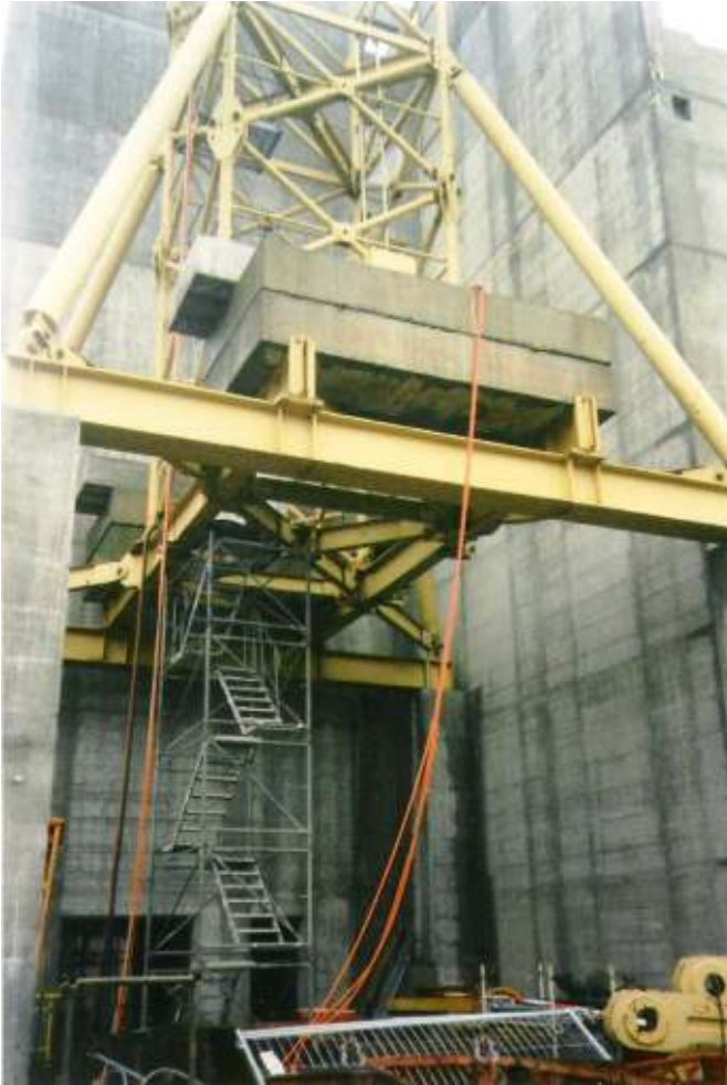
Montage der Drehbühne und Grundmontage von Gegenausleger und Grundausleger und Kabine. Fotos Urs Bähler
