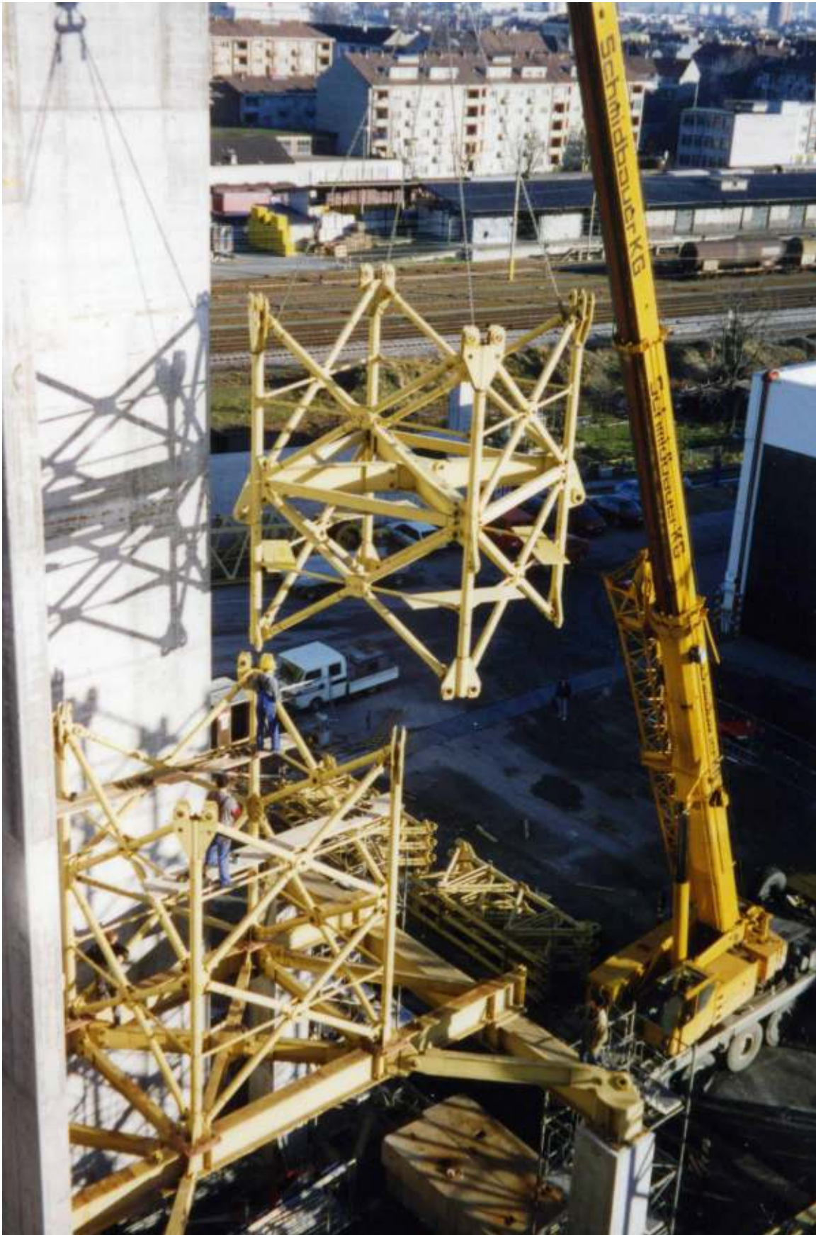
Das Unterwagenturmstück wird montiert
