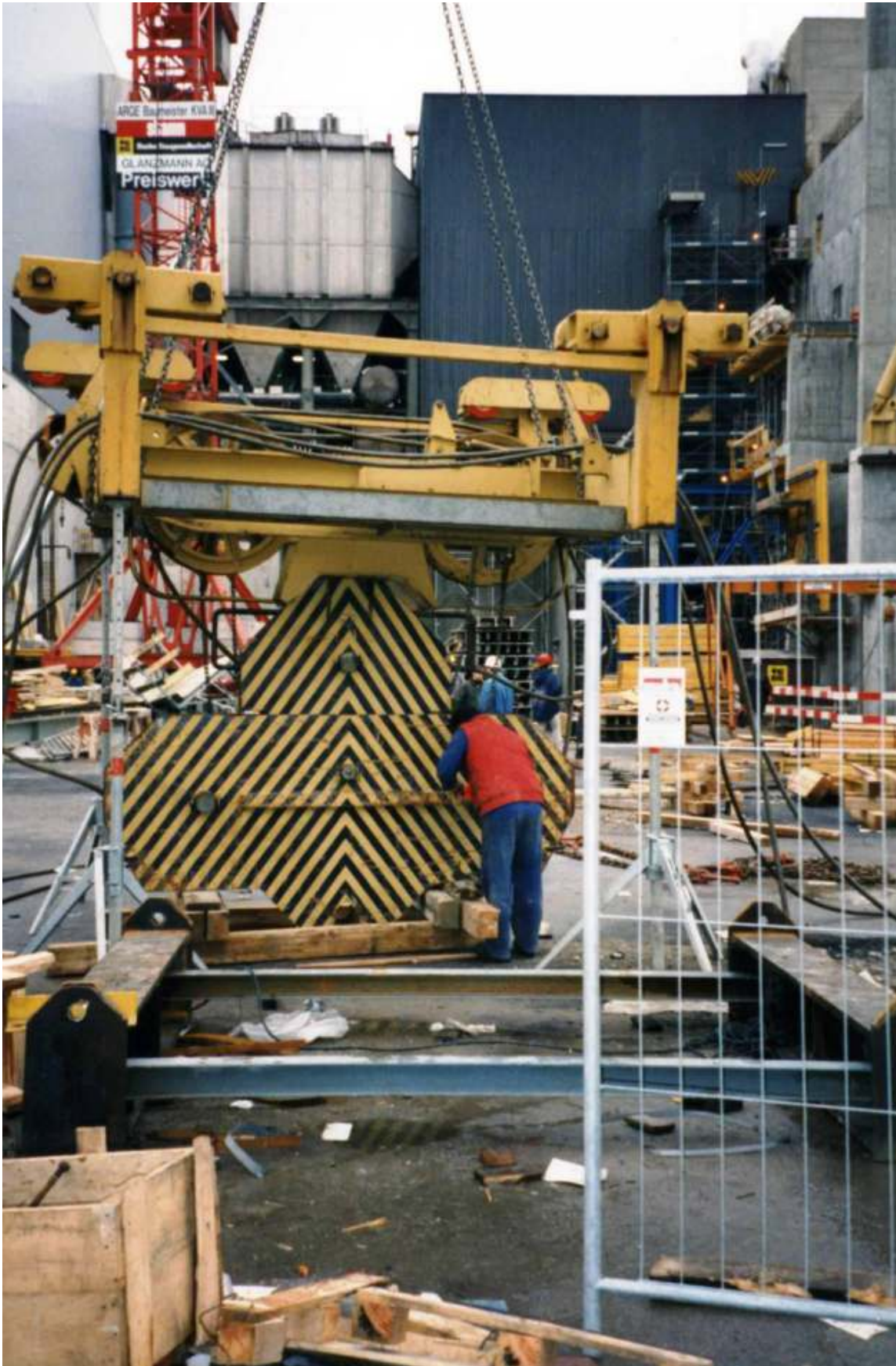
Die Laufkatze wird mit der Hakenflasche und dem Hubseil für die Montage vorbereitet
