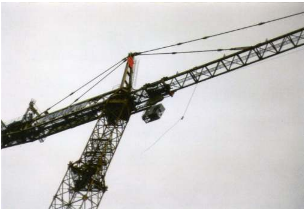
Montage des zweiten Auslegerteils in luftiger Höhe
