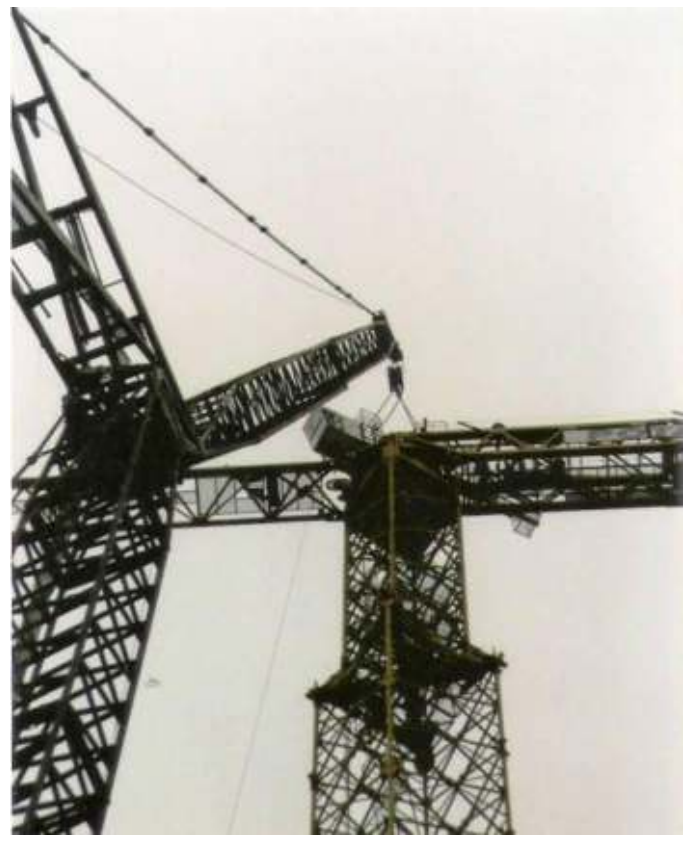
Montage der Drehbühne und Grundmontage von Gegenausleger und Grundausleger und Kabine. Fotos Urs Bähler
