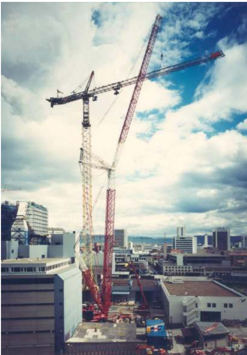
Der MD 1400 bei der Demontage mit dem Liebherr LG 1550 der RIGA Mainz
