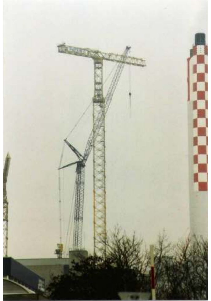
Montage der Drehbühne und Grundmontage von Gegenausleger und Grundausleger und Kabine. Fotos Urs Bähler
