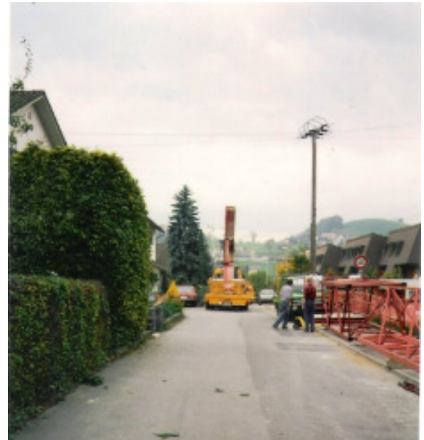
Transport Wolff Fundamentkreuz mit 350 Schrauben.....
