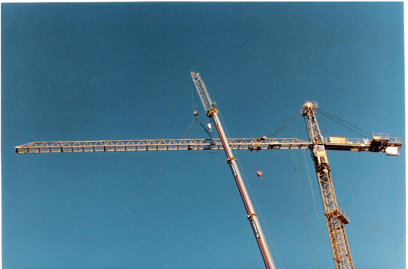
Der Ausleger wird am Mobilkran angeschlagen.
