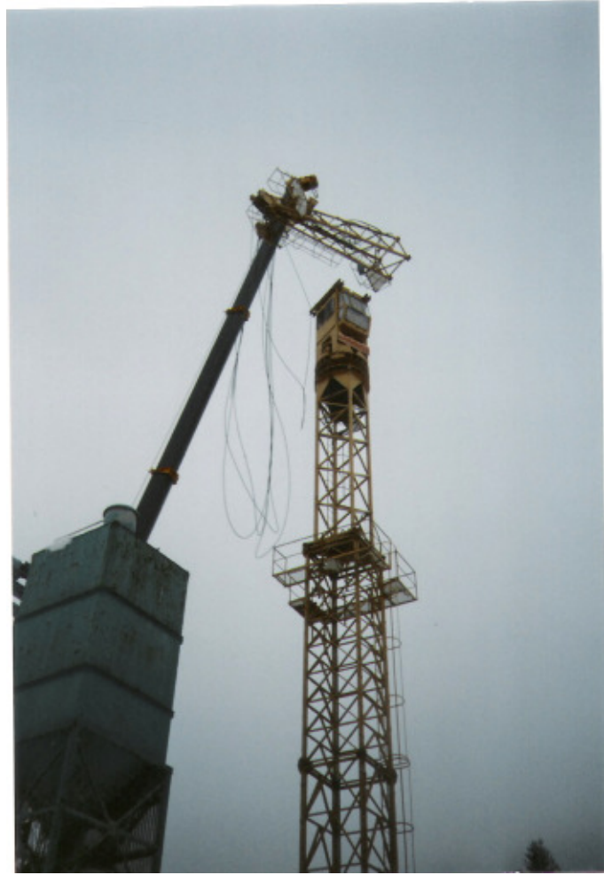
Letzte Demontage in Alptal des 90 C mit viel zu kleinem 60 t Mobilkran. Gut sichtbar sind die Auslegerabspannseile. Der Kletterturm ist ohne Kletterstück mit Übergangsrahmen ausgerüstet.
