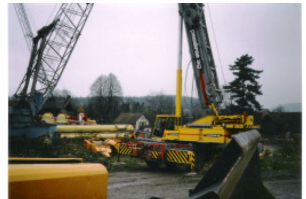
Demontage eine Peiner T Nadelauslegerkrans zur Entsorgung
