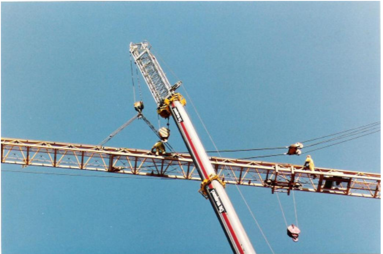
Der Ausleger wird am Mobilkran angeschlagen.
