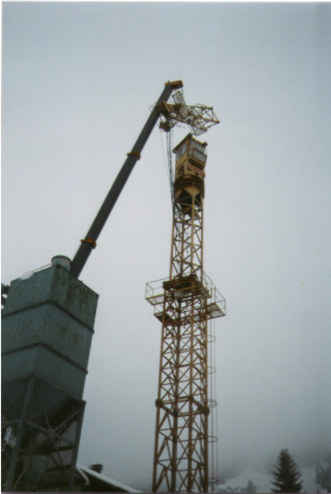
Letzte Demontage in Alptal des 90 C mit viel zu kleinem 60 t Mobilkran. Gut sichtbar sind die Auslegerabspannseile. Der Kletterturm ist ohne Kletterstück mit Übergangsrahmen ausgerüstet.
