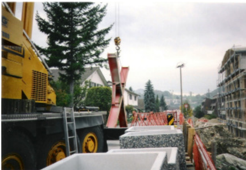
Transport Wolff Fundamentkreuz mit 350 Schrauben.....
