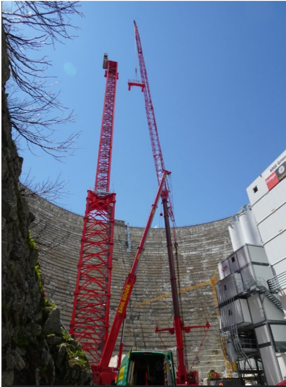
Demontage der Podeste beim Turm TV33-5:
