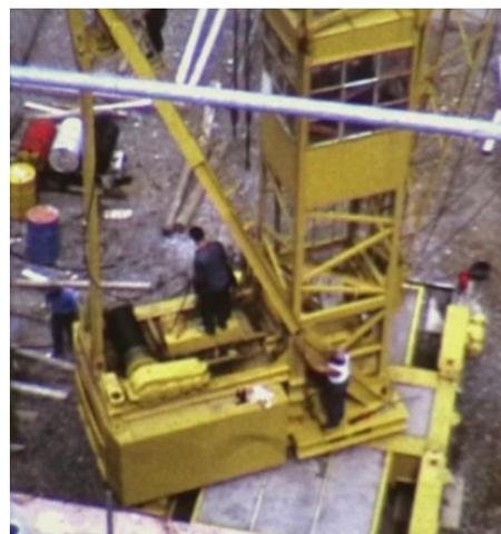
Ebenfalls mit der Hubwinde wird Turm nun komplett umgelegt. Nach dem alle Seile ausgezogen sind, der Kiesballast aus dem Ober- und Unterwagen entfernt wurde, kann der Kranturm, der Ausleger und der Unterwagen separat mittels Autokran verladen werden. Auf den nachfolgenden Zeichnungen sind die Transport Collies ersichtlich. Für das Turmpaket kommt eine Transportachse zur Anwendung.
