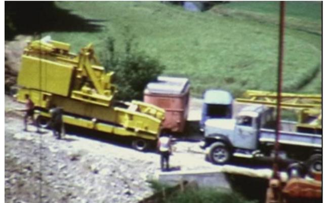
Anlieferung des auf einen Tiefgänger verladenen Unterwagens. Auf dem Motorwagen befinden sich der untere Aufrichtbock, Ballastkästen und Zubehör.
