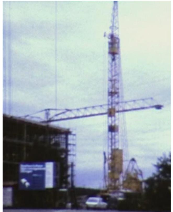
Mit dem Hubseil und der ganz nach oben gezogenen Hakenflasche wird der Ausleger gehalten. Die Auslegerverstellseile werden entlastet und am Verstellschlitten hinten am Turm gelöst. Darauf wird der Ausleger mit dem Hubseil langsam herunter gelassen.
