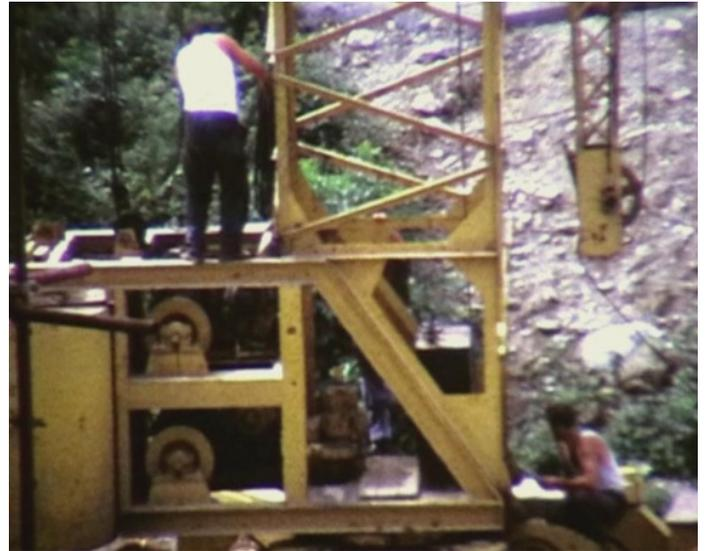
Zuerst wird der Ausleger mit der Verstellwinde abgelassen. Dann wird das Teleskopierseil auf die Hubseiltrommel aufgelegt und der Turm eintelestriert. In diesem Fall stand ein Autokran zur Verfügung, welcher die Auslegerspitze angeschlagen hat und vom Kran wegziehen konnte. Dann wird der Turm mit dem Verstellwerk umgelegt.
