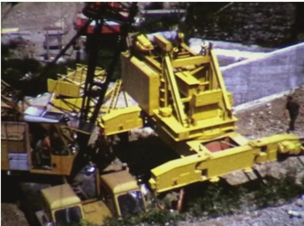
Nach der Befüllung des Unterwagens und des Gegengewichtsbehälters mit Kies, ist der Unterwagen standsicher. Die Schienenzangen werden festgezogen und die Puffer montiert. Nun wird der grosse Aufrichtbock auf dem Unterwagen montiert.
