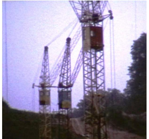
Anschliessend wird der Kran analog zur Demontage in umgekehrter Reihenfolge wieder montiert und ist nun wieder einsatzbereit. Auf dieser Baustelle in Othmarsingen standen noch zwei weitere Wolff Form 45 H im Einsatz.
