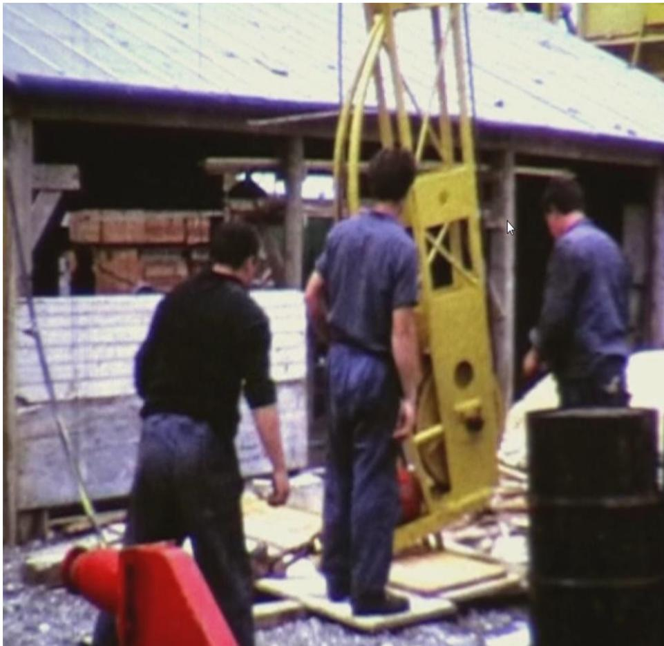
Die Seilschlösser der beiden vom Schlitten zur Auslegerspitze führenden Verstellseile werden entfernt. Die Hakenflasche wird aus der Auslegerspitze ausgeschert und wieder am Hubseil befestigt. Nun wird der Ausleger am Anlenkpunkt an dem Hubseil angeschlagen und abgelassen.
