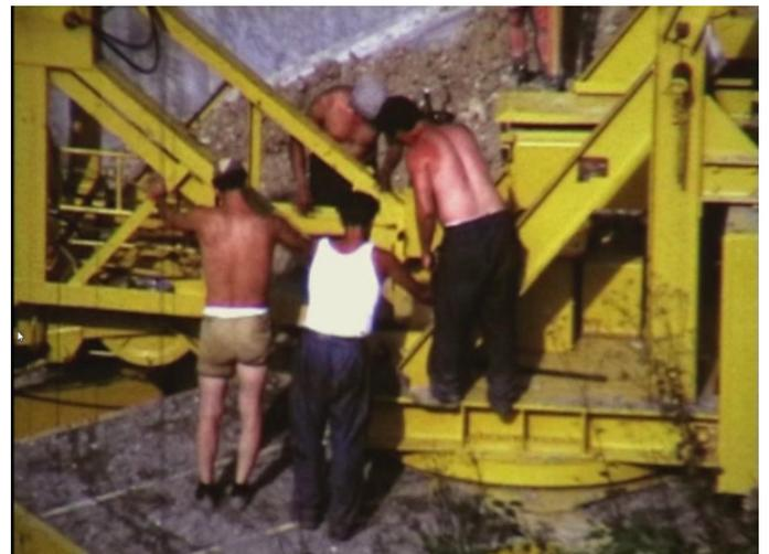
Nun wird der Schlitten am Turm montiert, die Seile eingezogen und der Turm mit der Hubwinde aufgestellt.
