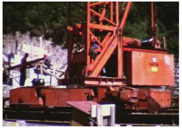
Anschliessend wurde auf der gleichen Baustelle ein Liebherr Nadelauslegerkran vom Typ Form 25 A umgestellt. Die Konstruktionsunterschiede des Wolff und des Liebherrkrans sind augenfällig. So wird beim Liebherr der Turm teleskopiert und der Kran als Ganzes mit einer Transportachse transportiert. Die wegweisende Konstruktion aus dem Jahre 1954 verfügte als erstes Gerät dieser Klasse über einen teleskopierbaren Turm, Spreizholme und Kugeldrehkranz.
