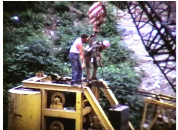
Nachdem der Ausleger und der Kiesballast entfernt wurde, kann die Turmspitze auf dem LKW mittels Drehschemmel fixiert werden. Der Unterwagen wird nun mit dem Autokran angeschlagen und vom Gleis weggehoben. Nun kann die Transportachse montiert werden. Der Ausleger wird für den internen Transport auf den Kranturm gelegt.
