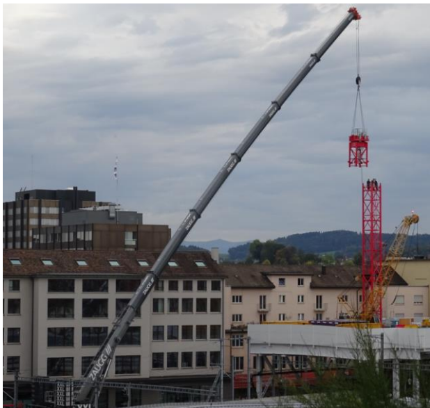
Anschliessend wird der Drehkranz auf den Turm gehoben und verbolzt.
