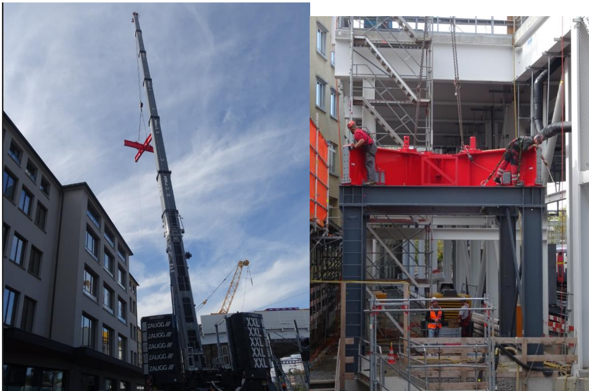
wieder über die angrenzende Häuserzeile heben und auf dem Portal absetzen.
