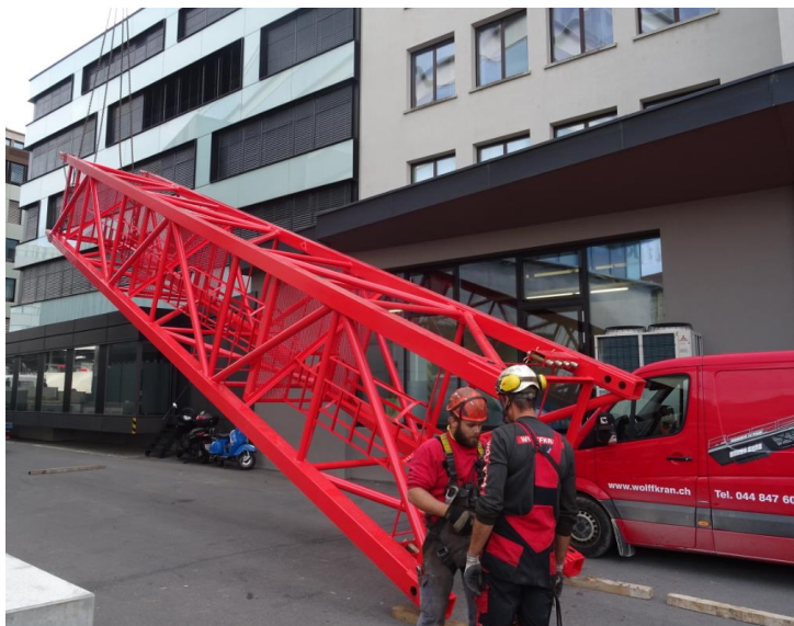
Setzen von 14 Paaren Gewichtsstangen (3,7t pro Stange) für den Zentralballast und Aufstellen des zweiten Segmentes (1 Element a 13,5m).
