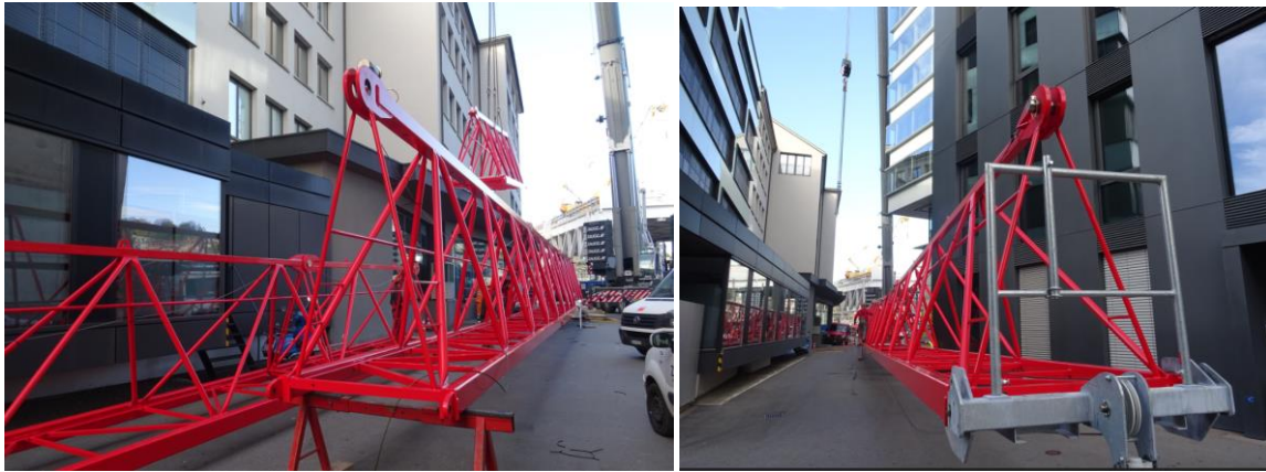
Zusammensetzen des 55m langen Auslegers in den engen Platzverhältnissen des Merkurgässlis.
