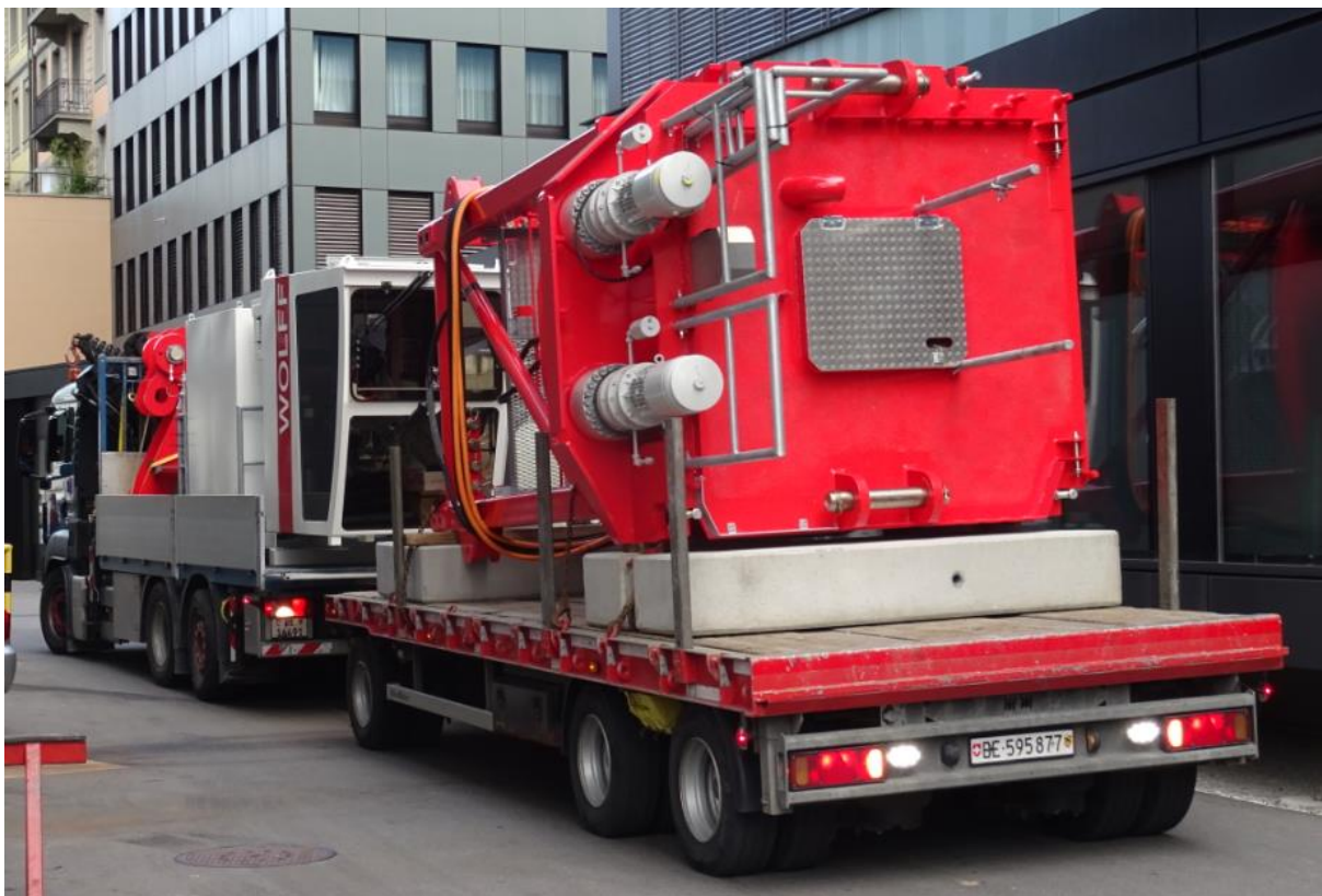
Anlieferung Drehkranz (König); 9,82t, Turmspitzenoberteil (A-Bock); 1,837t und Führerhausstation; 2,83t.
