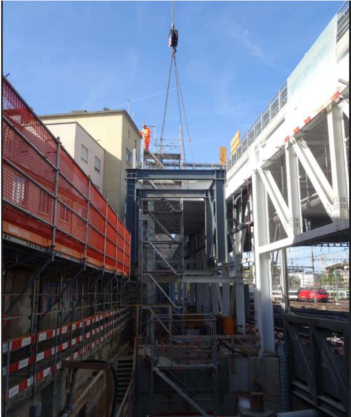
Absetzen des Portals auf der gegenüberliegenden Seite des Schachtes zum Bau des RBS-Tiefbahnhofes.
