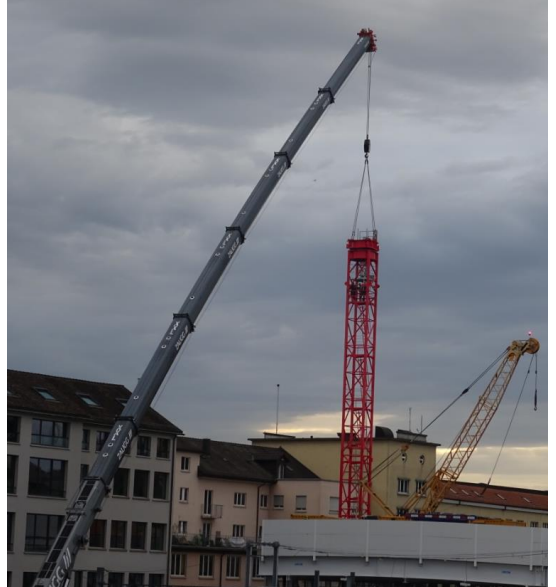
Anschliessend wird der Drehkranz auf den Turm gehoben und verbolzt.
