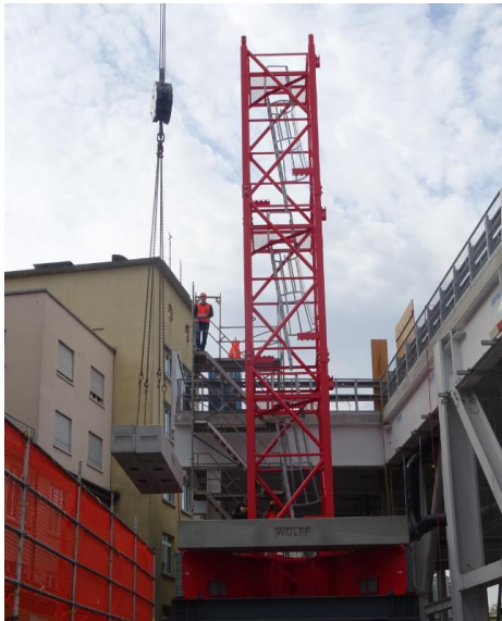
Setzen von 14 Paaren Gewichtsstangen (3,7t pro Stange) für den Zentralballast und Aufstellen des zweiten Segmentes (1 Element a 13,5m).
