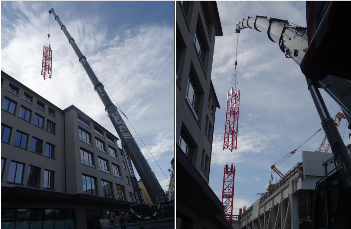
Wieder über die Häuserzeile schwenken und auf der anderen Seite mit 55m Ausladung absenken.
