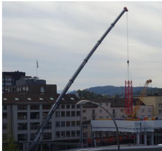
Platzverhältnisse im Merkgässli neben der Welle 7, Montage des ersten 3-er Segmentes
