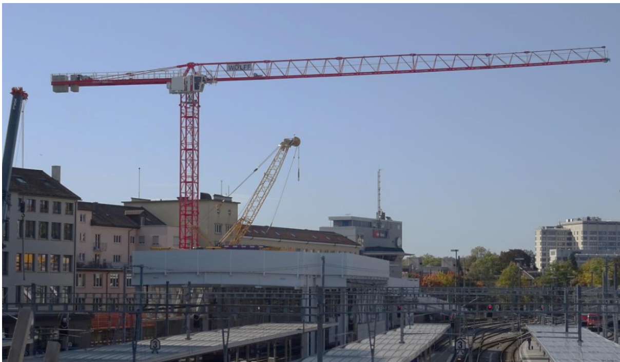
Die Montagearbeiten mit dem Mobilkran war am Mittag beendet. Es folgten noch das Einziehen des Hubseils, die Einstellung der Elektronik inklusive der Überlastsicherung und der Arbeitsbereichsbegrenzung.
