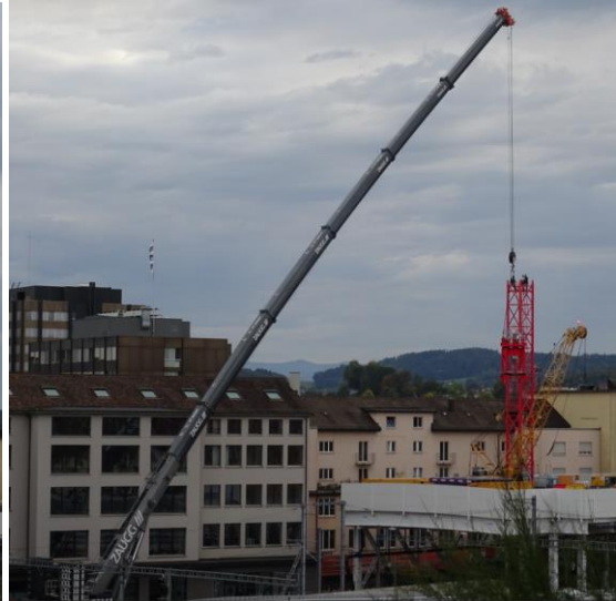
Der Drehkranz wird angehoben, zur Plattform gebracht, um das elektrische Kabel anzuschliessen.
