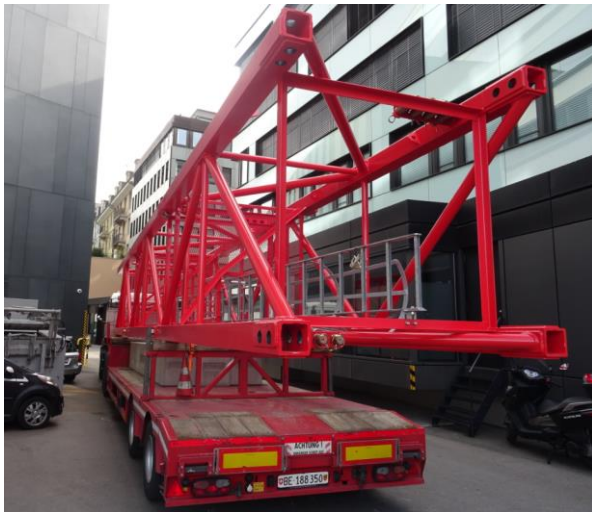
Platzverhältnisse im Merkgässli neben der Welle 7, Montage des ersten 3-er Segmentes
