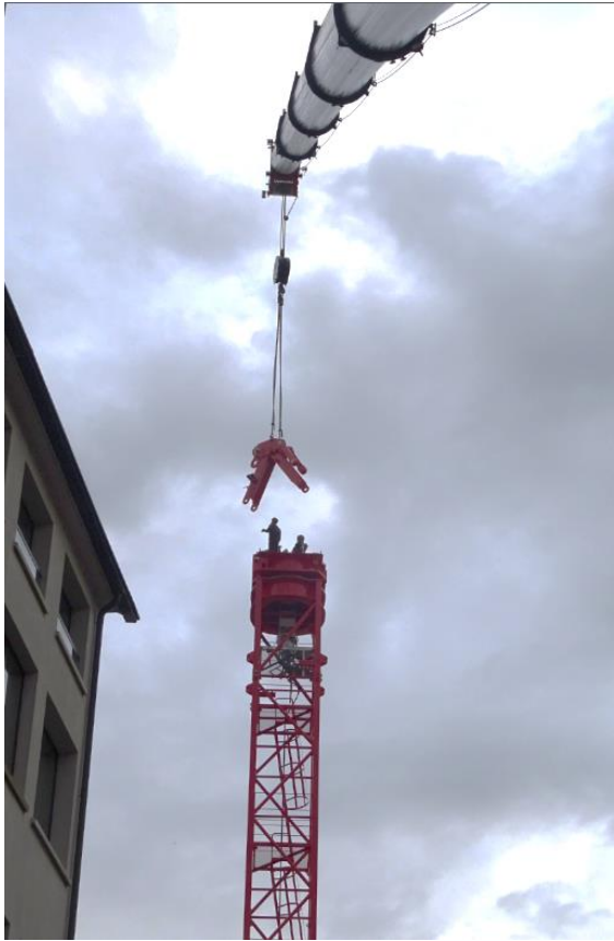
Montage des Turmspitzenoberteils (A-Bock), linkes Bild und der Führerhausstation, rechtes Bild.
