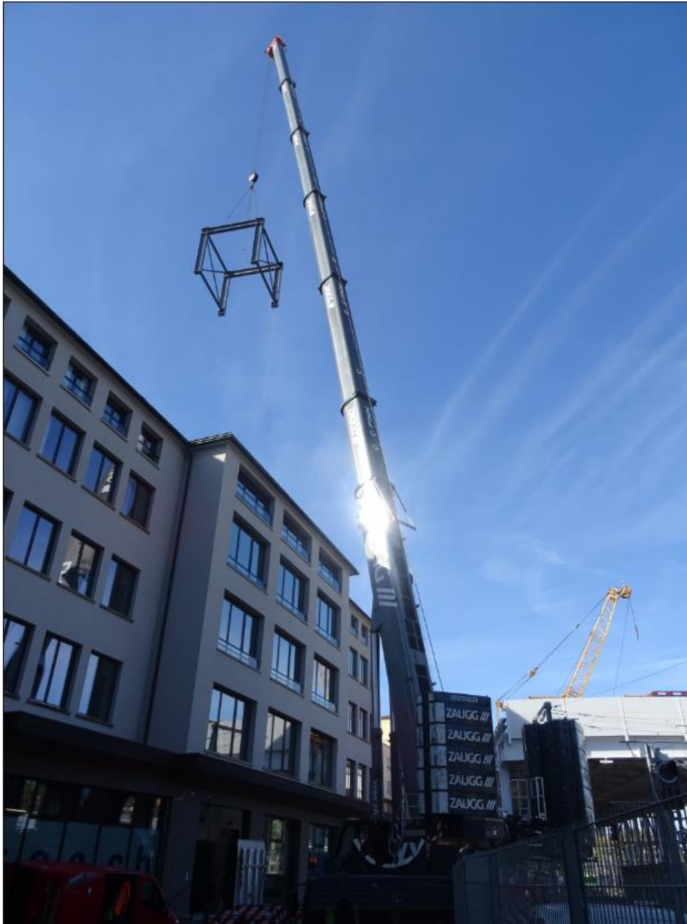
Heben des Portals und Überschwenken der anliegenden Häuserzeile.
