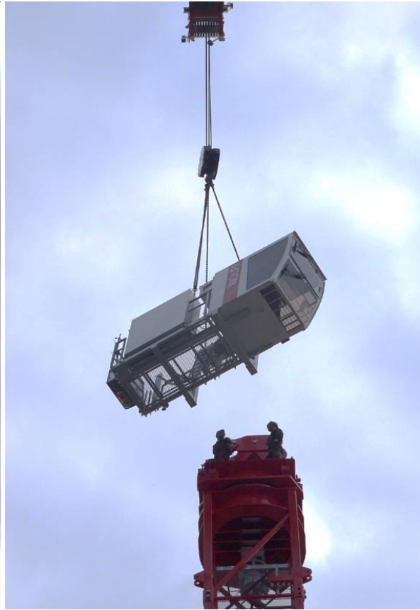
Montage des Turmspitzenoberteils (A-Bock), linkes Bild und der Führerhausstation, rechtes Bild.
