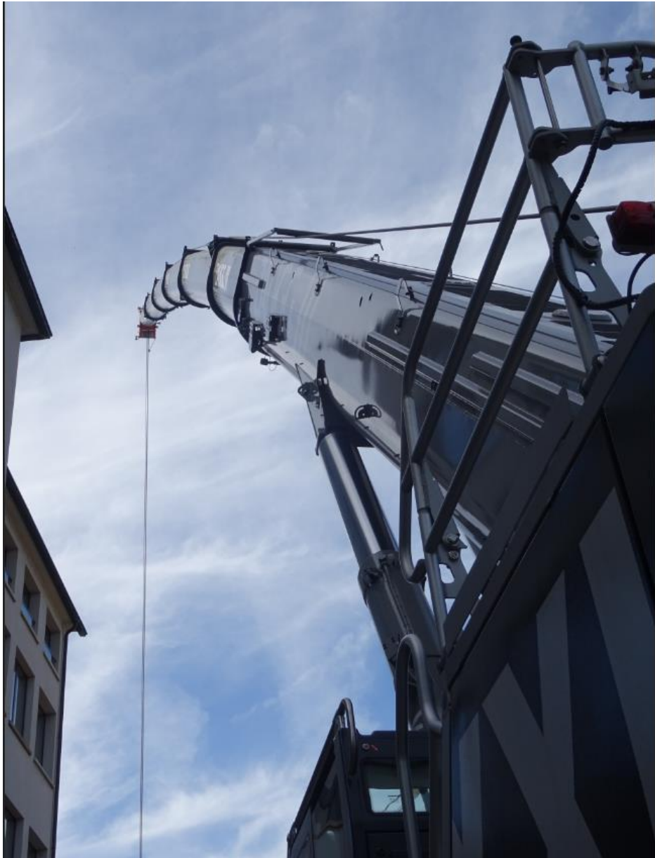
Der Ausleger des Mobilkrans wurde dabei ziemlich stark belastet.
