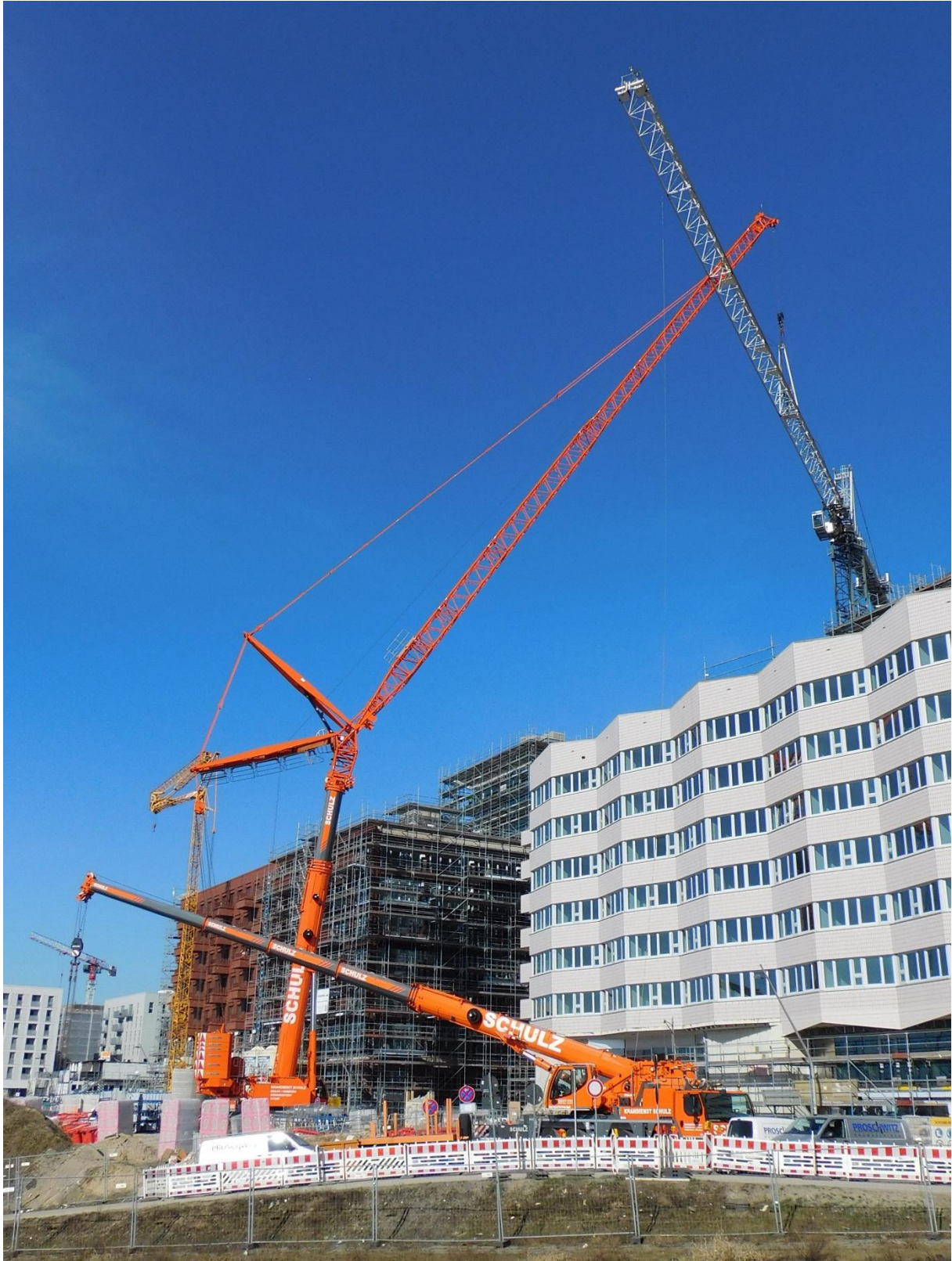
Demontage des Peiner SK 415 Baustelle Hafen City in Hamburg. Fotos Jens Ode
