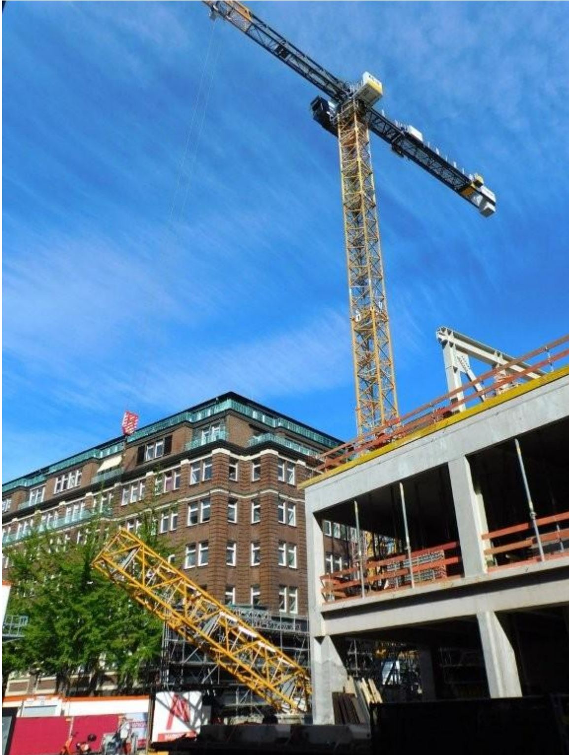
Aufstellen und montieren von 15 m Turm des Systems 16HC175
