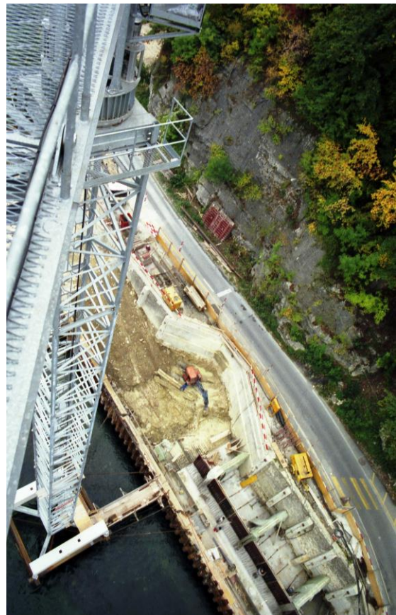
Die ganze Krankonstruktion wurde im Vollbad feuerverzinkt und so für ca. 25 Jahre gegen Rosteinfluss geschützt
