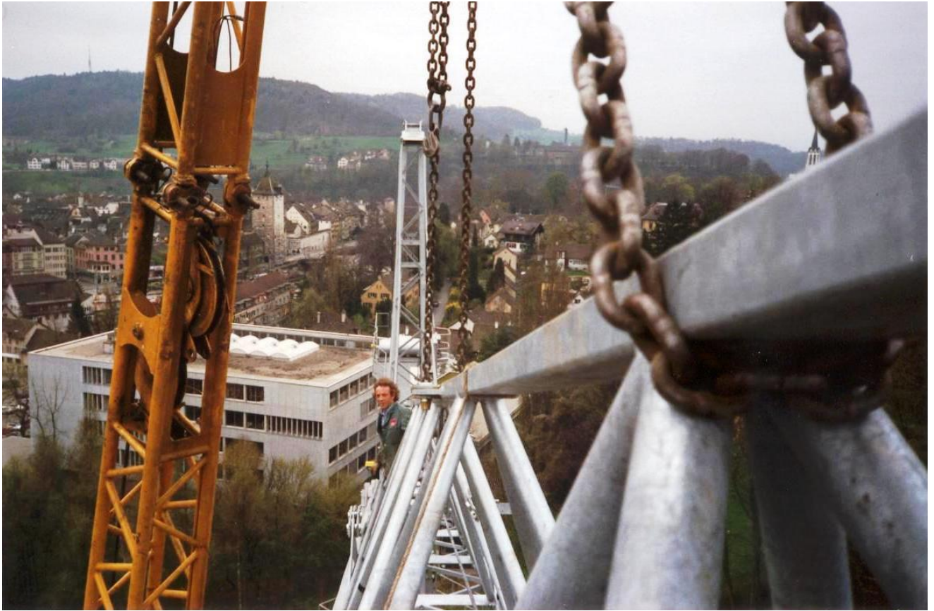
Auslegermontage an einem TKF 1205 in Schaffhausen. Foto Rolf Müller
