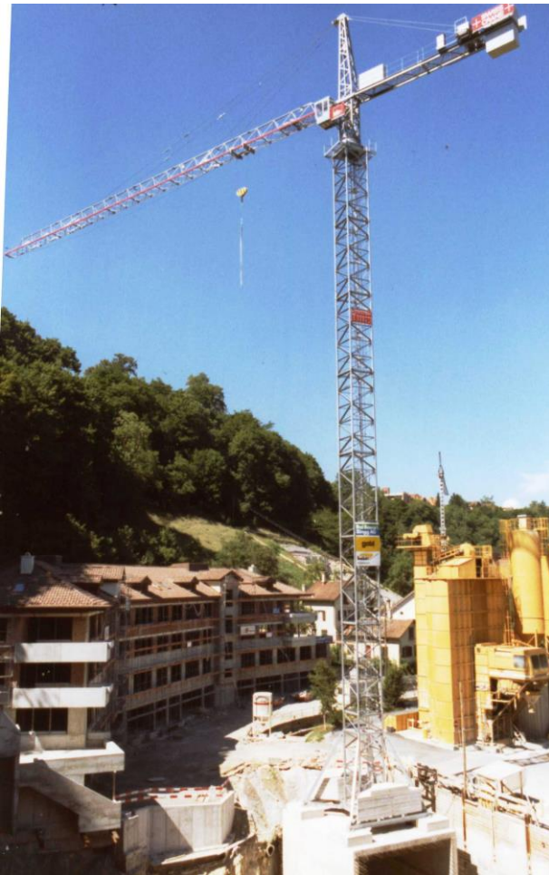
TKF 1205 mit 52 m Hakenhöhe in Schaffhausen, montiert auf stationärem Unterwagen
