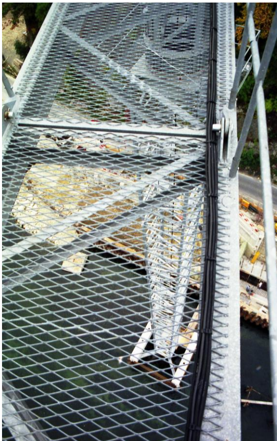
Die ganze Krankonstruktion wurde im Vollbad feuerverzinkt und so für ca. 25 Jahre gegen Rosteinfluss geschützt
