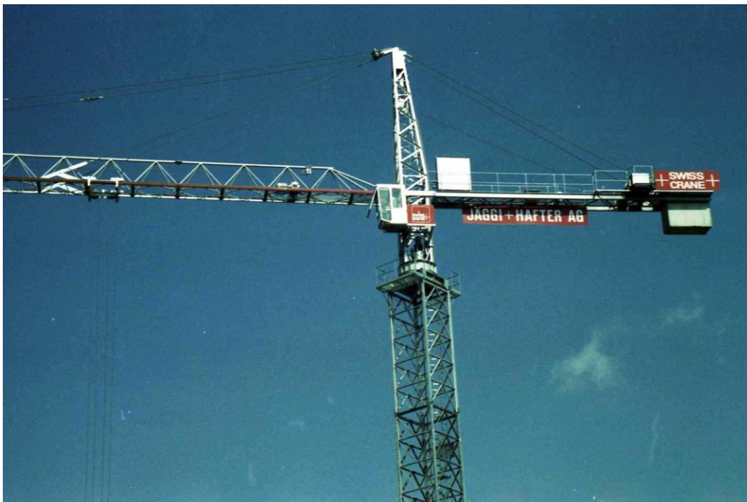
SWISS-CRANE TKF 1200 umgebaut auf Monotower System ohne Kletterturm. Das Hubwerk mit 35 PS Leistung hob 8 t im Vierstrangbetrieb. Durch den Hersteller ausgeführte Werkrevision auf Statovar Steuerung für stufenloses Heben
