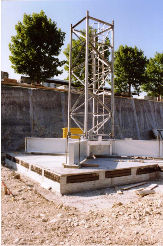
Verbolztes Fundamentkreuz mit Turmanschlüssen für Turmsystem 805 und 1205
