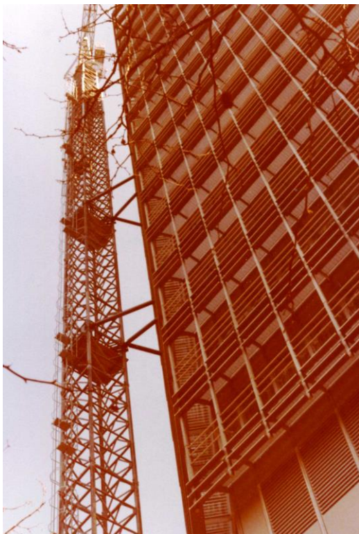
SWISS-CRANE TKF 1200 beim Herunterklettern 1980 nach Rohbauende auf der Baustelle des Migros Hochhauses in Zürich am Limmatplatz. Zur Demontage der Turmhälften wurden Hilfsrollen angebracht, da der Kran wegen dem Gebäude nicht mehr frei drehbar war.
