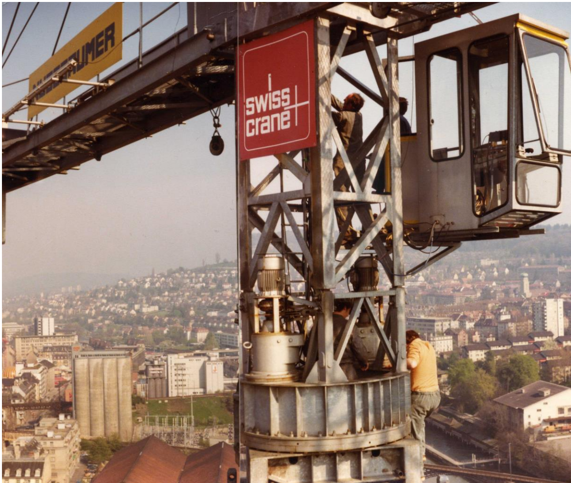
SWISS-CRANE TKF 1200 beim Herunterklettern 1980 nach Rohbauende auf der Baustelle des Migros Hochhauses in Zürich am Limmatplatz. Zur Demontage der Turmhälften wurden Hilfsrollen angebracht, da der Kran wegen dem Gebäude nicht mehr frei drehbar war.
