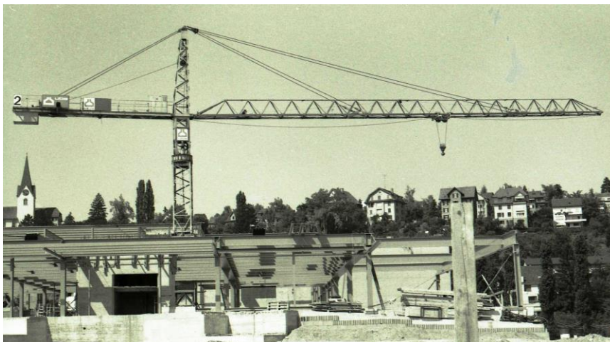
SWISS-CRANE TKF 1200 Baujahr 1967 mit Turminnenkabine. Mit dem 60 + 8 PS Hubwerk konnten 8 t zweisträngig gehoben werden. Die max. Ausladung auf dem Foto beträgt 40 m.
