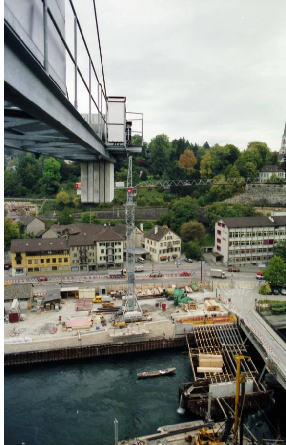
Laufkatze für 16 t Tragkraft, hier ohne Zwischenflasche eingesetzt, im Betrieb für eine max. Tragkraft von 8 t im zweisträngigen Betrieb der Unterflasche
