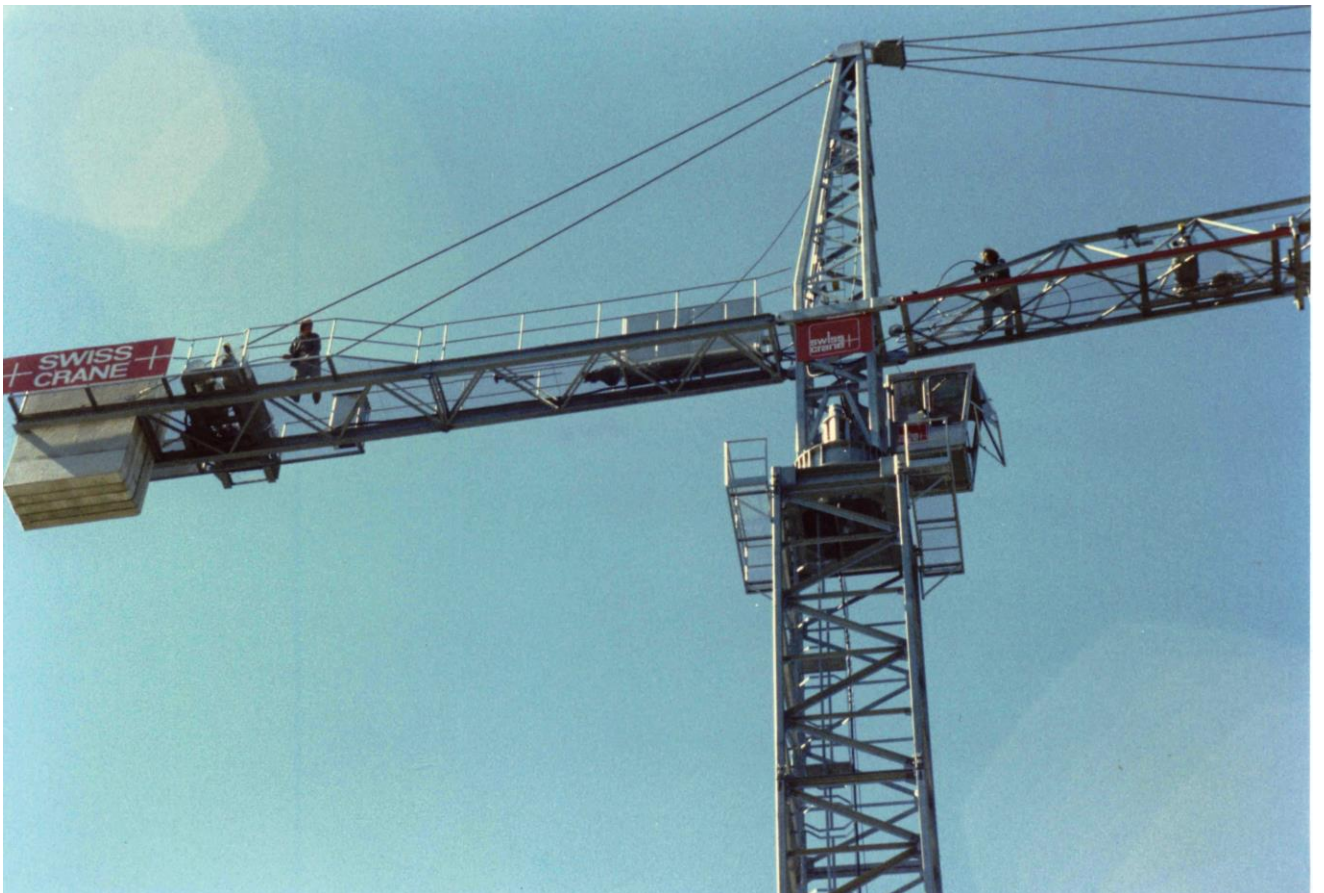
Das zur Montage mit Achterschlingen auf dem Auslegeranlenkstück deponierte Hubseil wurde eingeschert
