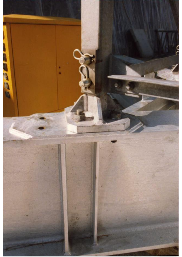
Verbolztes Fundamentkreuz mit Turmanschlüssen für Turmsystem 805 und 1205
