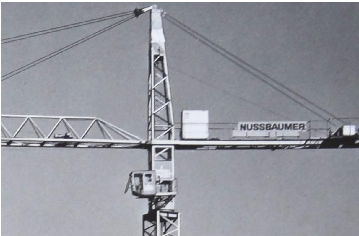
1970 – 1971, Engelking Aussenkabine, die Kranbedienung war nur im Sitzen möglich
