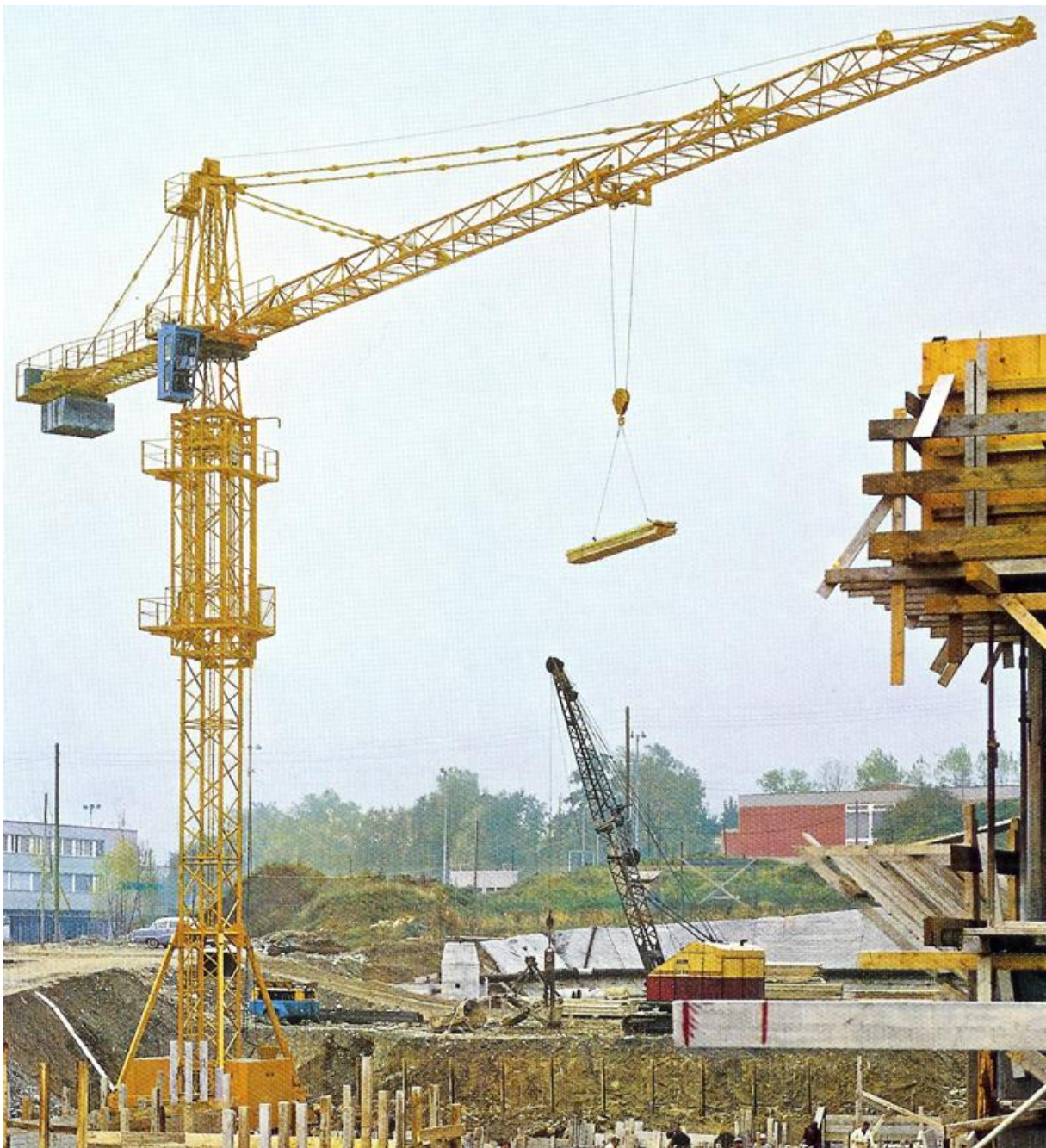
Wolff WK 60 S, Baujahr 1964 mit Rollendrehkranz, Baustelle Triemli Spital Zürich, Firma Spaltenstein. Der erste WK 60 S in der Schweiz
